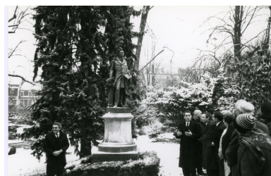
Inauguration du monument Repro. François Fouger IVR82_20067300159NUCB
