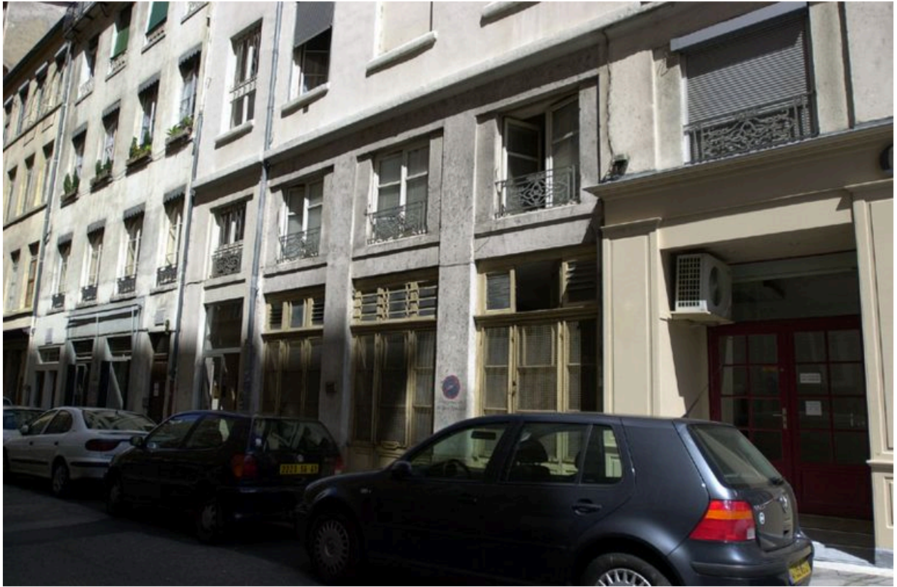
Façade sur rue, vue générale du rez-de chaussée
