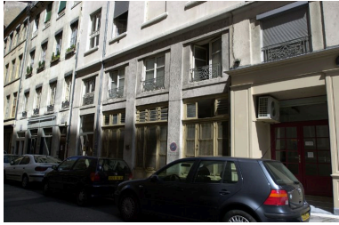
Façade sur rue, vue générale du rez-de chaussée Phot. Véronique Belle IVR82_20056901074NUCA
