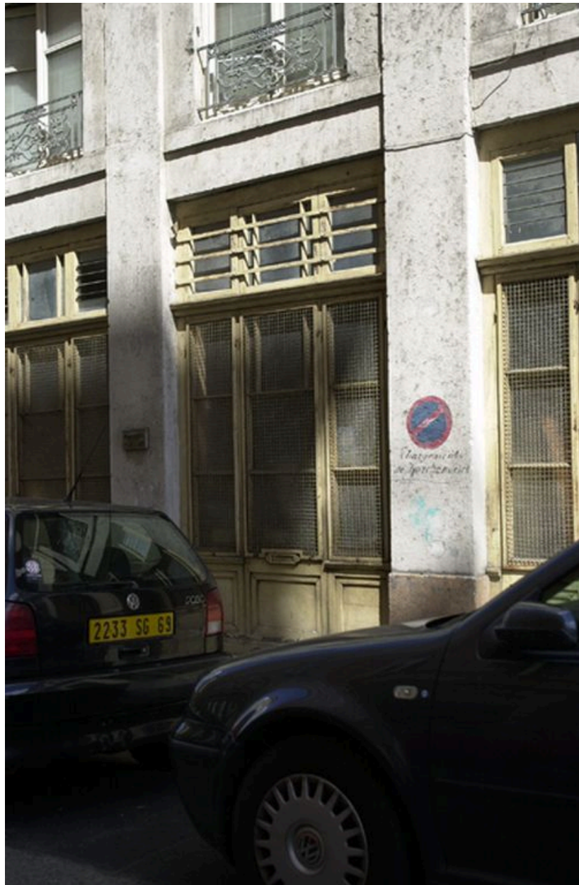
Façade sur rue, détail d'une ouverture de boutique ou d'atelier
