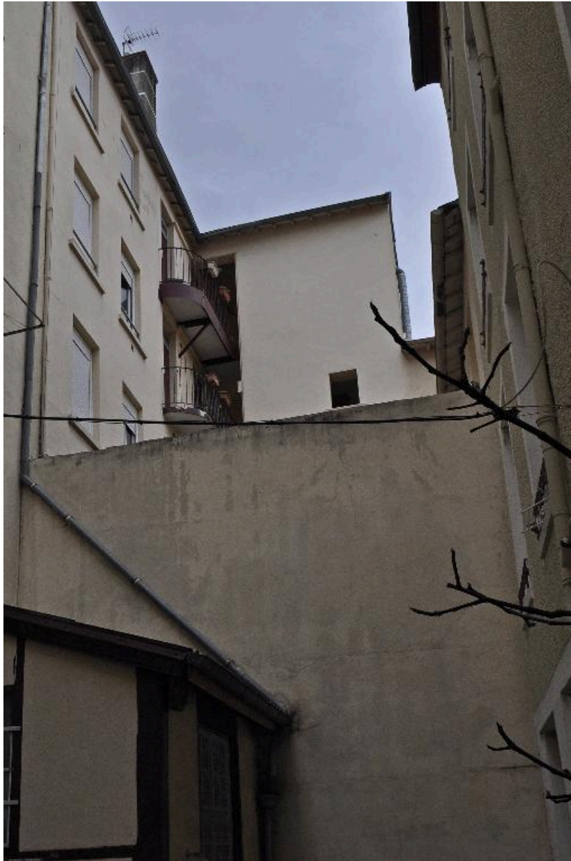
Immeuble sur rue (façade postérieure) et escalier hors-oeuvre
