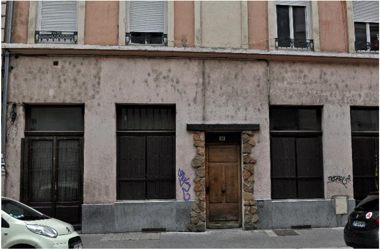
Immeuble sur rue, détail du rez-de-chaussée
