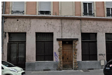
Immeuble sur rue, détail du rez-de-chaussée Phot. Magali Delavenne IVR84_20166902089NUCA
