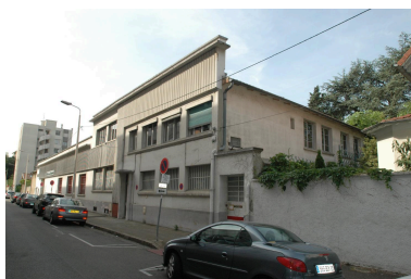
Vue du pignon latéral (parcelle 44) Phot. Nadine Halitim-Dubois IVR84_20186901440NUCA
