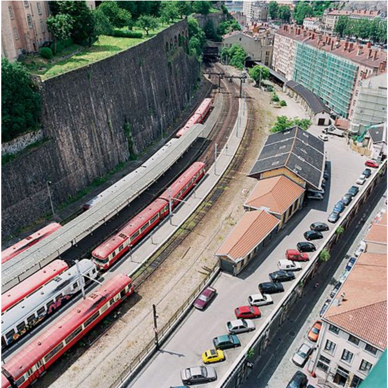
Vue générale des quais et des entrepôts
