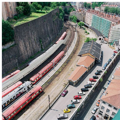
Vue générale des quais et des entrepôts Phot. Eric Dessert IVR82_20046901187XE
