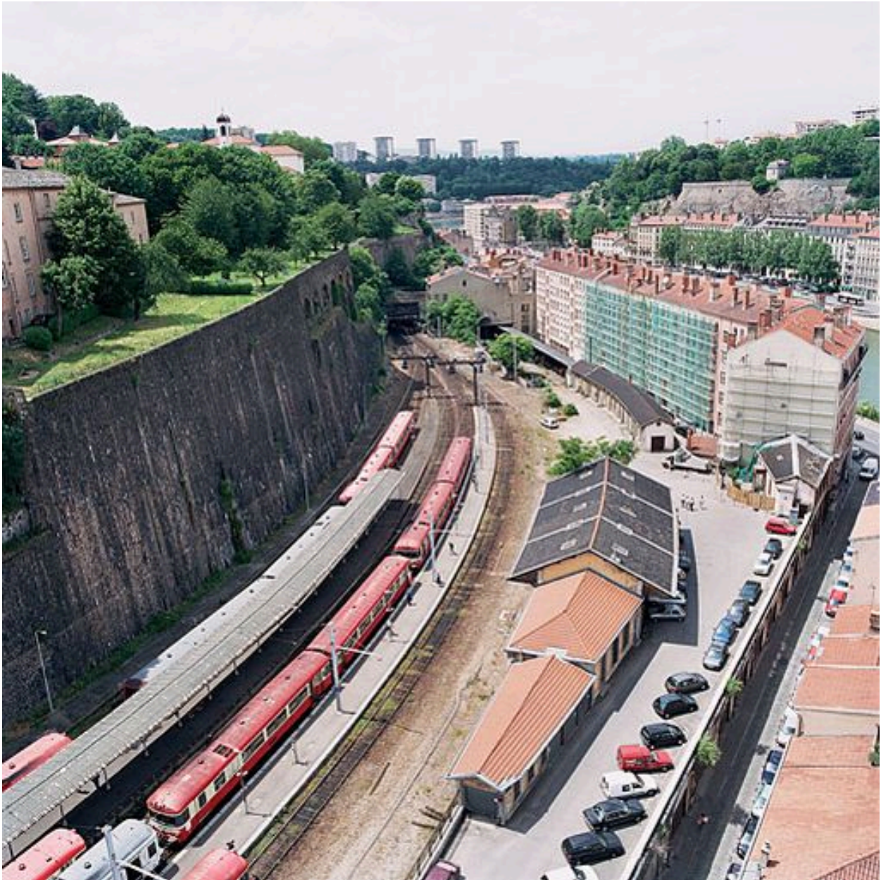
Vue générale des quais et des entrepôts
