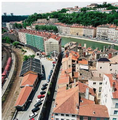
Vue générale des entrepôts Phot. Eric Dessert IVR82_20046901206XE
