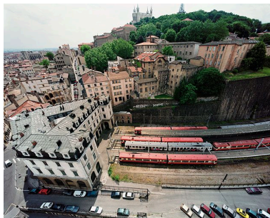
Vue générale de la gare et de la colline de Fourvière Phot. Eric Dessert IVR82_20046901214VE
