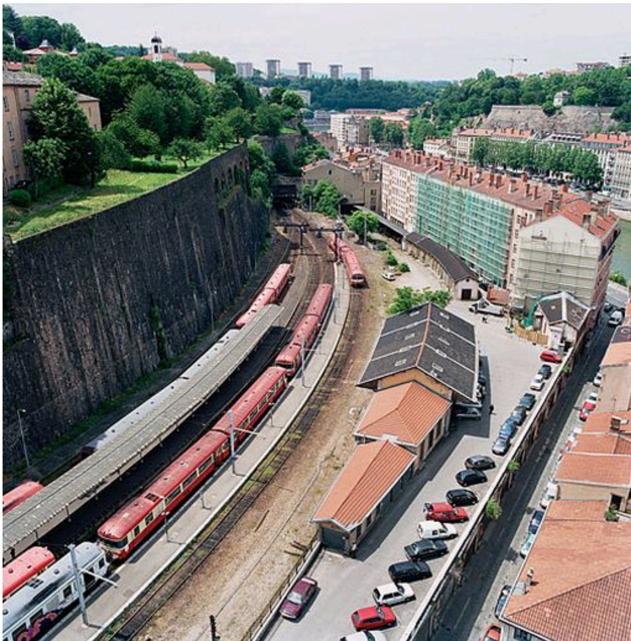
Vue générale des quais et des entrepôts
