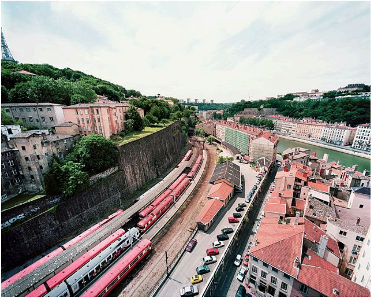
Vue générale des quais et des entrepôts
