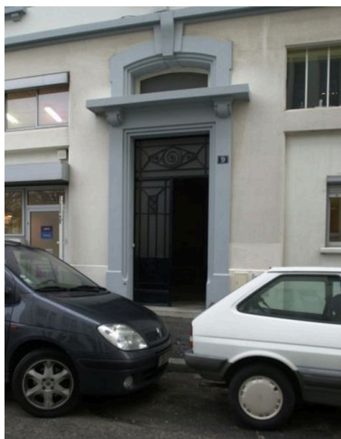
Porte d'entrée Phot. Maryannick Chalabi IVR82_20046903238NUCA
