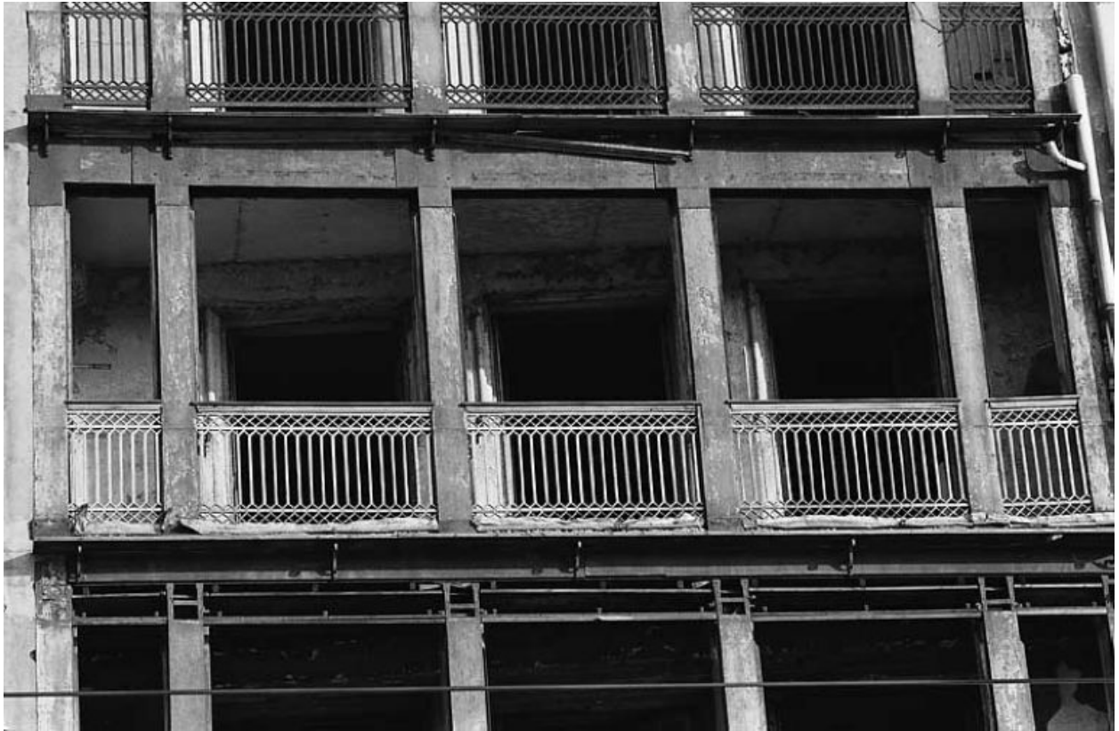
Façade sur le quai, détail de la loggia du 4e étage
