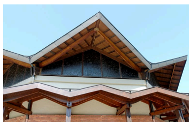
Vue de la charpente en lamellé-collé et des baies triangulaires en verre armé Phot. Maryannick Chalabi IVR82_20096900818NUCA
