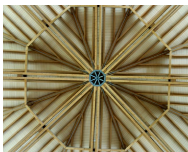
Vue de la charpente de la nef, détail central Phot. Maryannick Chalabi IVR82_20096900827NUCA
