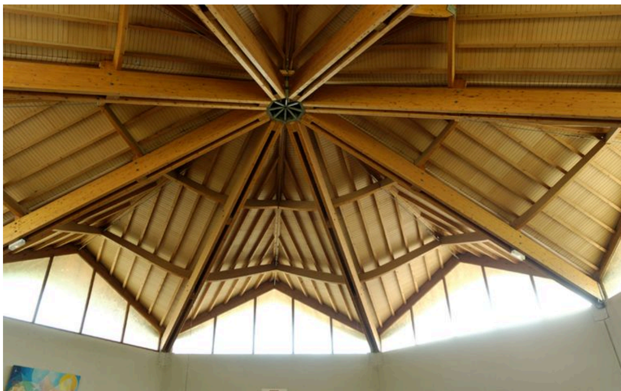
Vue générale de la charpente de la nef (lamellé-collé)
