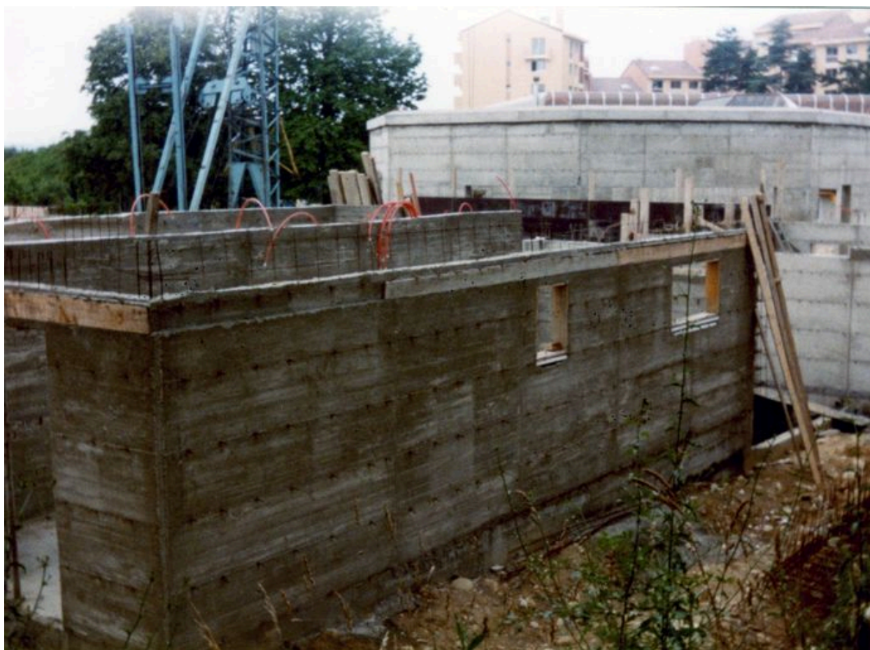
Eglise Saint-François-d'Assise, construction du presbytère
