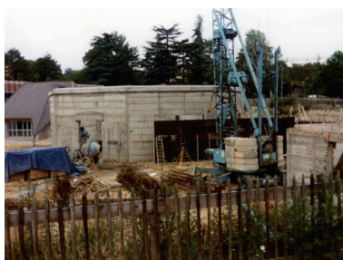
Eglise Saint-François- d'Assise, construction de la nef Repro. Maryannick Chalabi IVR82_20096900903NUCA
