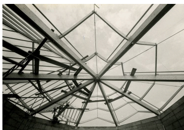
Pose de la charpente vue depuis la nef Repro. Maryannick Chalabi IVR82_20096900909NUCA
