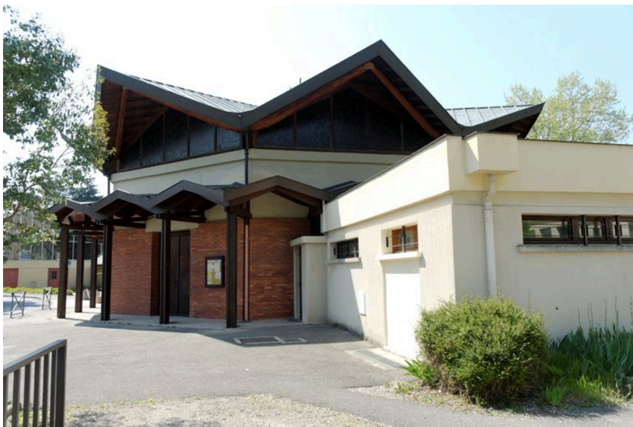
Vue générale de la chapelle mortuaire et de l'église depuis le sud-est
