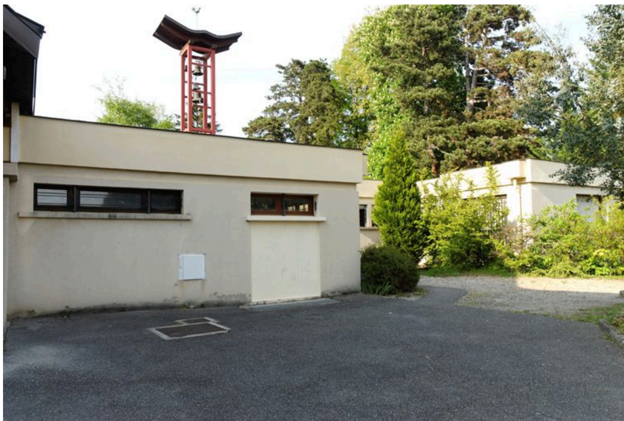
Vue générale depuis le sud. On voit l'ancienne porte d'accès à la chapelle mortuaire aujourd'hui murée
