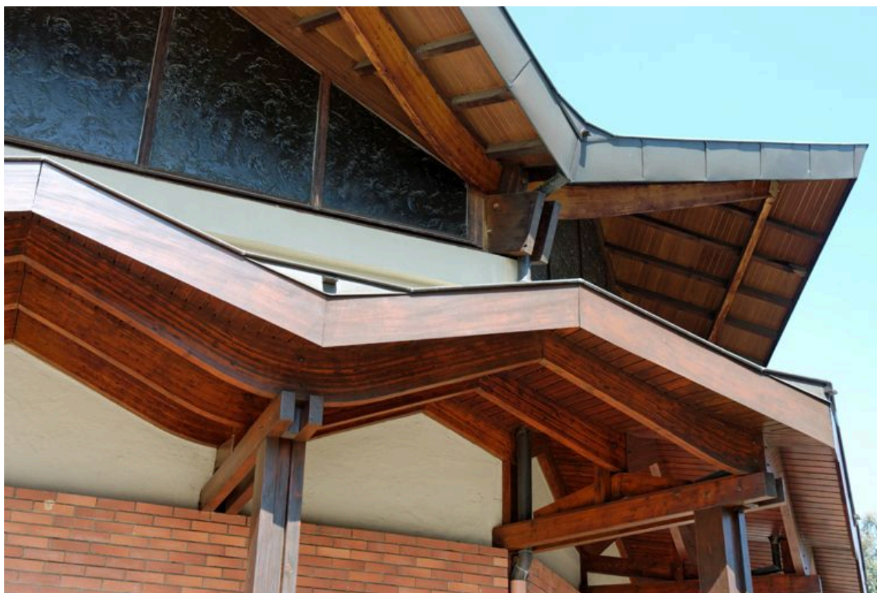
Détail de la charpente du passage couvert en lamellé-collé
