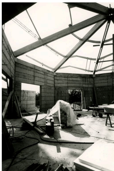
Vue de la nef, pose de la charpente en cours Repro. Maryannick Chalabi IVR82_20096900906NUCA
