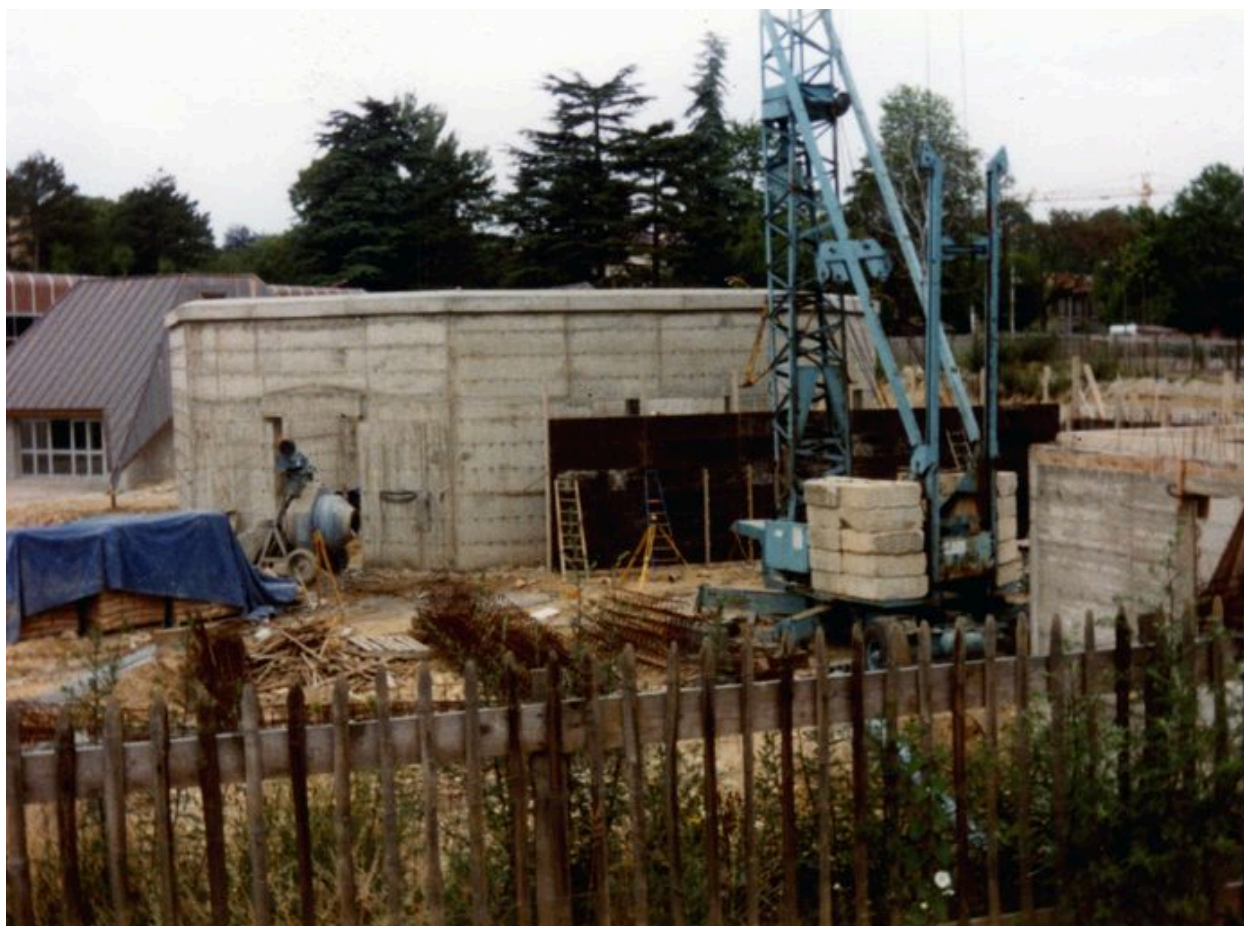
Eglise Saint-François-d'Assise, construction de la nef
