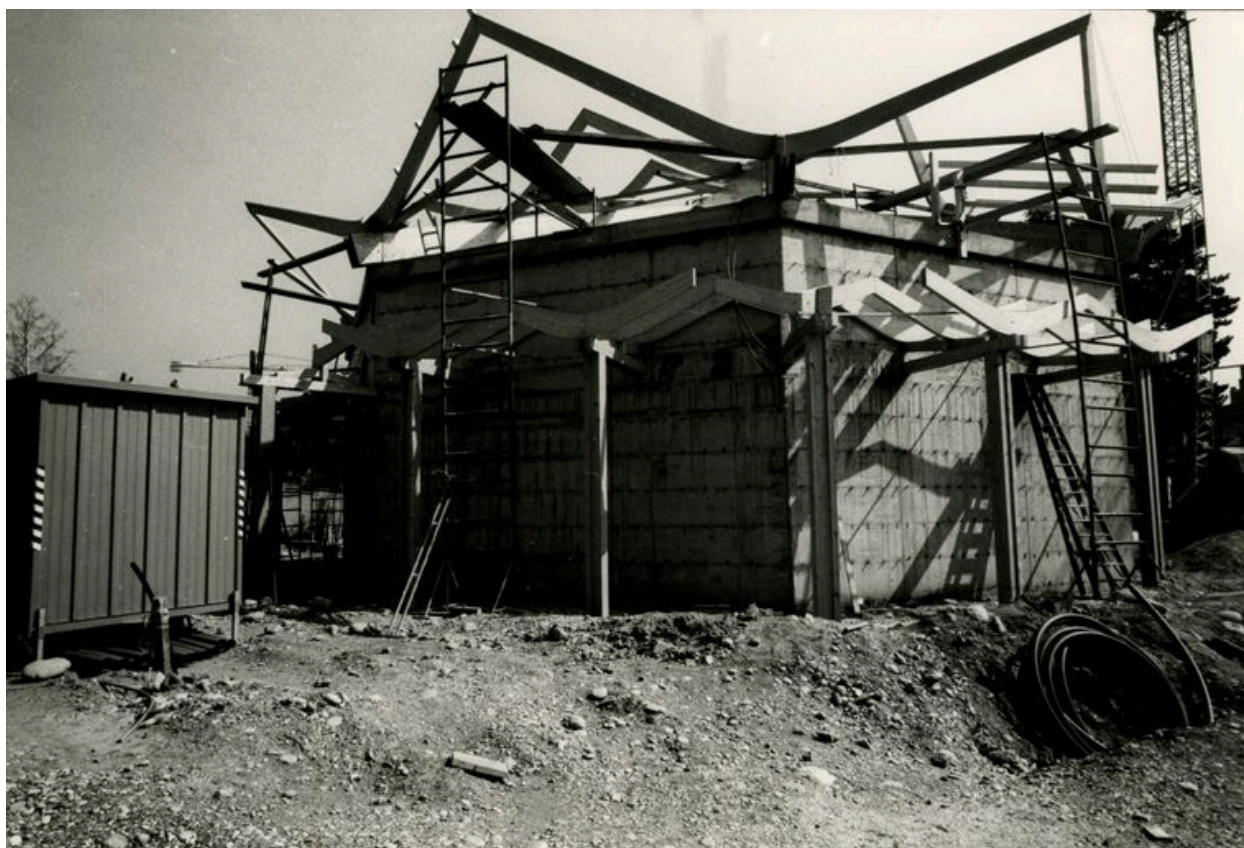
Eglise, pose de la charpente
