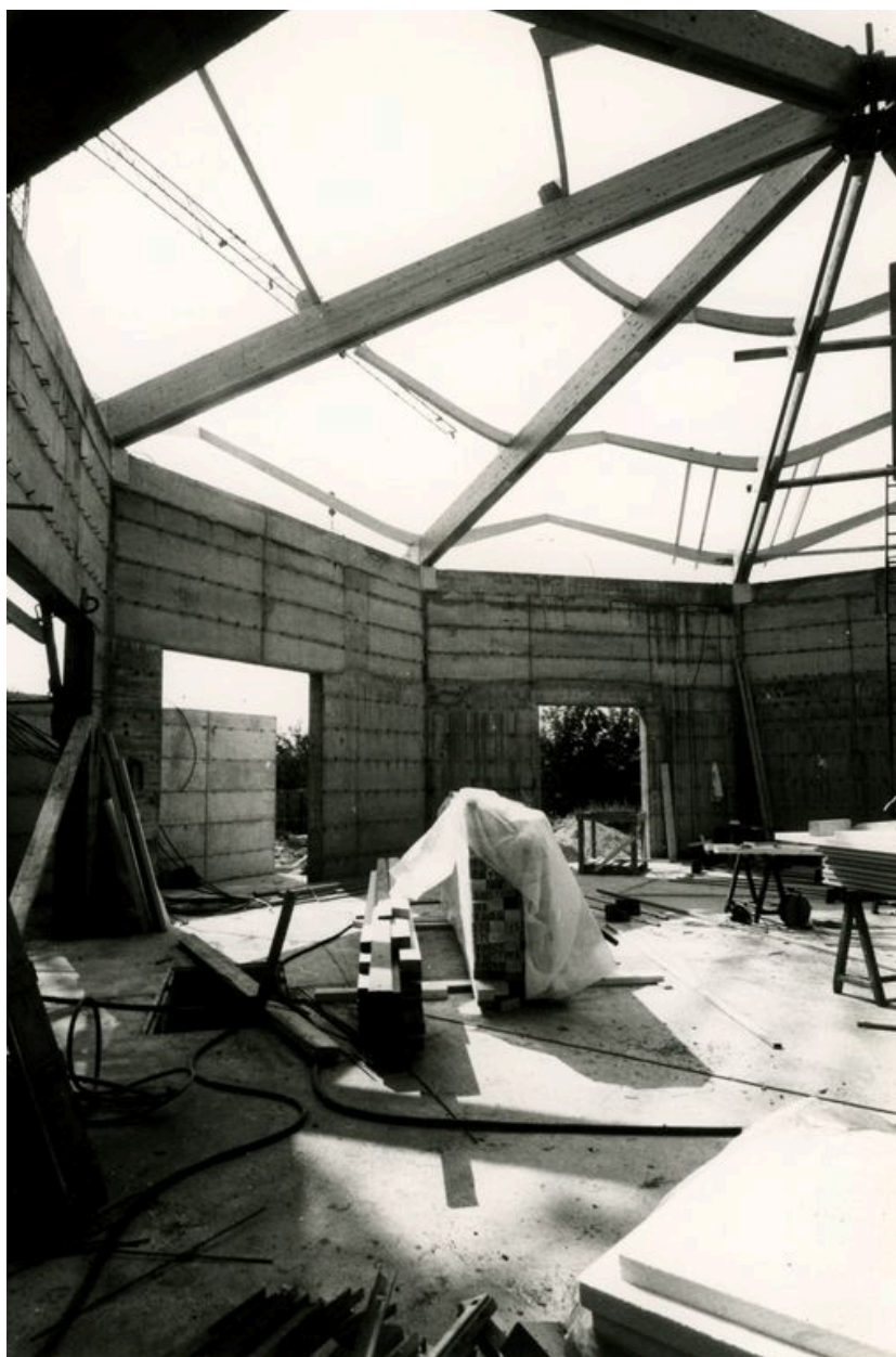
Vue de la nef, pose de la charpente en cours
