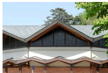
Vue générale du couvrement et du passage couvert Phot. Maryannick Chalabi IVR82_20096900817NUCA
