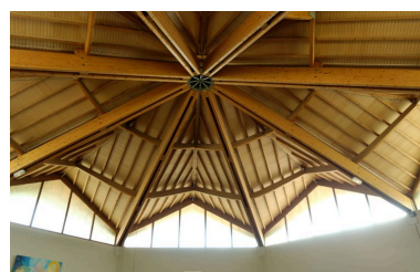
Vue générale de la charpente de la nef (lamellé-collé) Phot. Maryannick Chalabi IVR82_20096900826NUCA
