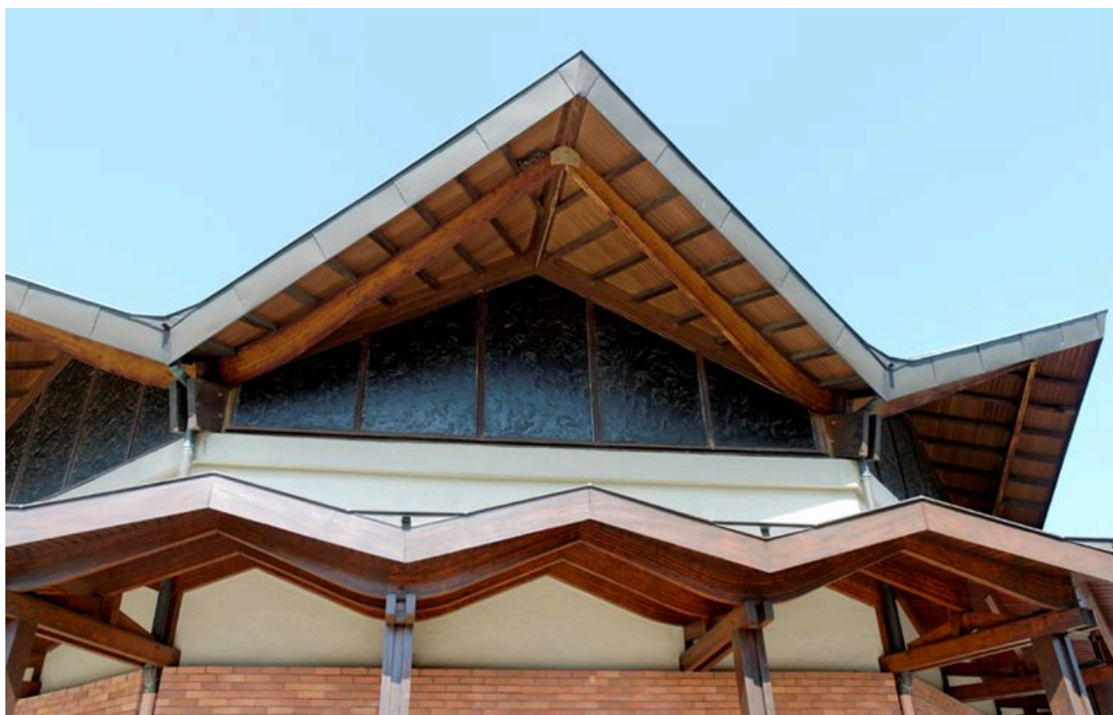
Vue de la charpente en lamellé-collé et des baies triangulaires en verre armé
