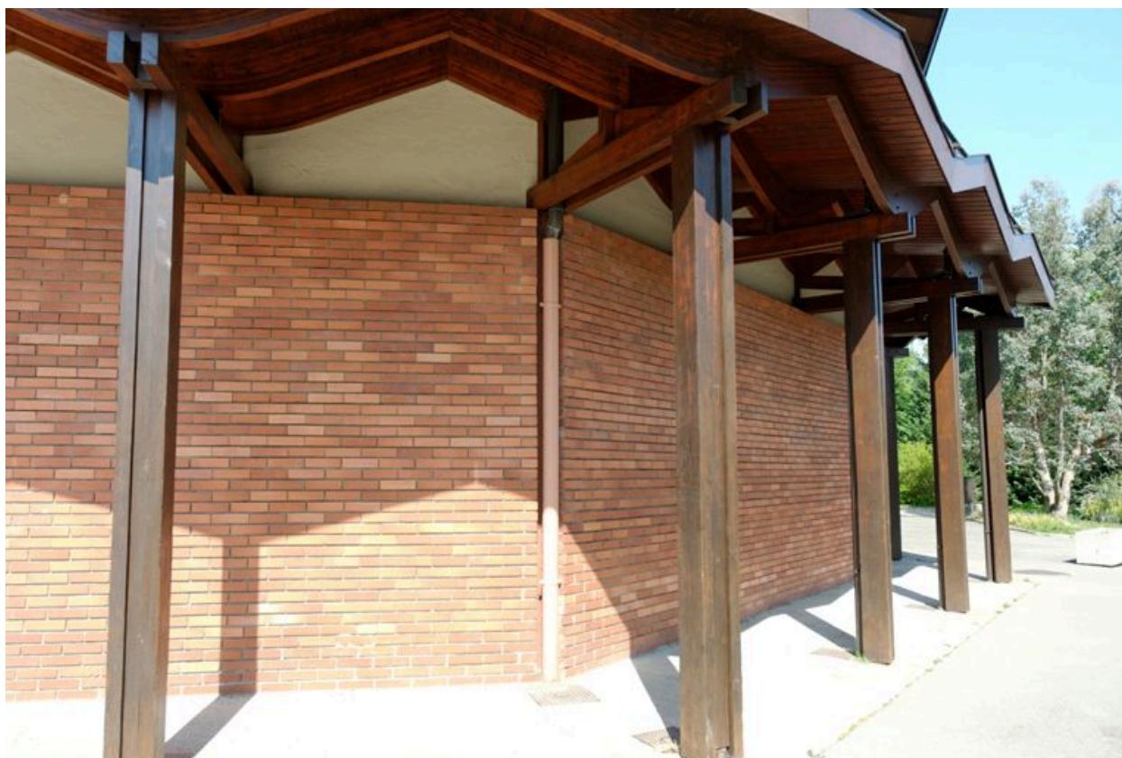
Détail du parement extérieur en brique du mur de l'église
