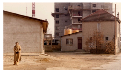
chapelle des Trois Gouttes, et cure de la paroisse. Derrière, on distingue les immeubles en construction Repro. Maryannick Chalabi IVR82_20096900901NUCA
