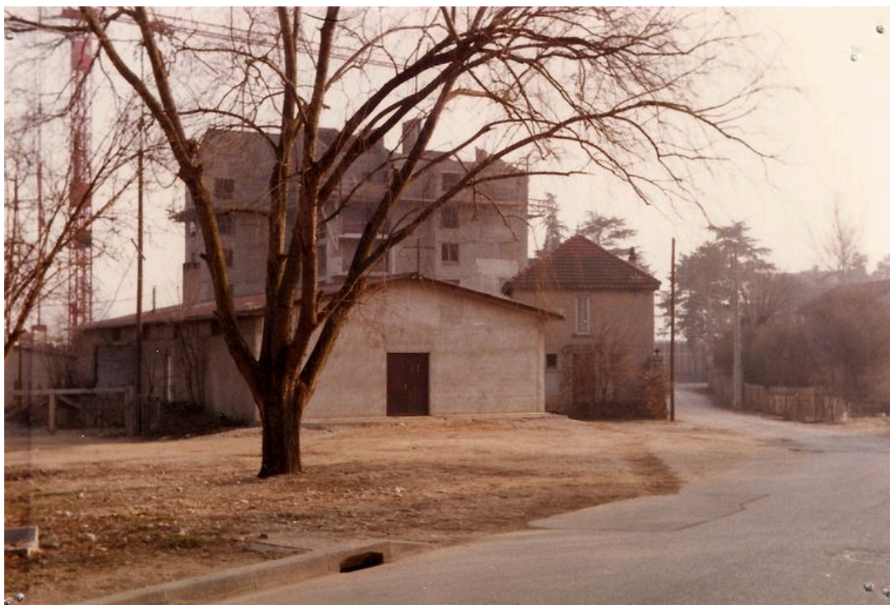
Chapelle des Trois Gouttes, rue Ernest Fabrègue, vue d'ensemble avec la cure, sur la droite
