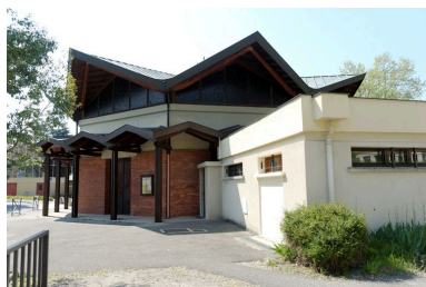
Vue générale de la chapelle mortuaire et de l'église depuis le sud-est Phot. Maryannick Chalabi IVR82_20096900815NUCA
