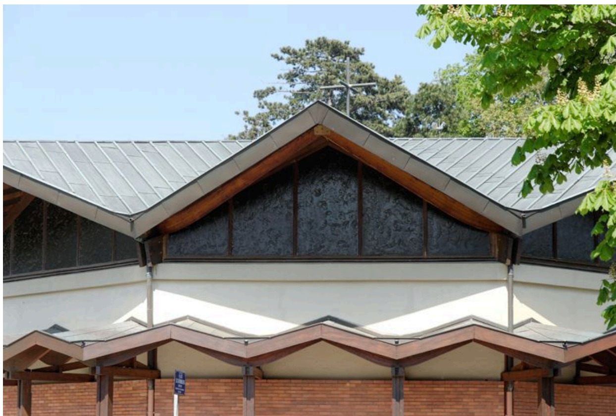
Vue générale du couvrement et du passage couvert
