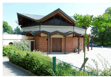
Vue de l'église et de l'oratoire, place Schönberg Phot. Maryannick Chalabi IVR82_20096900808NUCA
