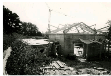
Vue de l'église depuis la place Schönberg, pose de la charpente Repro. Maryannick Chalabi IVR82_20096900908NUCA
