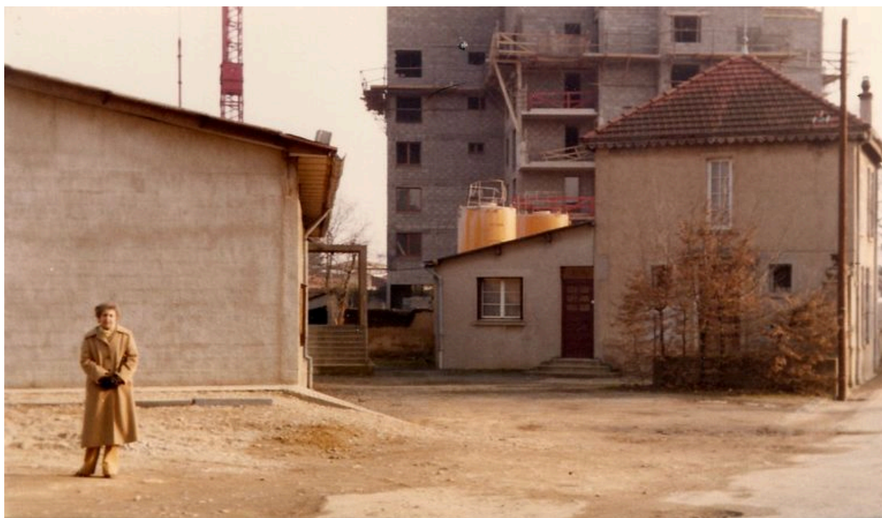
chapelle des Trois Gouttes, et cure de la paroisse. Derrière, on distingue les immeubles en construction
