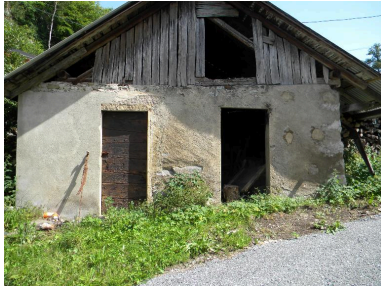
Vue de la façade principale. Phot. Jérôme Daviet IVR82_20137401133NUCA
