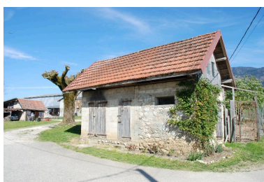
La Marchière, Ferme, 2013 E1 27, 318, 319, 333. Vue d'ensemble d'une petite dépendance de la ferme. Phot. Thierry Monnet IVR84_20167302116NUCA
