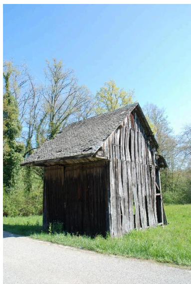
Platet (le), Grange, parcelle E2 147, vue d'ensemble. Phot. Thierry Monnet IVR84_20167302958NUCA
