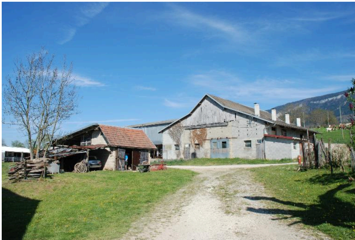
La Marchière, Ferme, 2013 E1 27, 318, 319, 333. Vue d'ensemble de la stabulation.
