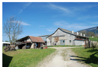
La Marchière, Ferme, 2013 E1 27, 318, 319, 333. Vue d'ensemble de la stabulation. Phot. Thierry Monnet IVR84_20167302114NUCA
