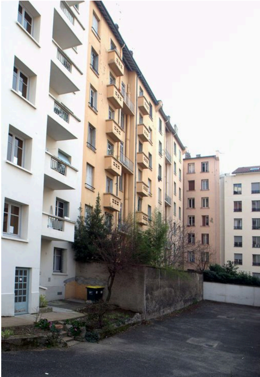
Elévation postérieure depuis le nord
