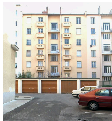
Elévation postérieure depuis l'ouest Phot. Maryannick Chalabi IVR82_20106903565NUCA
