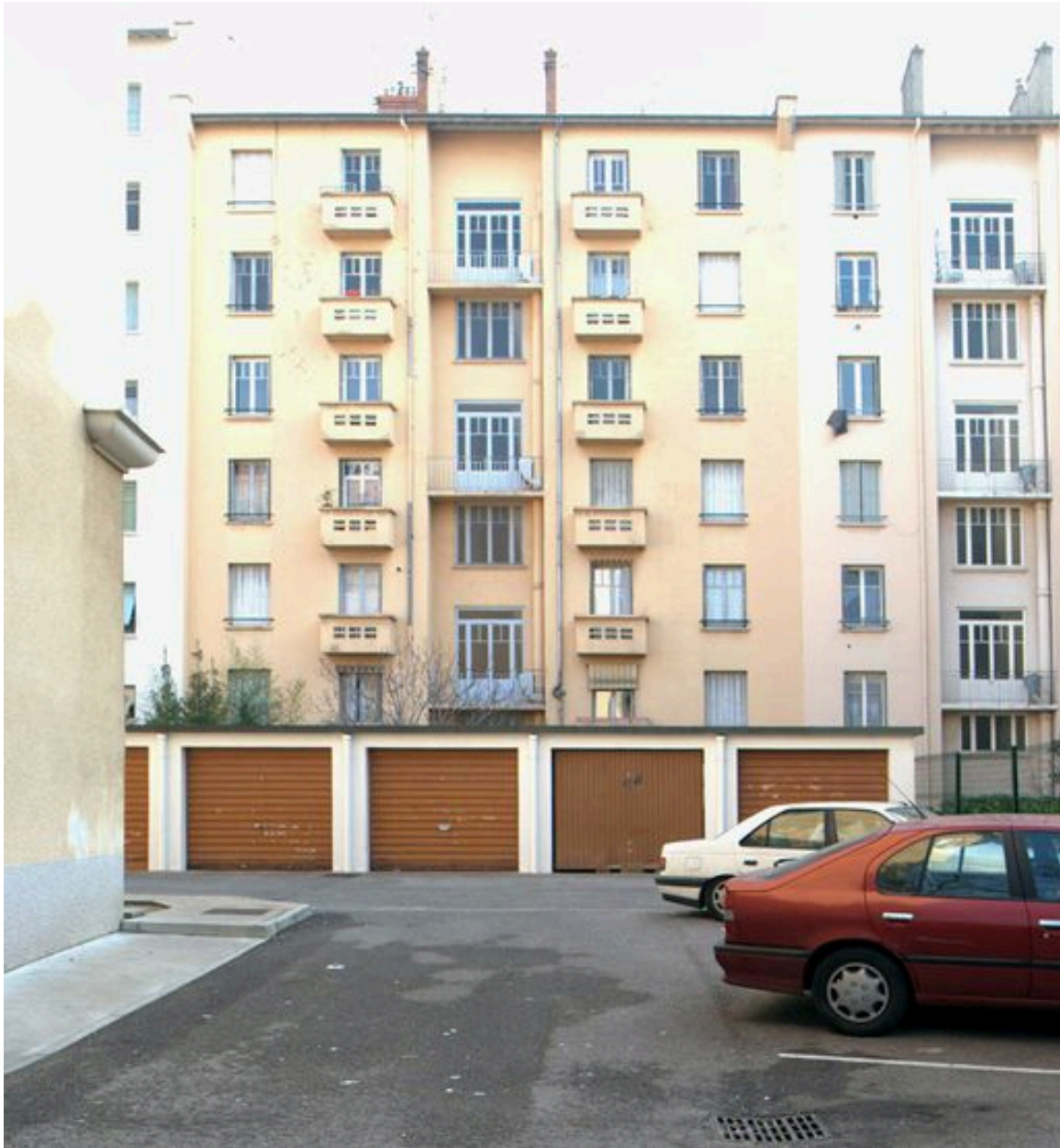
Elévation postérieure depuis l'ouest
