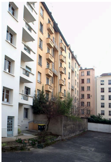
Elévation postérieure depuis le nord Phot. Maryannick Chalabi IVR82_20106903564NUCA
