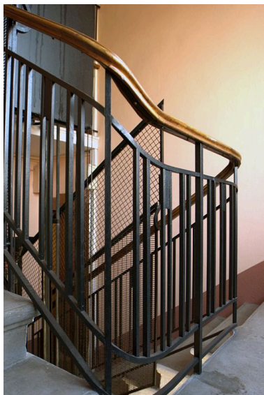
Cage d'escalier Phot. Maryannick Chalabi IVR82_20106903570NUCA
