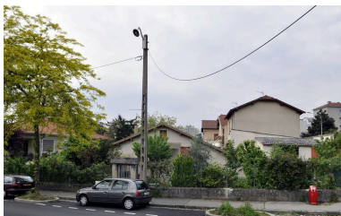
Façade antérieure Phot. Julien Defillon IVR82_20106901016NUCA
