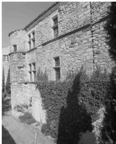
Elévation nord-ouest (parcelles C 104 et C 105) à cordons d'étage et travées de fenêtres à meneaux et traverses. La tour à l'extrémité conserve des meurtrières dans l'angle.
