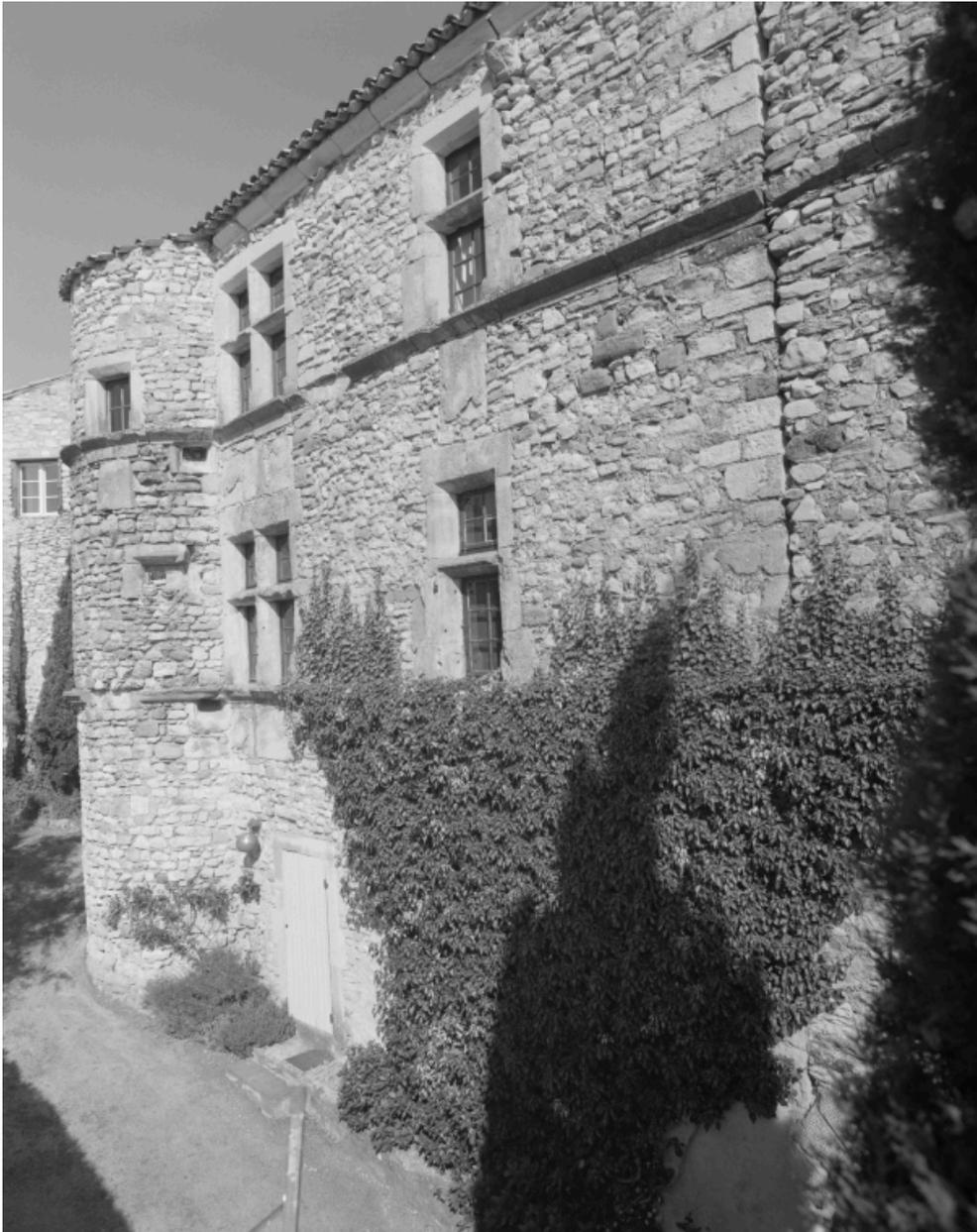
Elévation nord-ouest (parcelles C 104 et C 105) à cordons d'étage et travées de fenêtres à meneaux et traverses. La tour à l'extrémité conserve des meurtrières dans l'angle.
