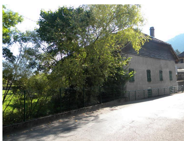
Vue de trois-quarts nord-est depuis la rue Phot. Jérôme Daviet IVR82_20157401502NUCA
