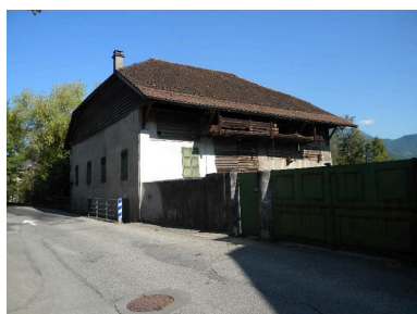
Vue d'ensemble Phot. Jérôme Daviet IVR82_20157401501NUCA
