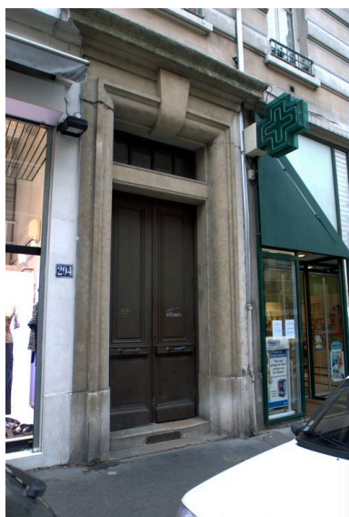
Porte sur rue Phot. Maryannick Chalabi IVR82_20116904033NUCA
