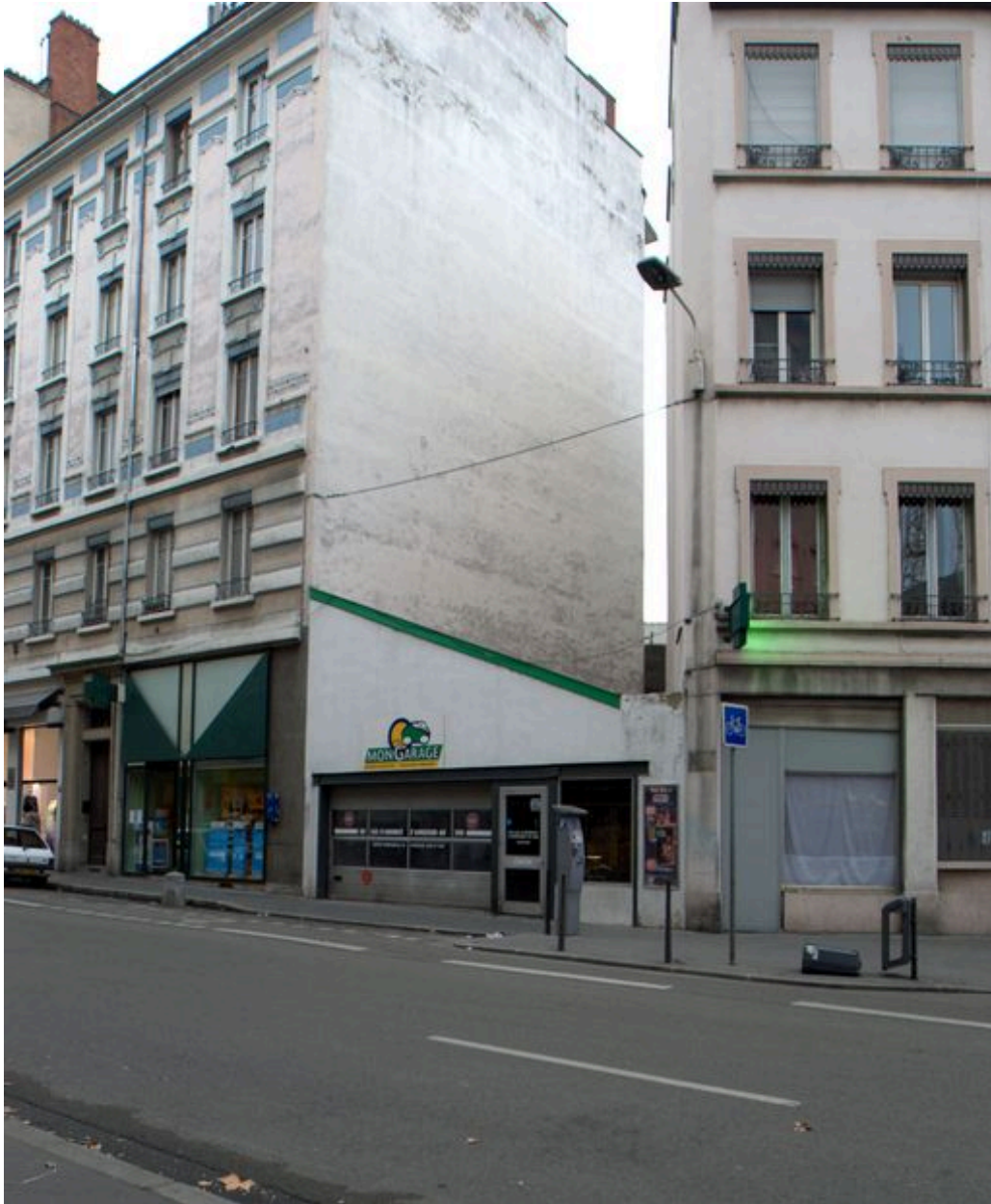
Élévation antérieure depuis l'ouest et annexe du garage Deguillien
