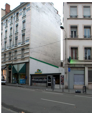
Elévation antérieure depuis l'ouest et annexe du garage Deguillien Phot. Maryannick Chalabi IVR82_20116904031NUCA
