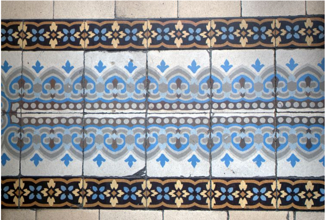
Vestibule, frise en carreaux de ciment
