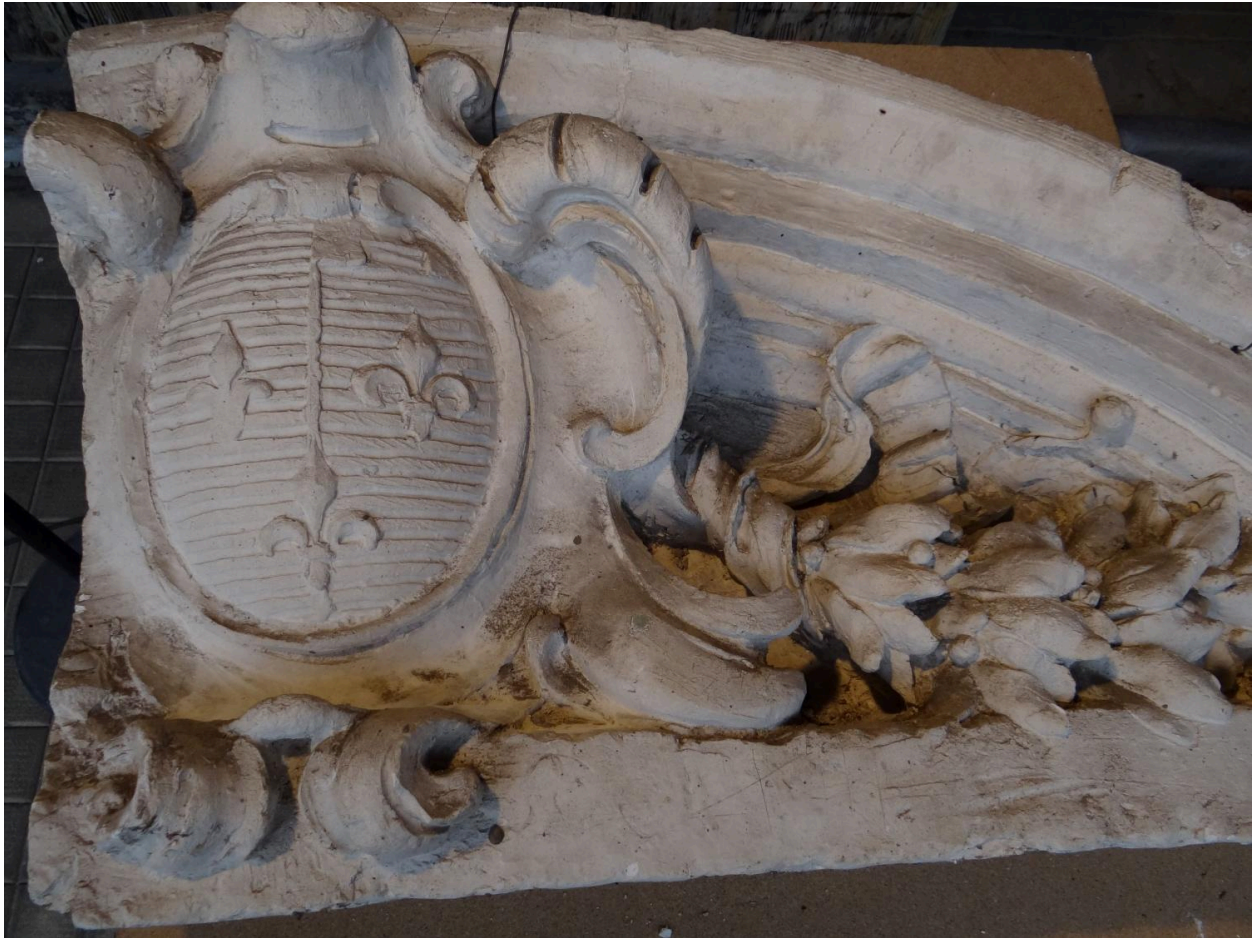
Vue générale de HC 178-18
