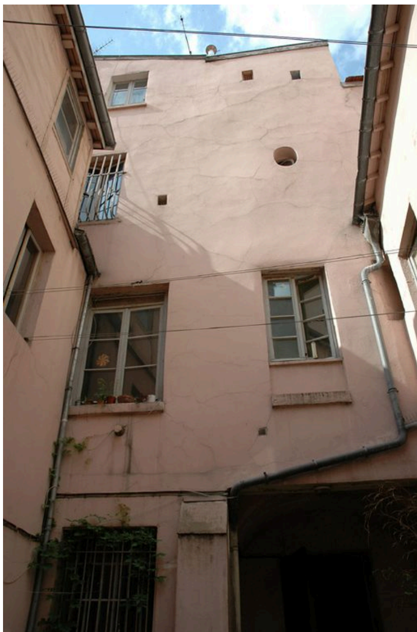
Troisième cour : élévation sud
