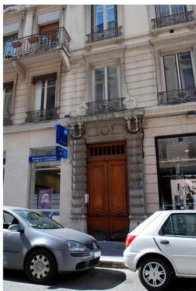
Elévation antérieure : la porte Phot. Véronique Belle IVR82_20096904842NUCA
