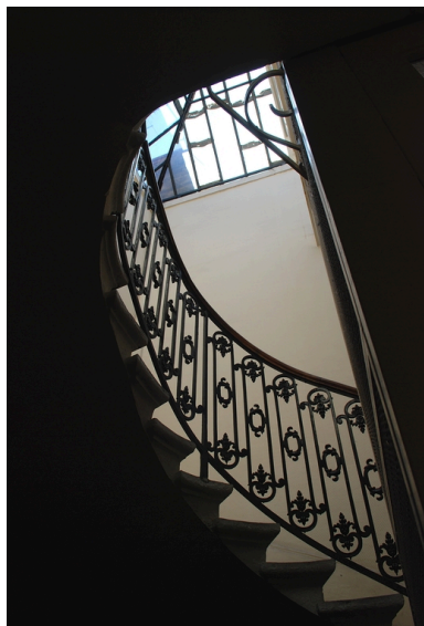
L'escalier : verrière et garde-corps
