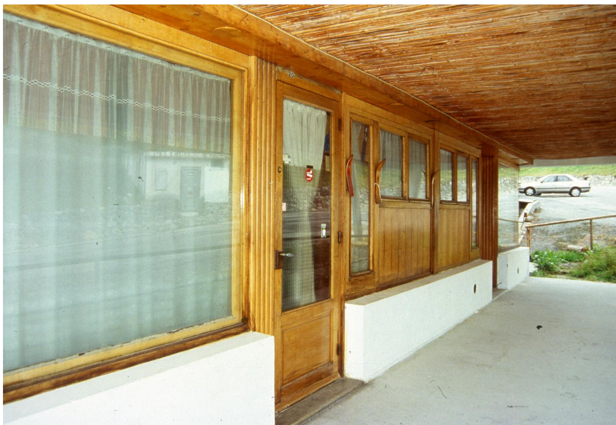
Détail de l'entrée d'un logement
