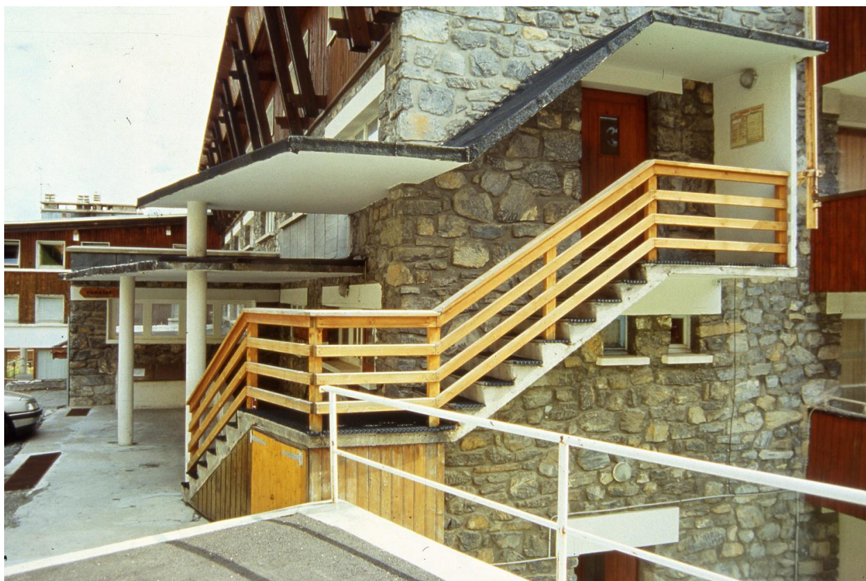
Un escalier de distribution extérieur
