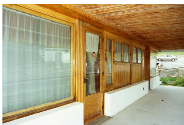
Détail de l'entrée d'un logement Phot. Jean-François Lyon-Caen IVR82_19987300040ZA
