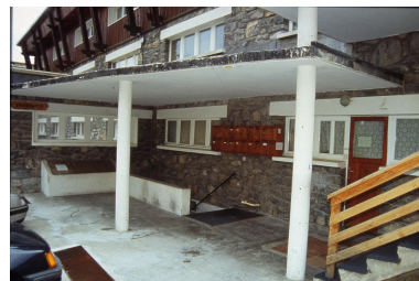
Détail des auvents protégeant les montées d'escalier de distribution extérieur Phot. Jean-François Lyon-Caen IVR82_19987300043ZA
