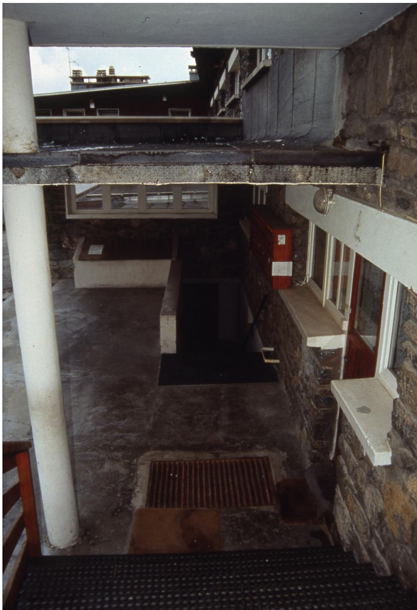
Les montées d'escalier de distribution extérieur
