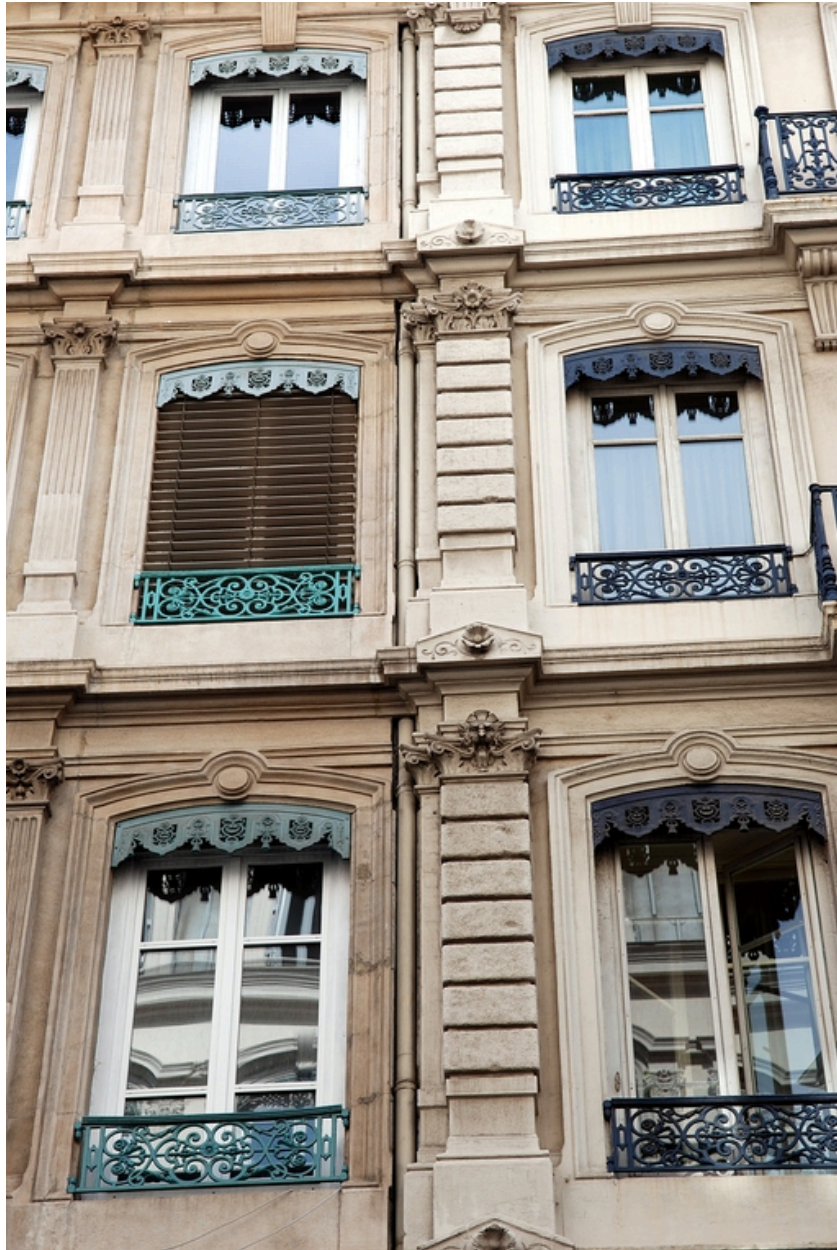
Elévation antérieure : travée mitoyenne avec l'immeuble sis 1 rue Gasparin
