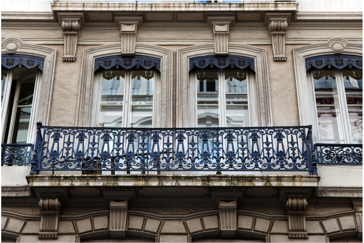
Elévation antérieure : détail du deuxième étage carré
