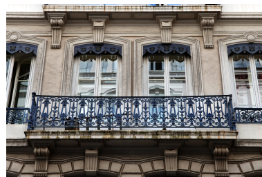
Elévation antérieure : détail du deuxième étage carré Phot. Véronique Belle IVR82_20096904685NUCA
