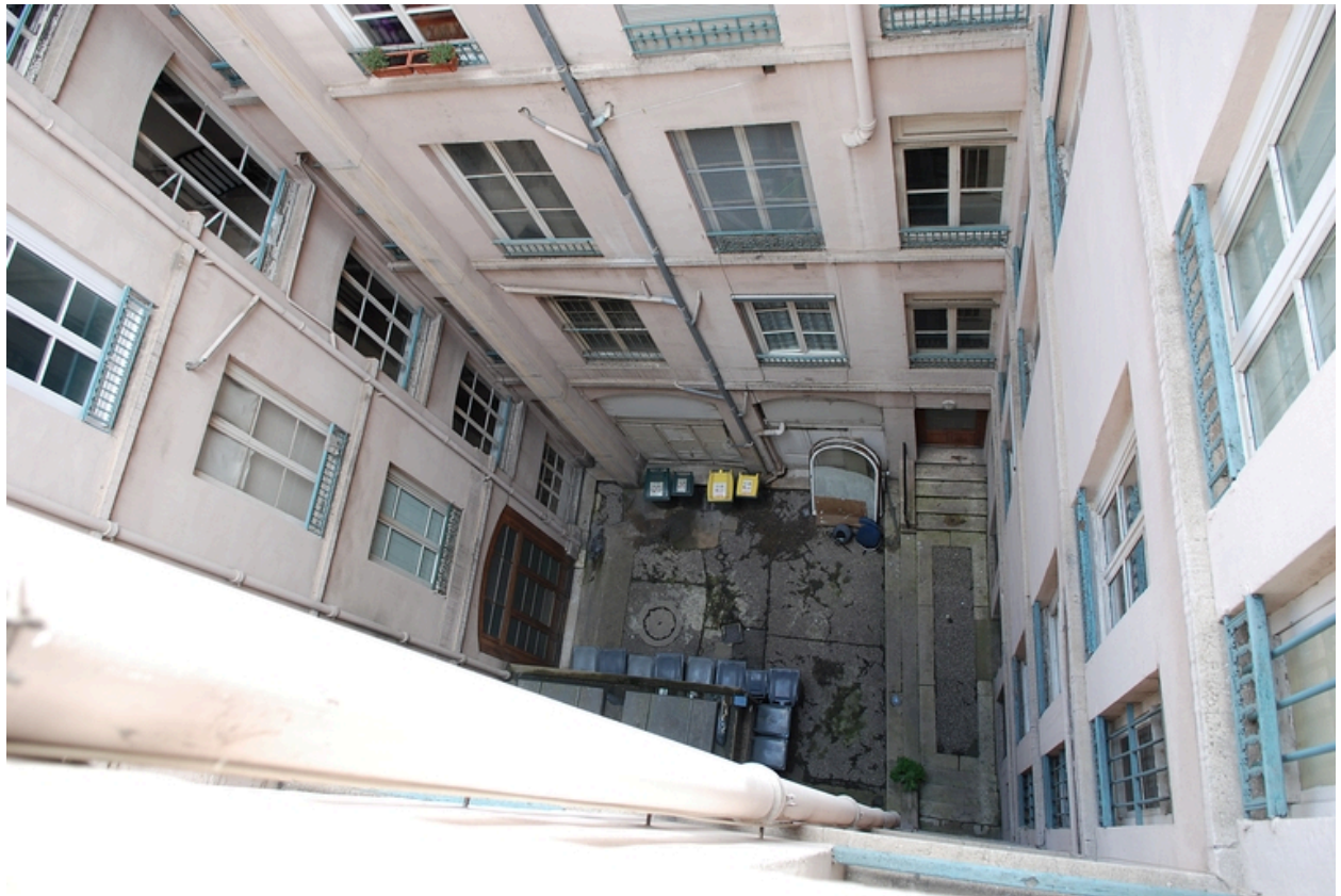
Vue en plongée de la cour, commune avec les immeubles sis 9 place des Jacobins et 86 rue du Président-Edouard-Herriot
