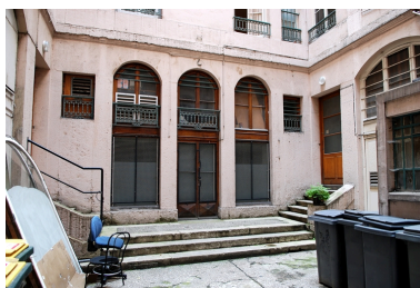
Elévation sud de la cour : le rez-de-chaussée Phot. Véronique Belle IVR82_20096904712NUCA
