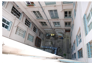
Vue en plongée de la cour, commune avec les immeubles sis 9 place des Jacobins et 86 rue du Président-Edouard-Herriot Phot. Véronique Belle IVR82_20096904687NUCA
