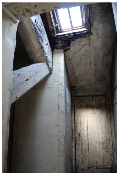
Combles : détail Phot. Véronique Belle IVR82_20096904692NUCA
