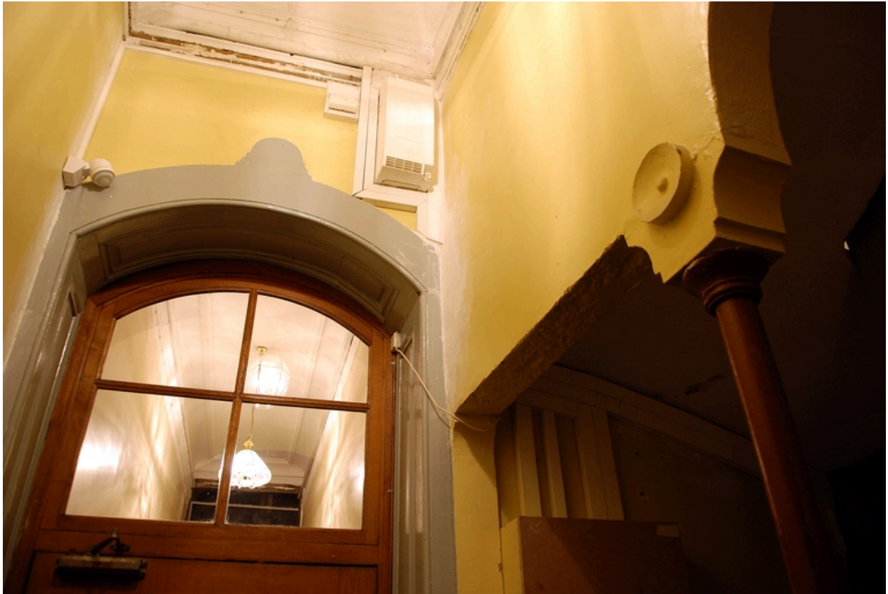
L'allée : sas et jonction avec la cage d'escalier
