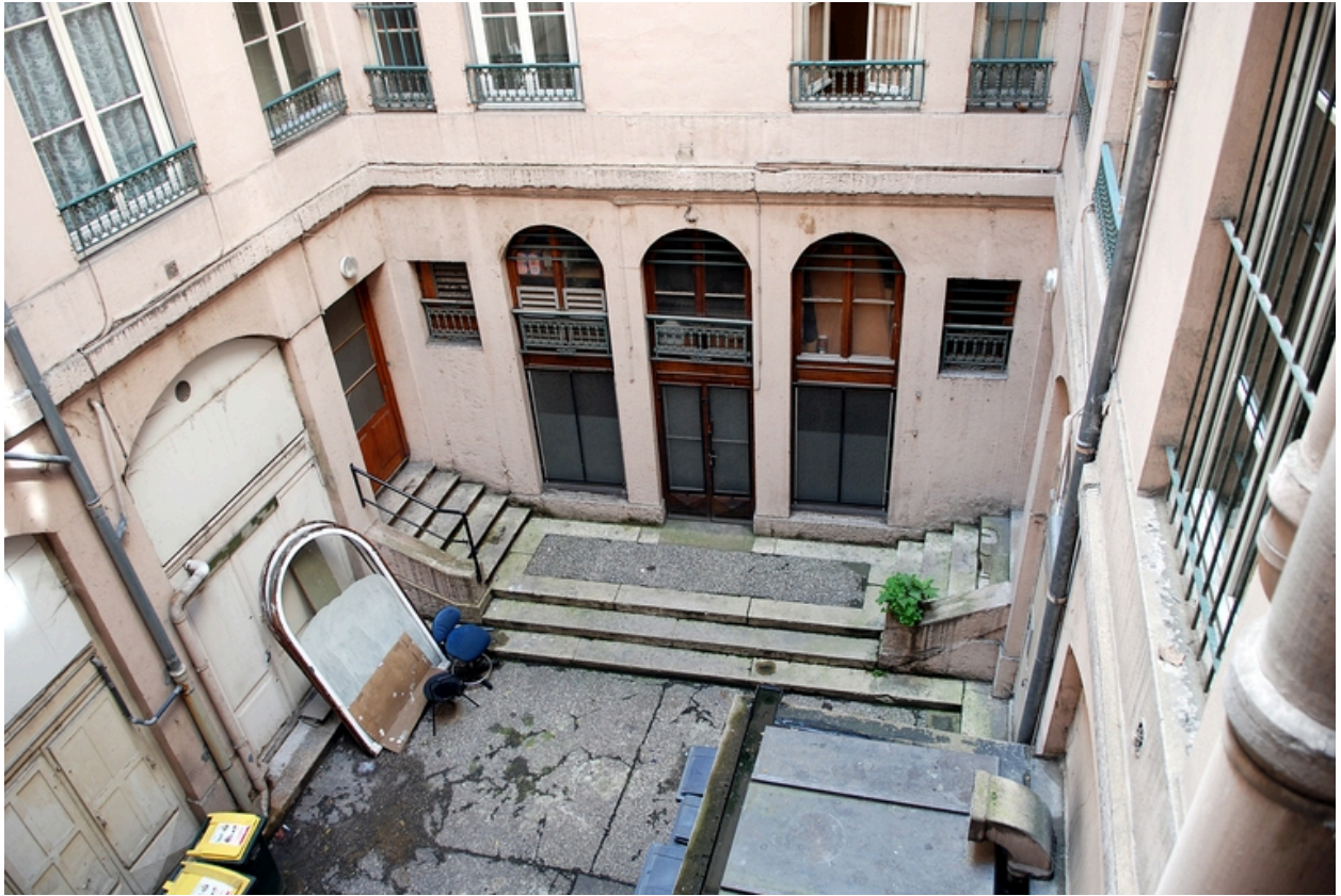
Elévation sud de la cour, commune à l'immeuble sis 86 rue du Président-Edouard-Herriot
