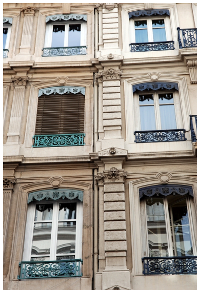
Elévation antérieure : travée mitoyenne avec l'immeuble sis 1 rue Gasparin Phot. Véronique Belle IVR82_20096904686NUCA
