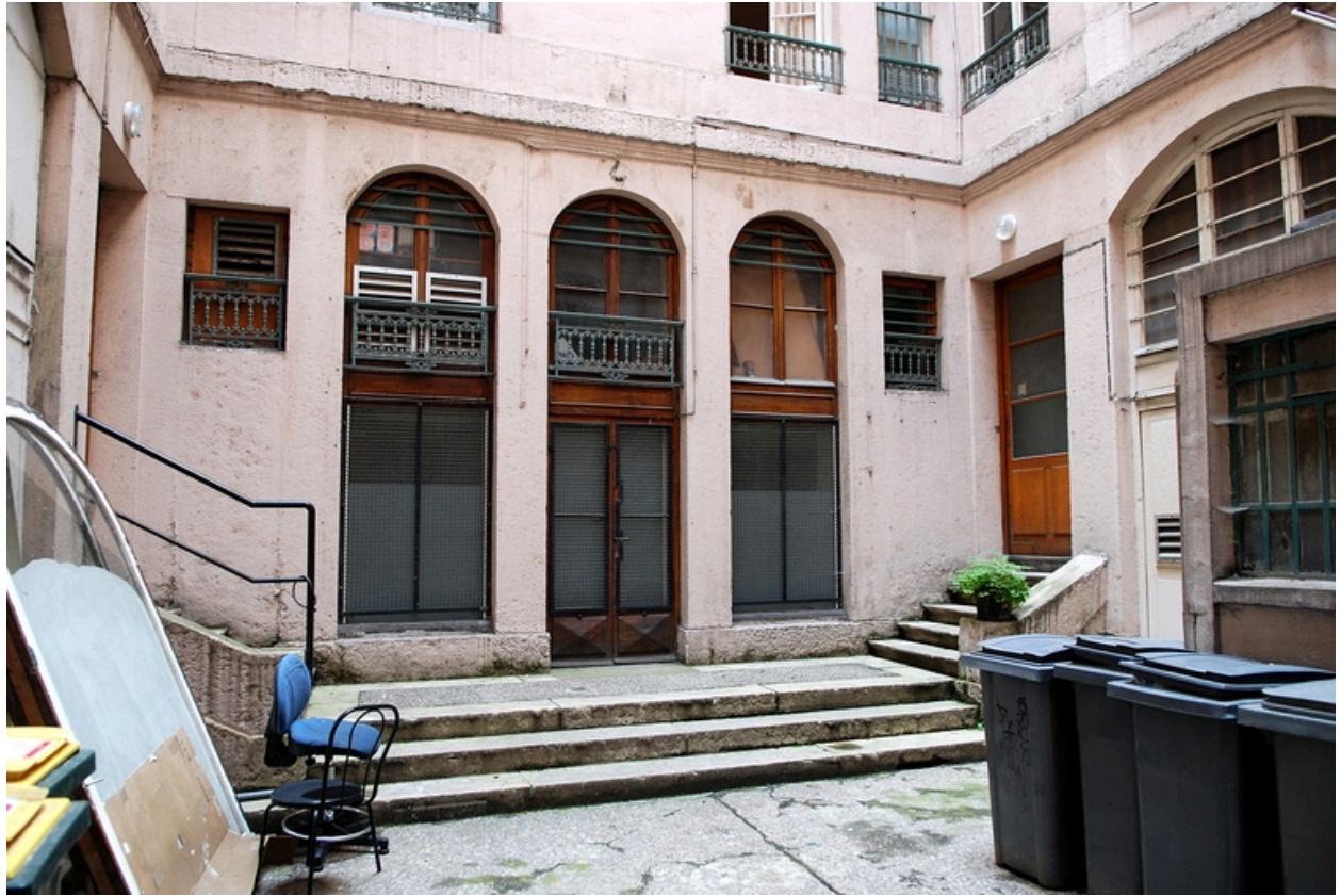
Élévation sud de la cour : le rez-de-chaussée
