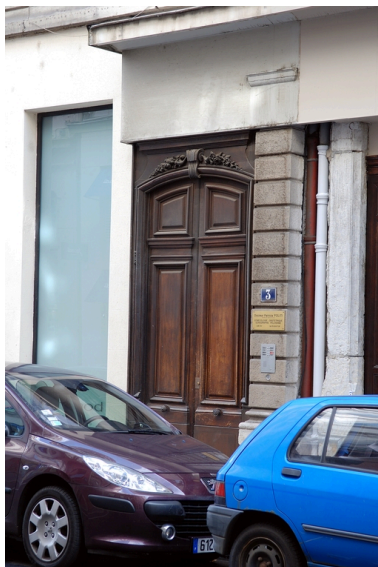
Elévation antérieure : la porte Phot. Véronique Belle IVR82_20096904684NUCA
