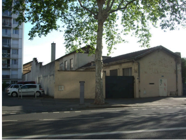
Vue générale sud-est Phot. Nadine Halitim-Dubois IVR82_20126900207NUCA
