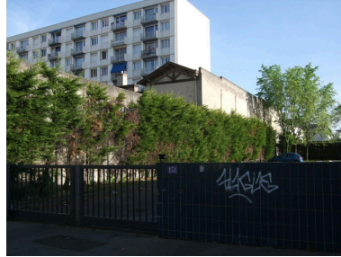
Façade est Phot. Nadine Halitim-Dubois IVR82_20126900204NUCA
