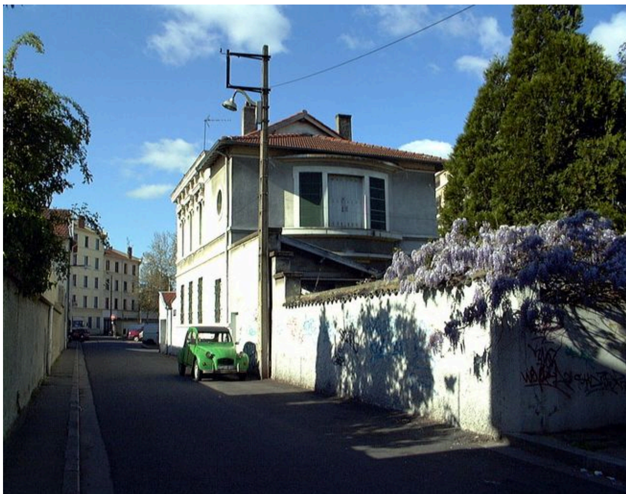
Vue générale depuis la rue Berchet, avant la démolition des bâtiments situés de l'autre côté de la rue Berchet
