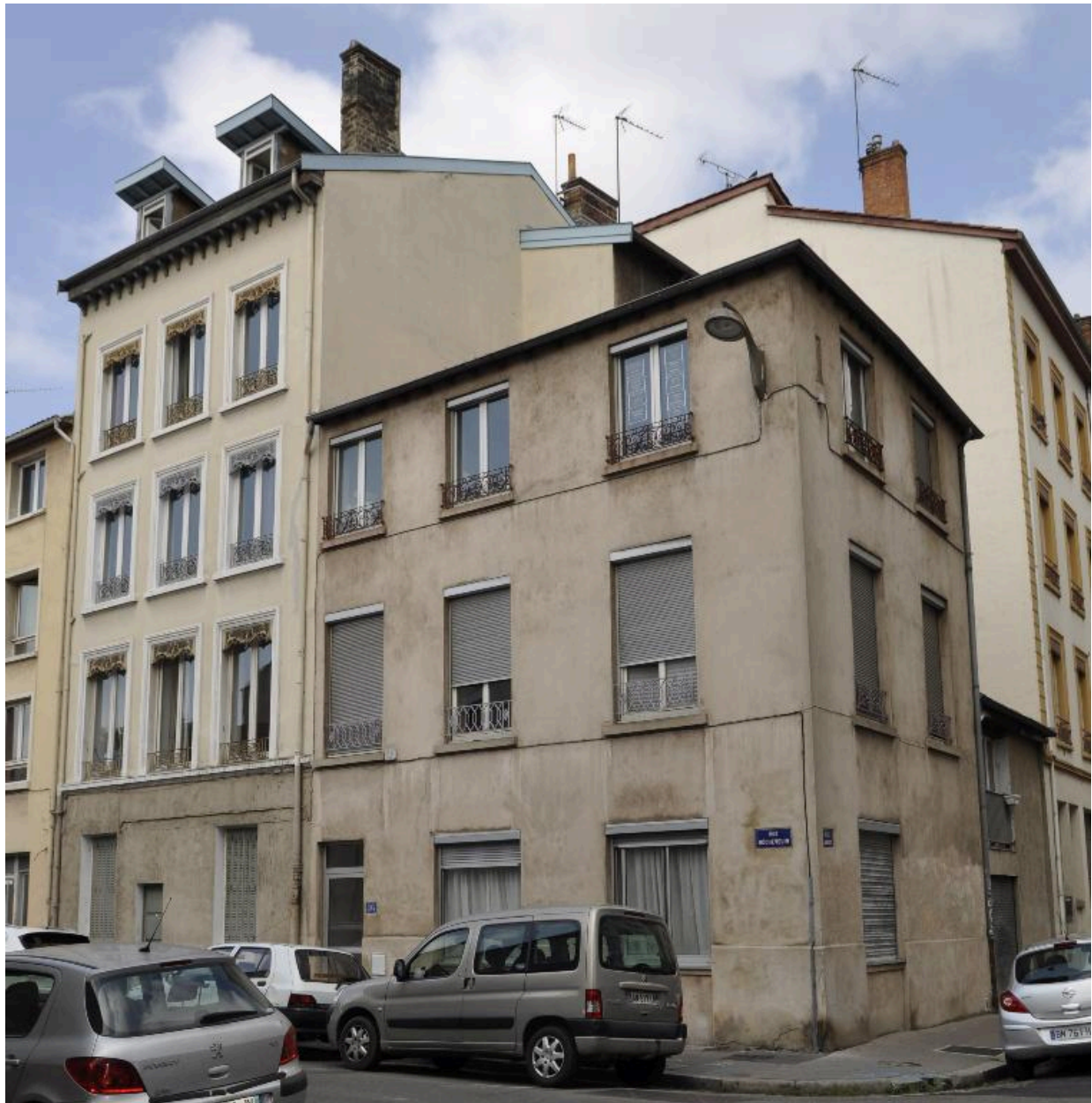
Vue de situation, avec l'immeuble mitoyen partageant le même escalier
