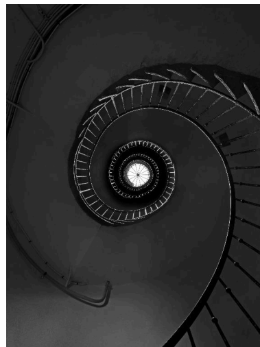
Vue de l'escalier en contre-plongée Phot. Eric Dessert IVR84_20166901447NUCAQ
