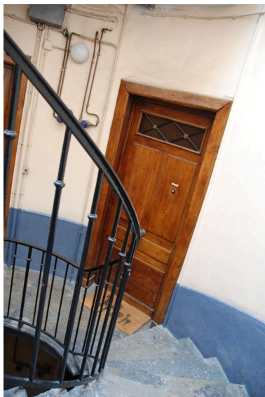
Vue intérieure, une porte palière Phot. Catherine Guillot IVR82_20136900040NUCA
