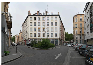
Vue d'ensemble des 4-6 rue Béchevelin, depuis la place du Commandant-Bulard Phot. Eric Dessert IVR84_20166901453NUCA
