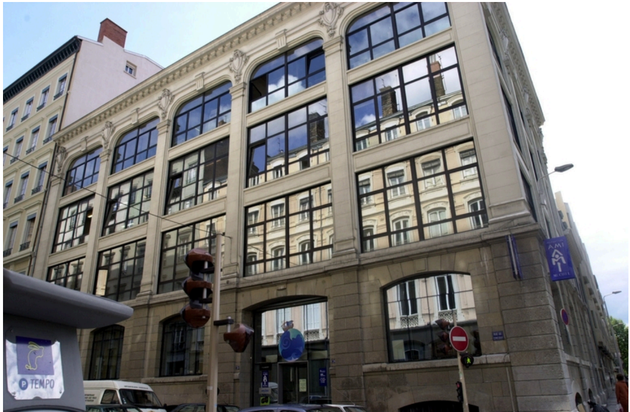
Vue façade est
