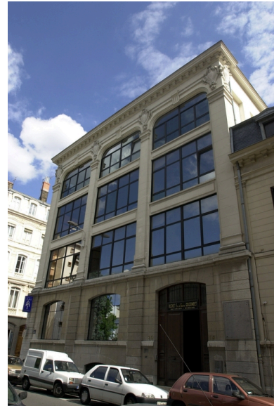
Vue de la façade nord Phot. Nadine Halitim-Dubois IVR82_20026905058NUCA
