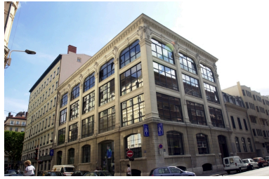
Vue nord-est Phot. Nadine Halitim-Dubois IVR82_20026905056NUCA
