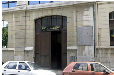
Entrée nord avec enseigne Phot. Nadine Halitim-Dubois IVR82_20026905059NUCA
