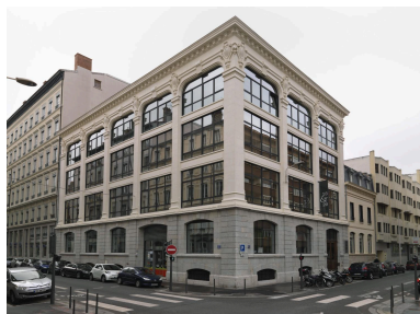
Vue d'ensemble Phot. Didier Gourbin IVR82_20116905332NUCA
