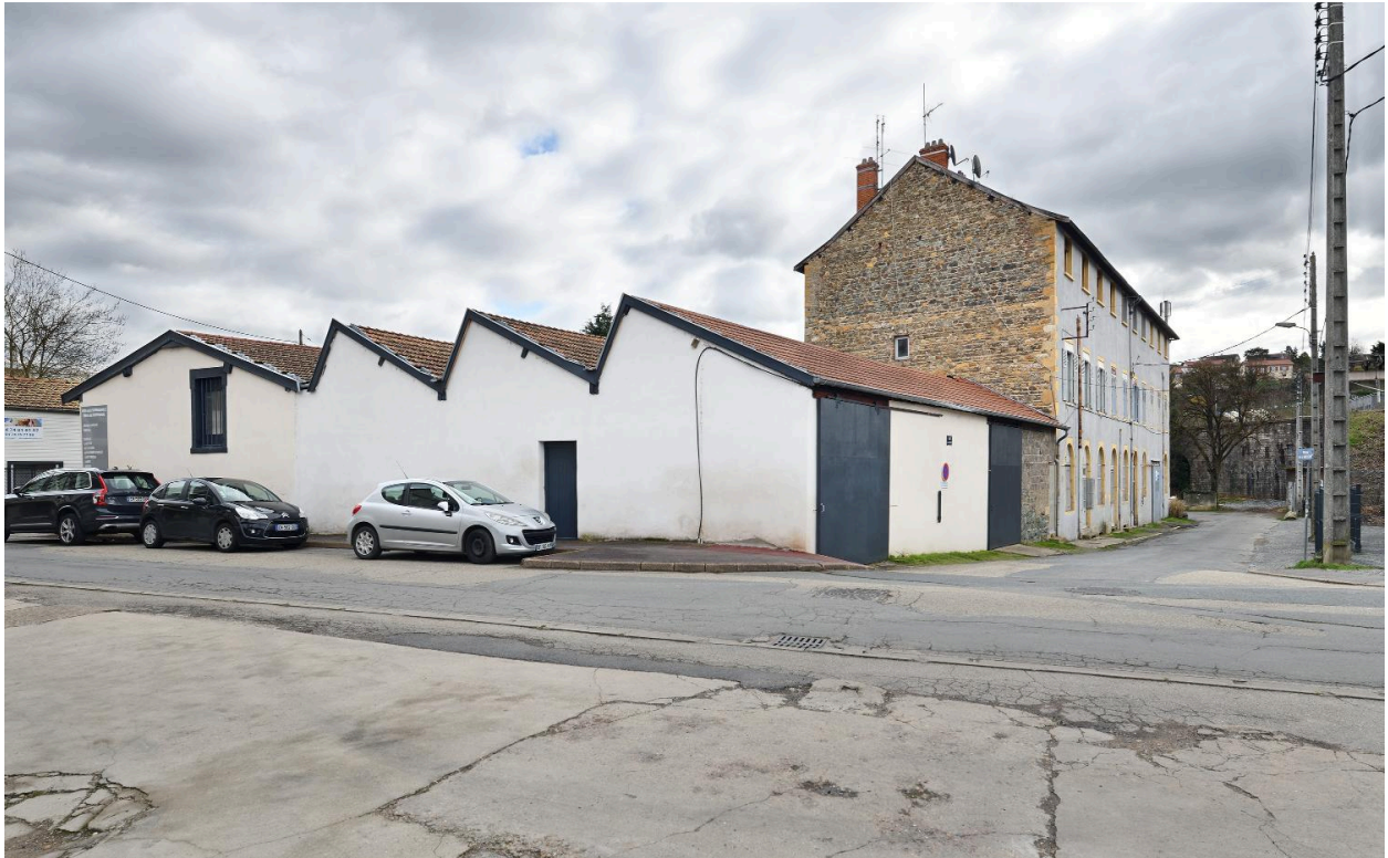
Ateliers sheds connexe à la maison-séchoir
