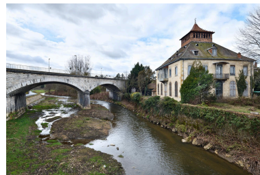
Vue d'ensemble au bord de la Brévenne Phot. Thierry Leroy IVR84_20206900654NUCAQ
