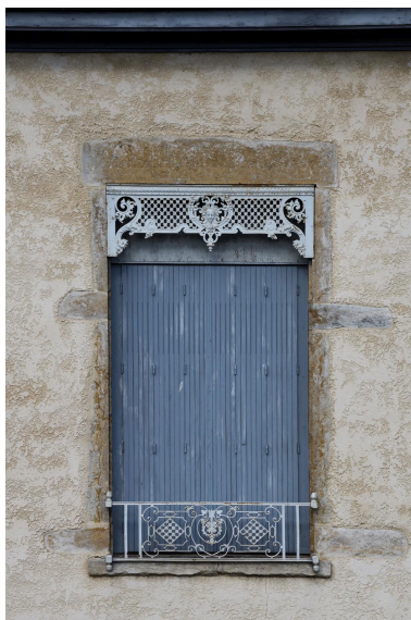
Détail baie garde corps Phot. Thierry Leroy IVR84_20206900658NUCA
