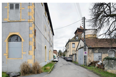
Accès au site Phot. Thierry Leroy IVR84_20206900664NUCAQ
