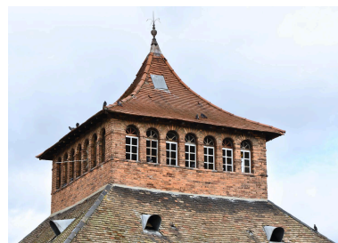
Lanternon ou lanterneau du séchoir Phot. Thierry Leroy IVR84_20206900663NUCAQ
