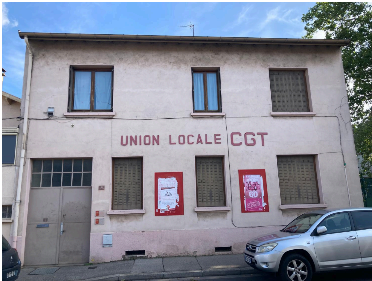
Façade principale du bâtiment
