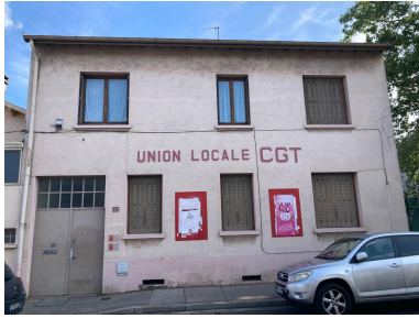
Façade principale du bâtiment Phot. Nadine Halitim-Dubois IVR84_20236900106NUCA
