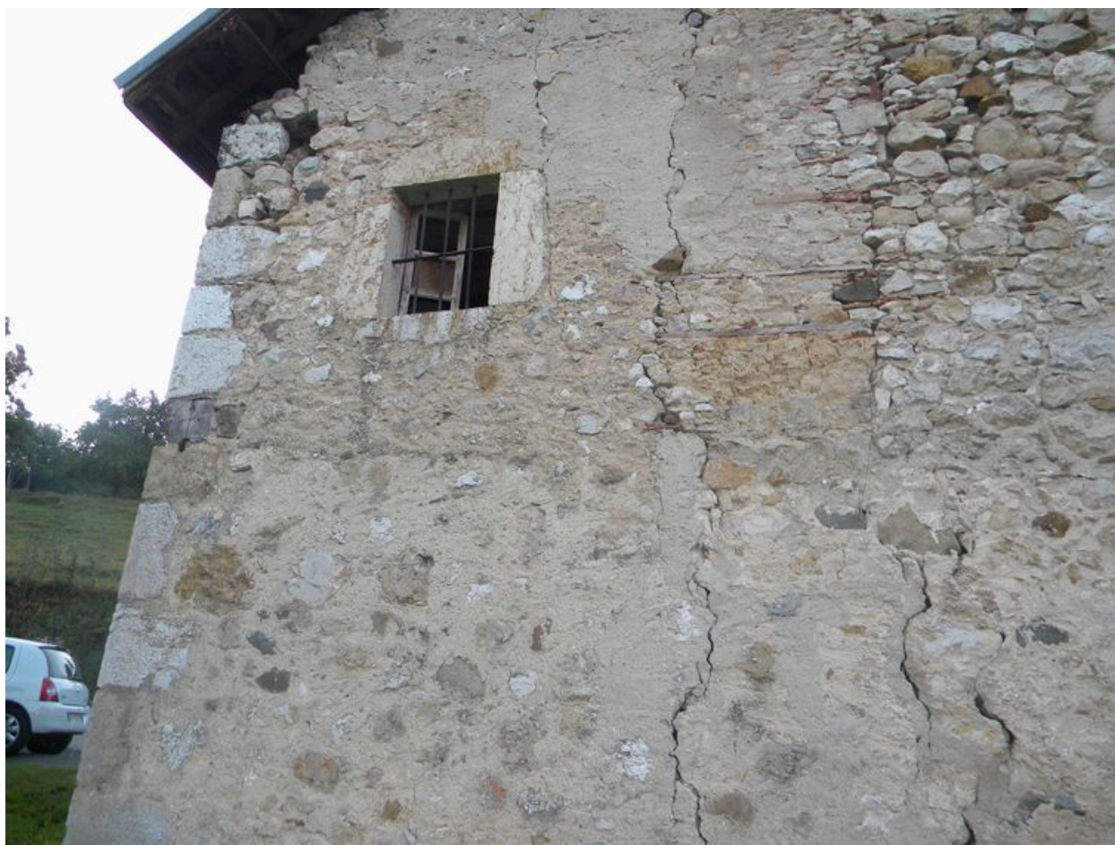
Vue de la fenêtre sur le pignon ouest-nord avec le conduit de cheminée visible.
