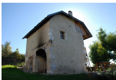
Vue du bâtiment après restauration (2017) Phot. Thierry Monnet IVR84_20207402653NUCA
