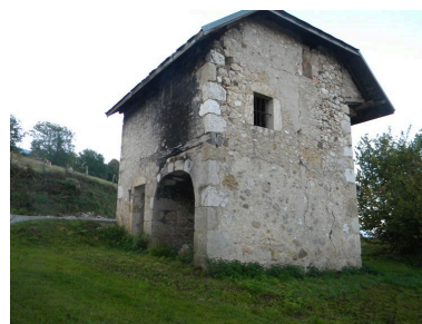
Vue de trois-quarts. Phot. Jérôme Daviet IVR82_20117403699NUCA
