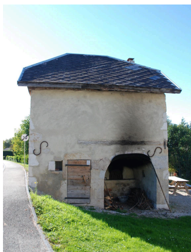
Vue du bâtiment après restauration (2017). Phot. Thierry Monnet IVR84_20207402651NUCA
