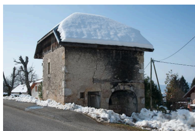
Vue d'ensemble depuis la route de Viuz-la-Chiesaz. Phot. Emmanuel Breteau IVR82_20137400889NUCA
