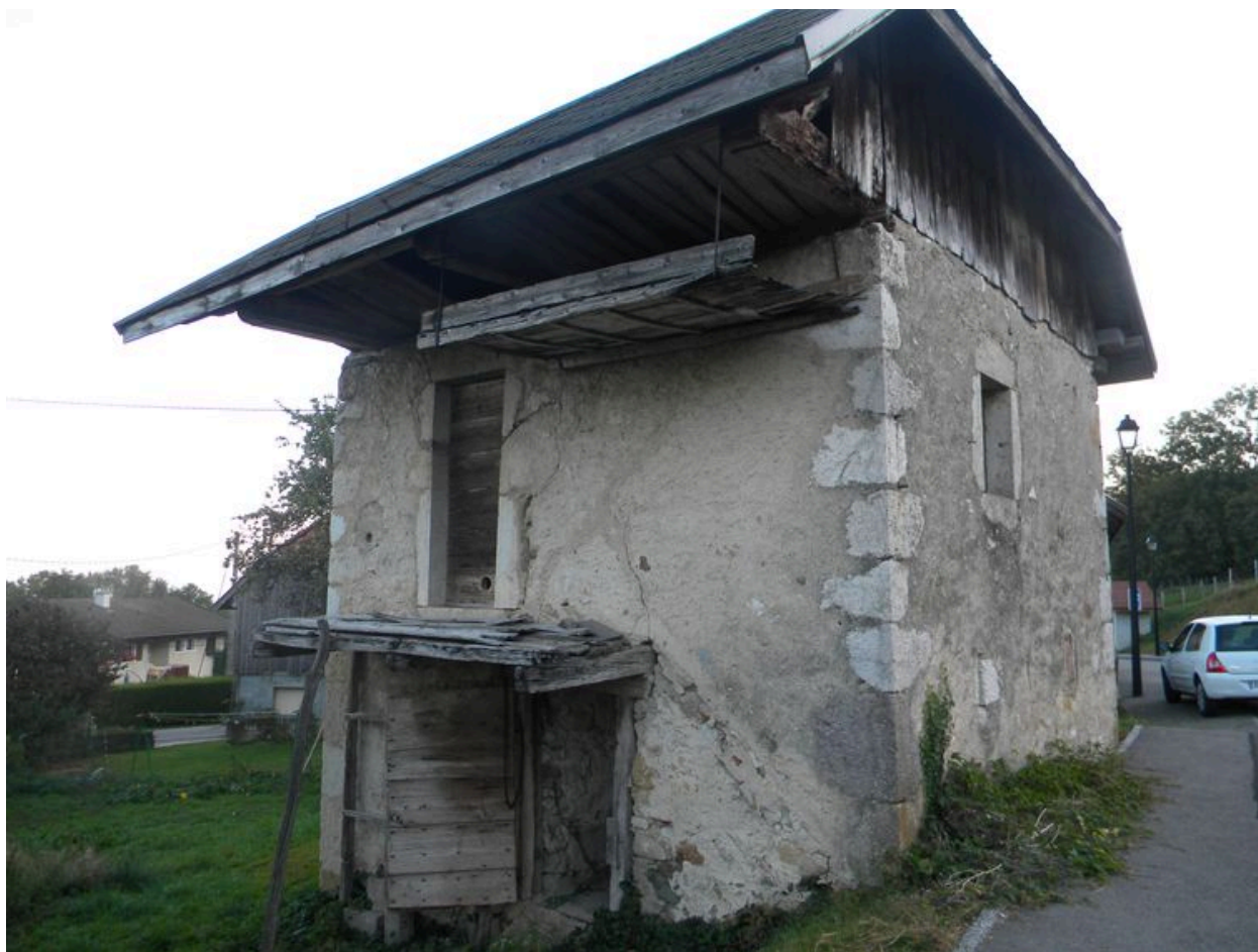
Vue de la façade sud-ouest avec l'entrée du logis à l'étage.
