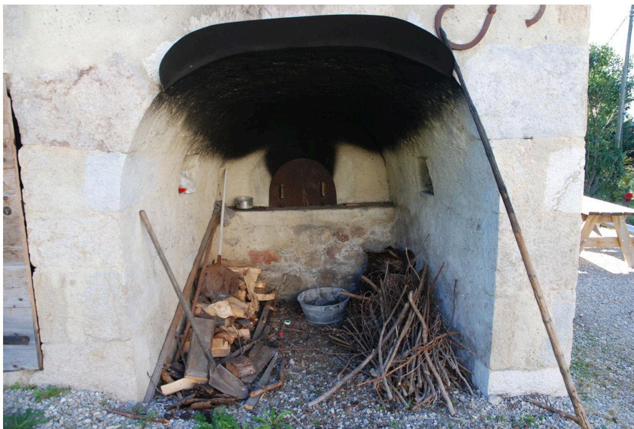
Vue du four après restauration (2017).
