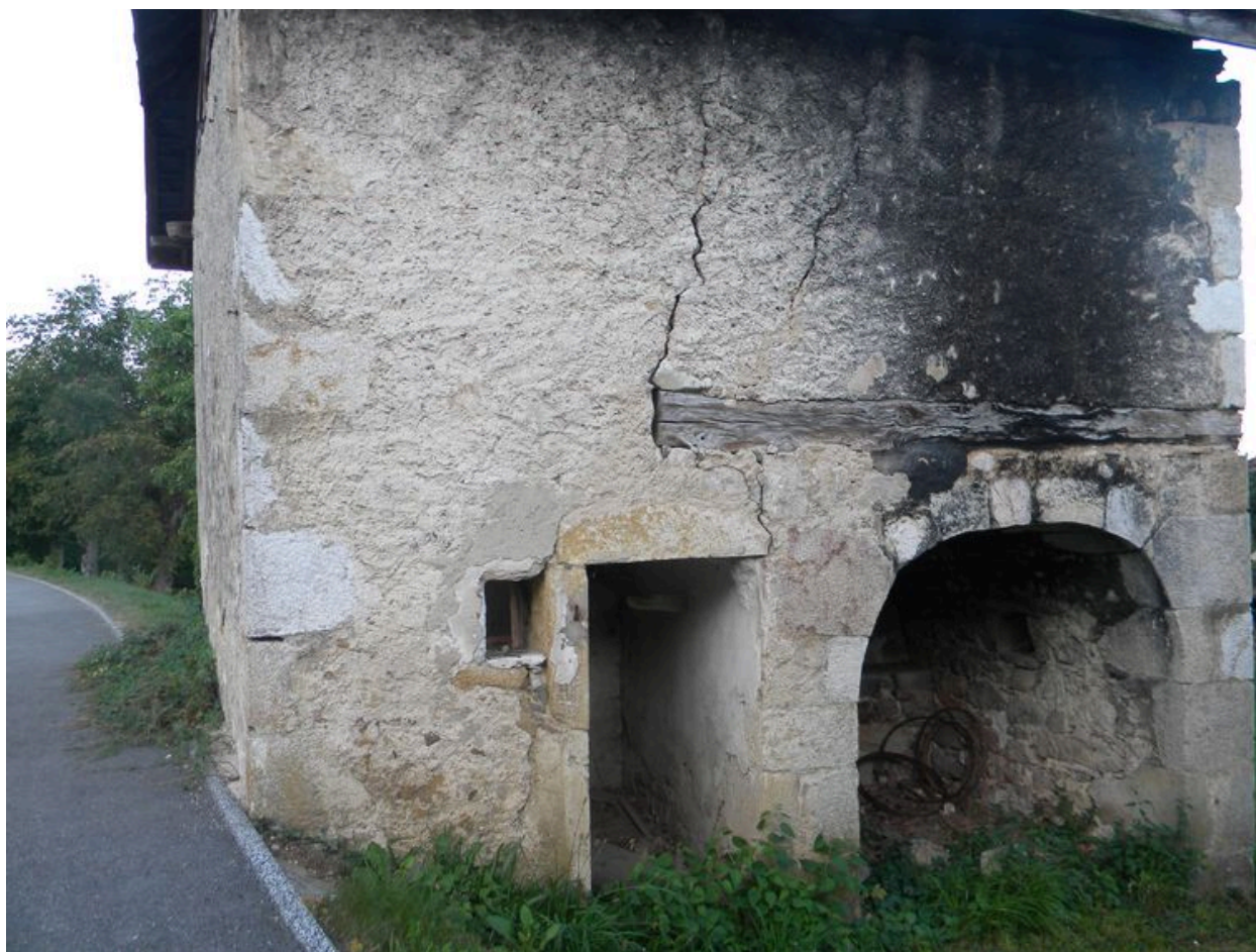
Vue du rez-de-chaussée côté nord-est : entrée du four et d'une pièce pouvant être une étable.
