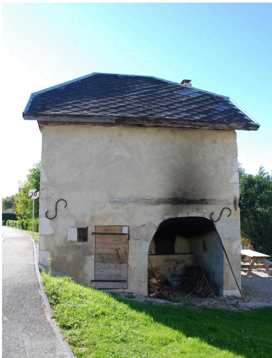
Vue du bâtiment après restauration (2017).
