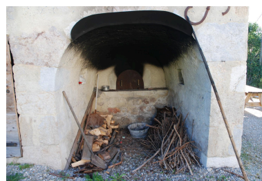
Vue du four après restauration (2017). Phot. Thierry Monnet IVR84_20207402652NUCA
