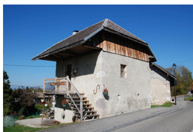
Vue de la façade sud-ouest après restauration (2017). Phot. Thierry Monnet IVR84_20207402650NUCA
