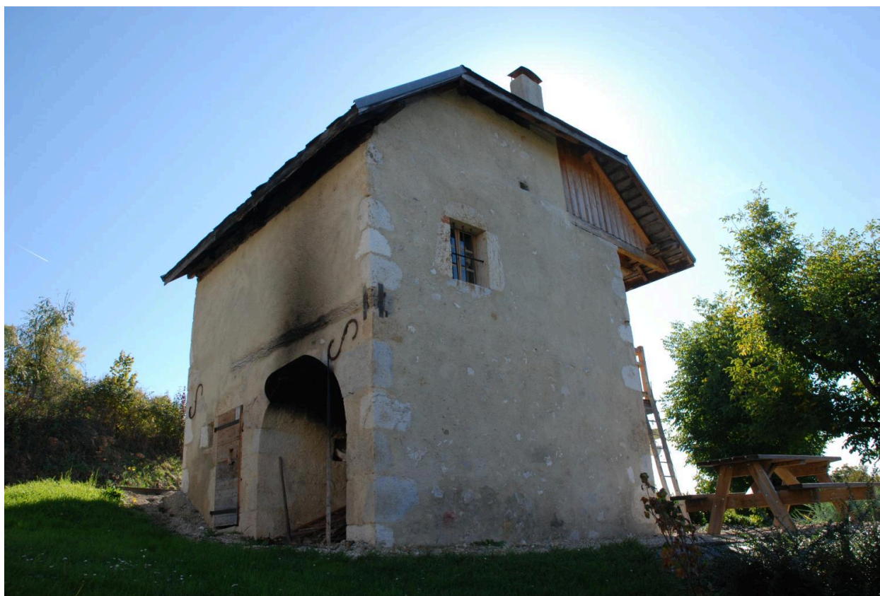
Vue du bâtiment après restauration (2017)
