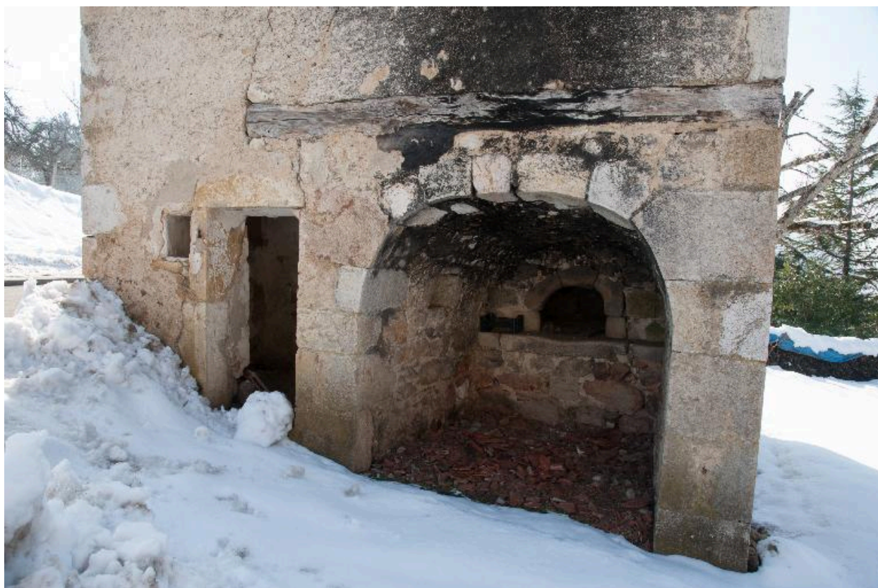
Vue de la voûte du four.
