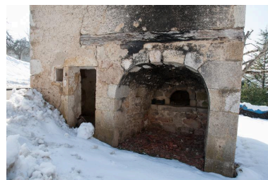
Vue de la voûte du four. Phot. Emmanuel Breteau IVR82_20137400888NUCA
