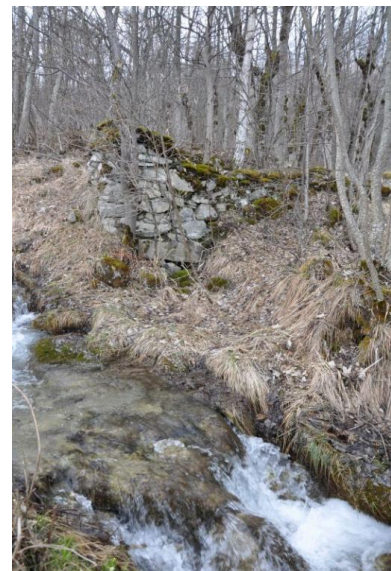
Vestiges du moulin. Vue du mur sud avec le débouché du canal d'eau sous le bâtiment. Phot. Clara Bérelle
