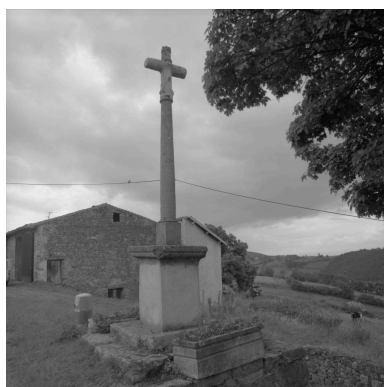
Vue générale depuis le sud. Phot. Jean-Marie Refflé IVR82_20014200062X
