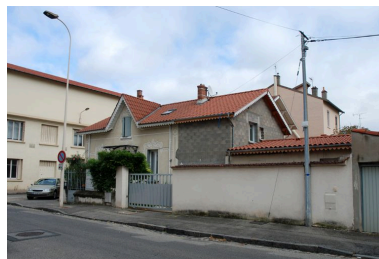
Élévation antérieure Phot. Catherine Guégan IVR82_20086902827NUCA
