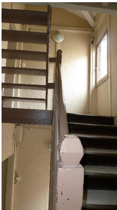
Vue du dernier niveau de l'escalier Phot. Nadine Halitim-Dubois IVR82_20146900457NUCA
