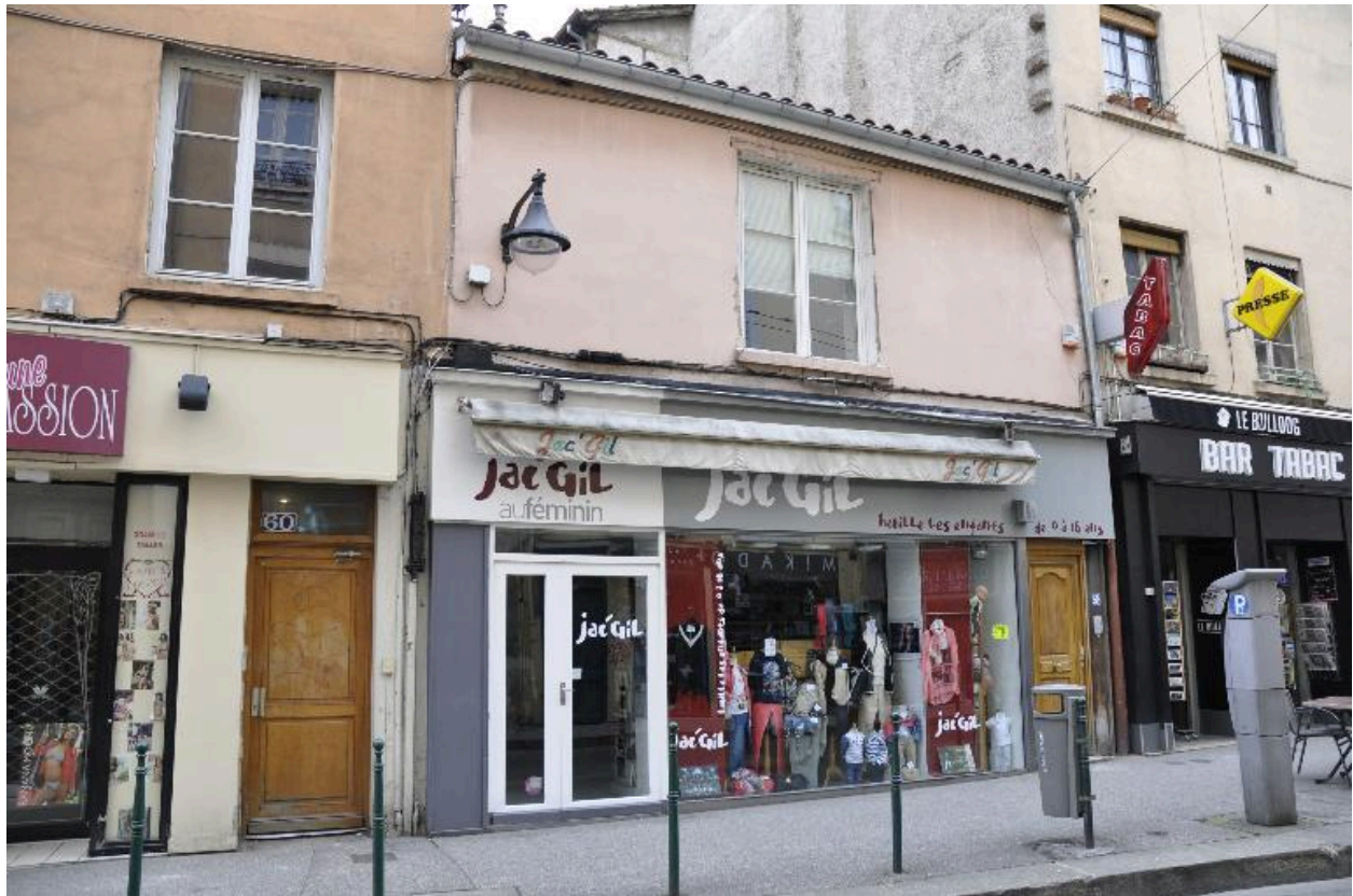
Vue nord ouest de la partie nord de l'immeuble
