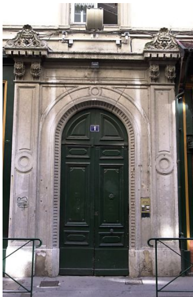
Façade principale, porte Phot. Bernard Ducouret IVR82_20046900191NUCA
