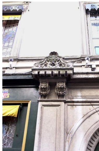
Façade principale, détail de la porte Phot. Bernard Ducouret IVR82_20046900192NUCA
