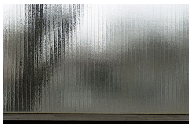
Détail du mur-rideau Phot. Maryannick Chalabi IVR82_20066901091NUCA
