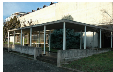
Vue du portique latéral ouest Phot. Maryannick Chalabi IVR82_20066901137NUCA
