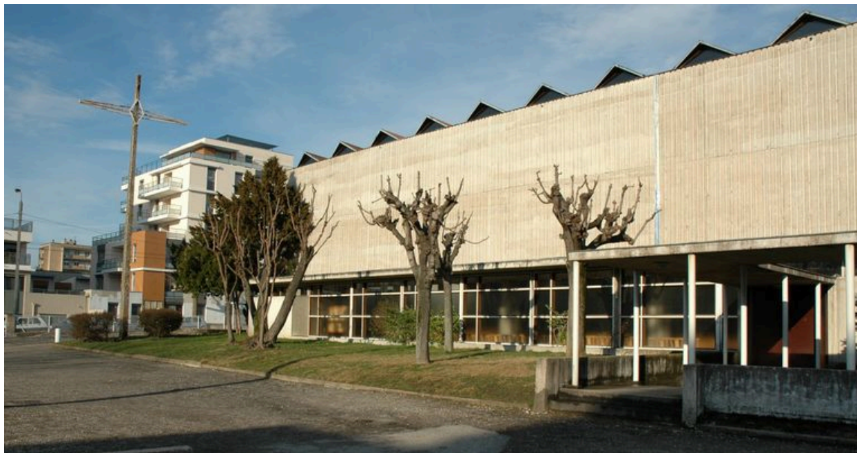
Elévation latérale ouest depuis le sud-ouest
