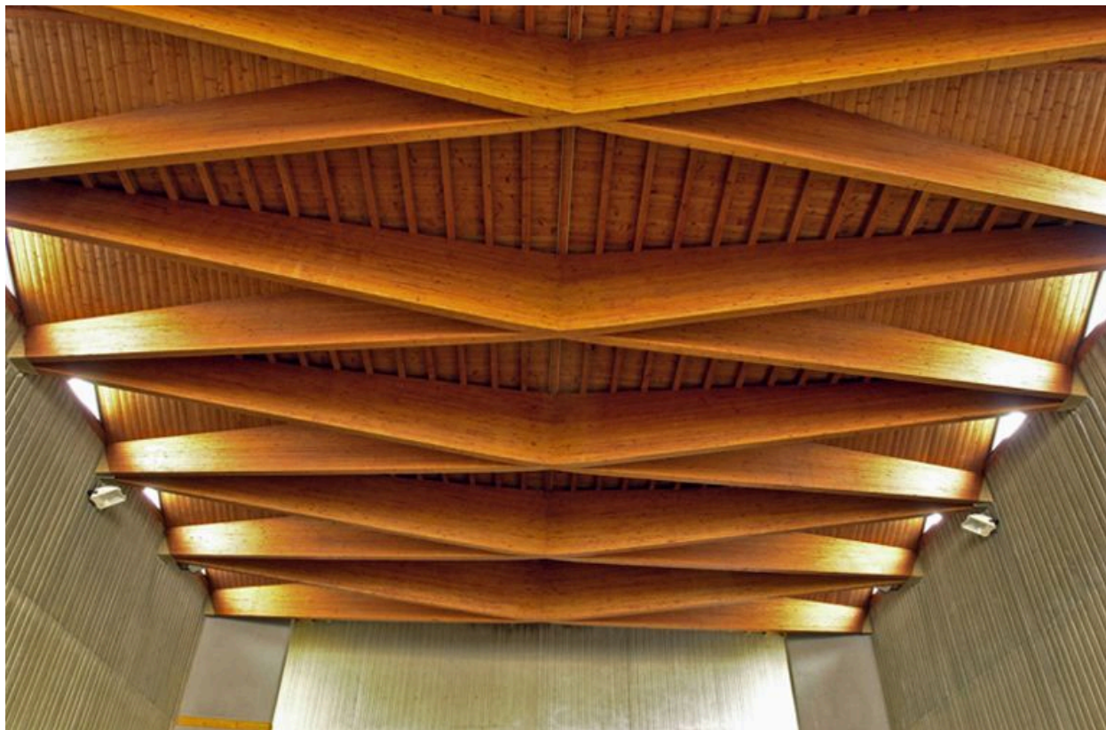
Vue de la charpente apparente
