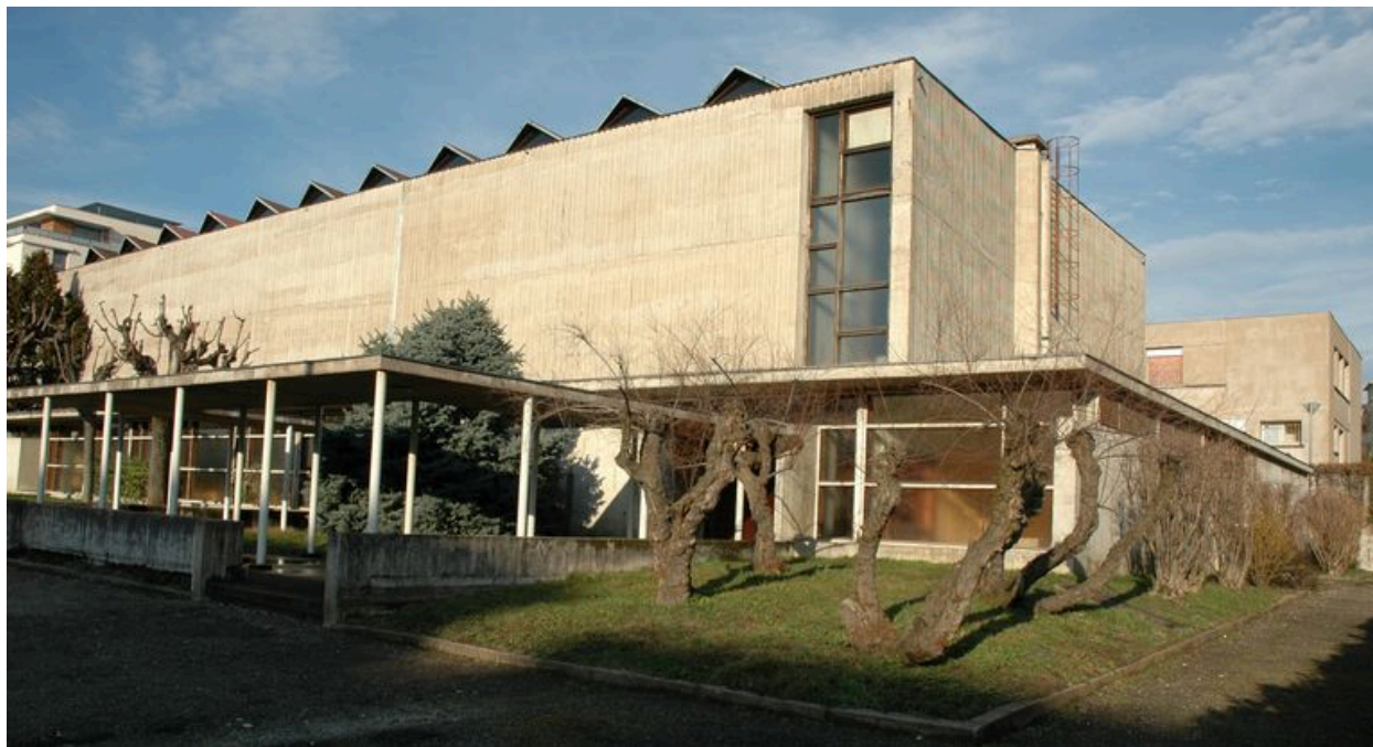
Vue du chevet depuis l'ouest
