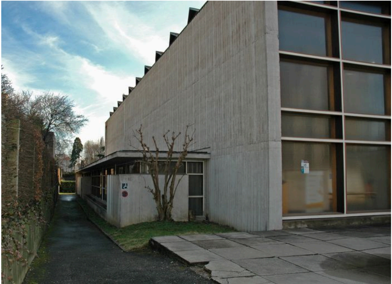
Elévation latérale est et bas-côté depuis le nord
