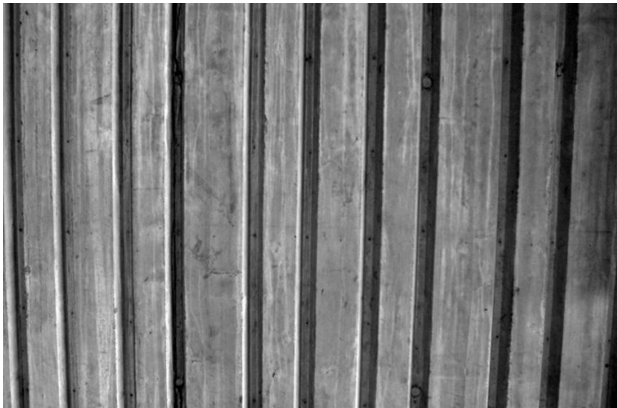
Mur de la nef. Détail du béton
