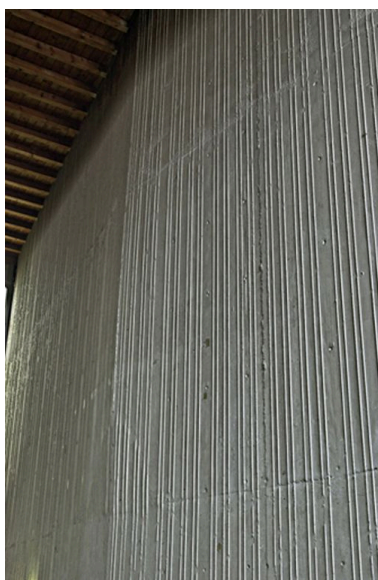
Mur du chevet. Détail Phot. Maryannick Chalabi IVR82_20066901094NUCA
