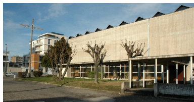
Elévation latérale ouest depuis le sud-ouest Phot. Maryannick Chalabi IVR82_20066901126NUCA
