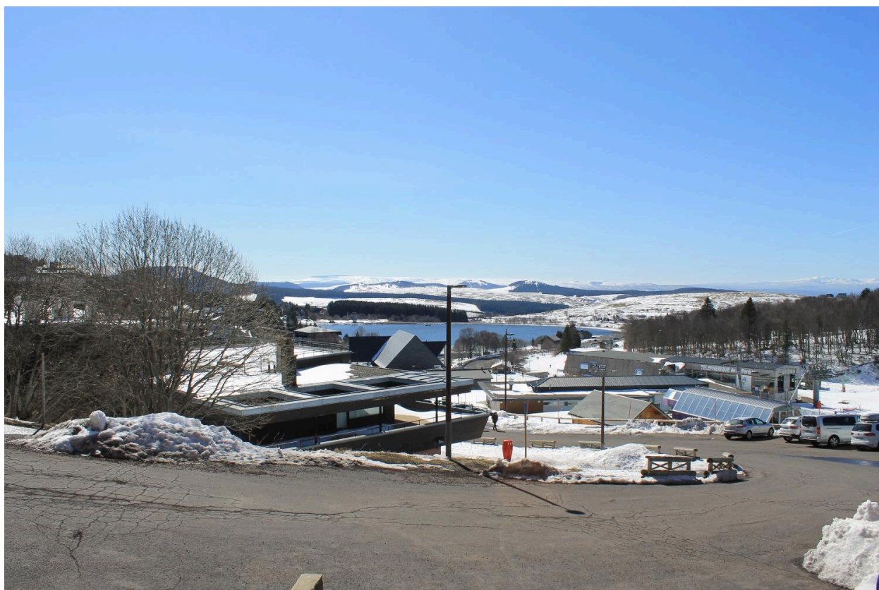
Panorama visible depuis le parvis de l'entrée principale de la Tour de la Biche, en direction du sud-est ; à l'horizon le plateau du Cézallier (au centre) et les monts du Cantal (à droite).
