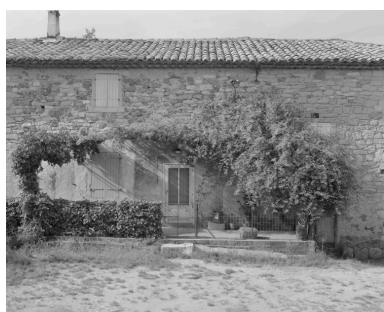
Vue partielle de la ferme (A2 303). Phot. Alain Franchella IVR82_19972600471X
