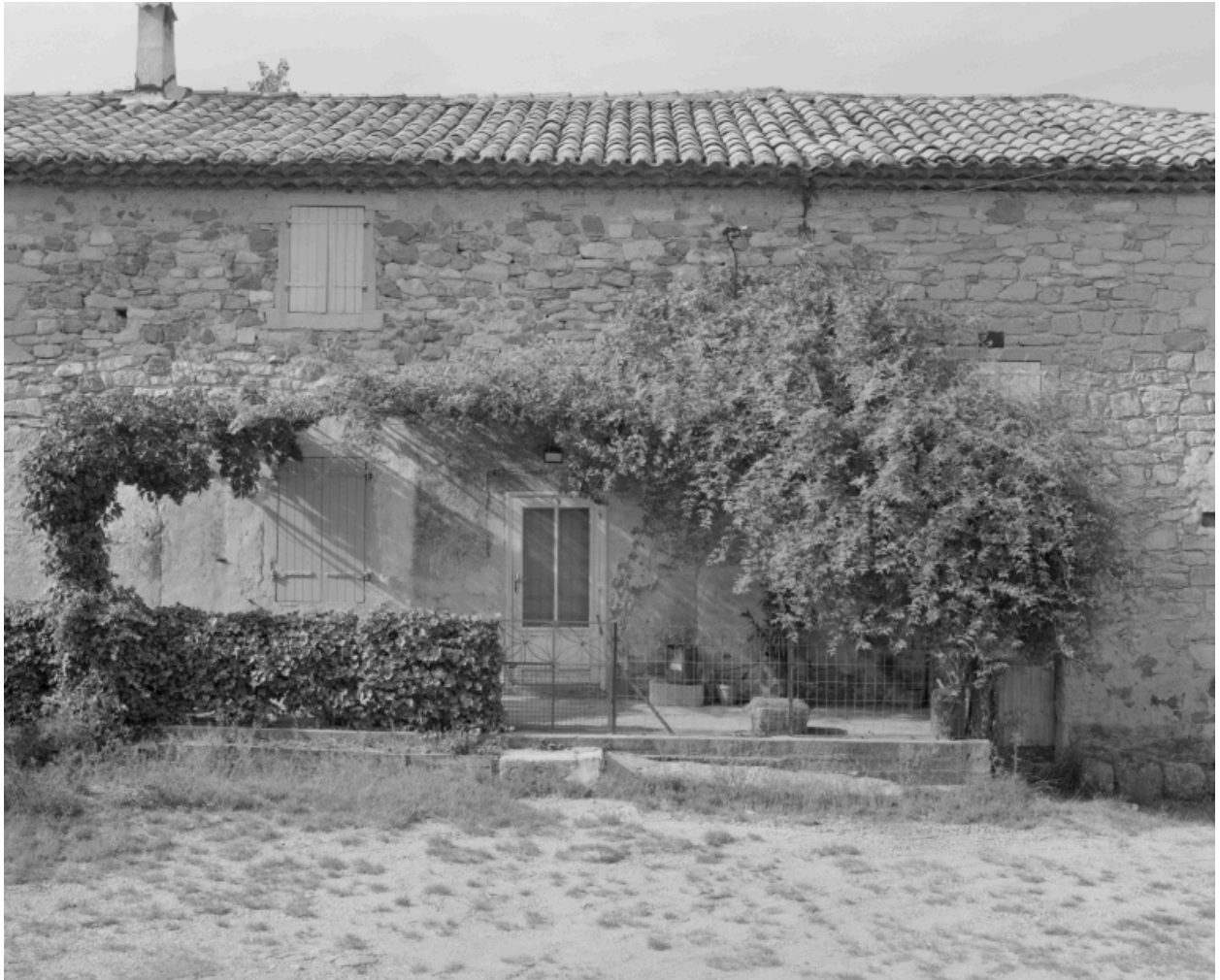
Vue partielle de la ferme (A2 303).
