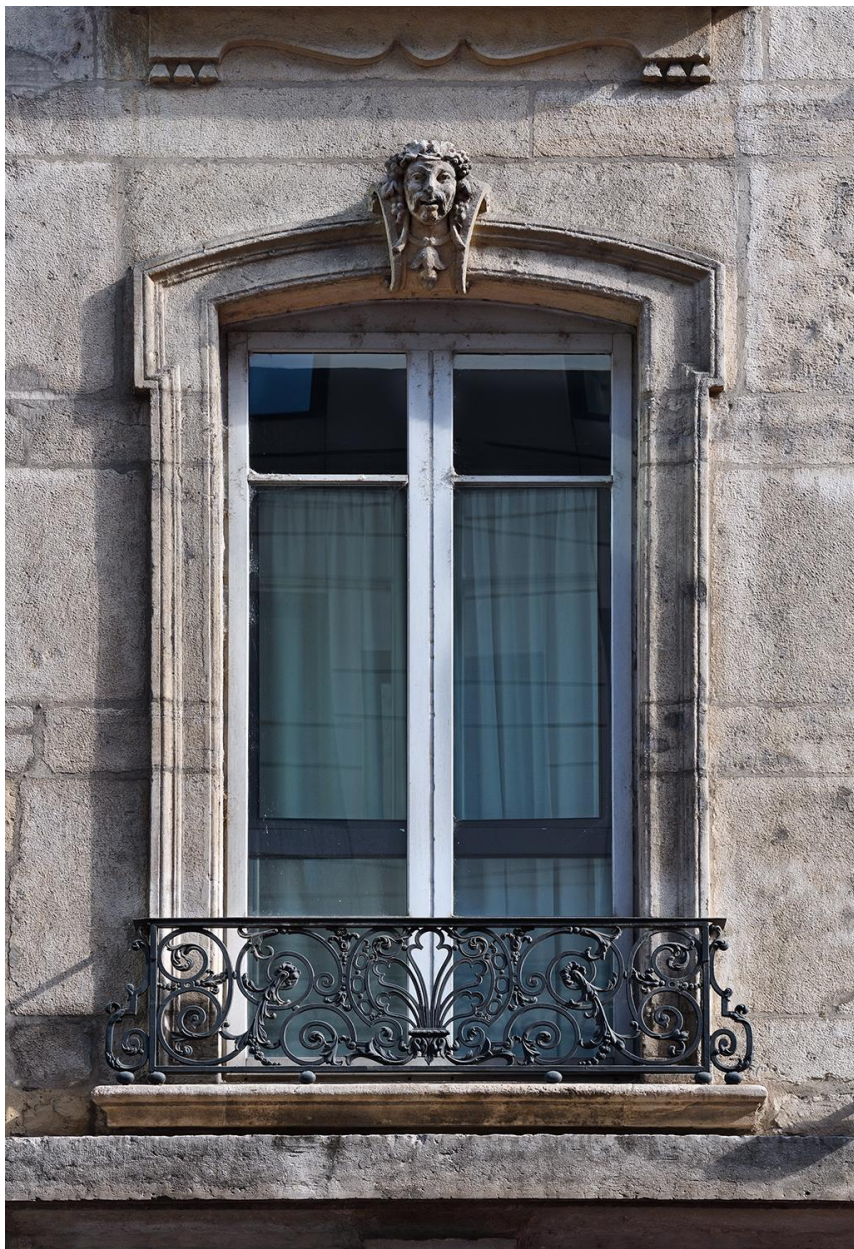
Détail d'une baie du premier étage carré
