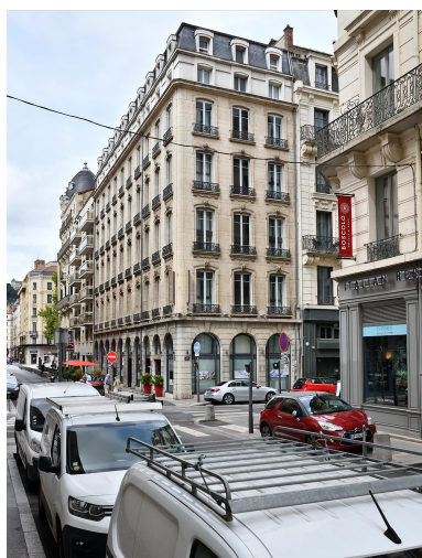
Elévation rue Grôlée Phot. Thierry Leroy IVR84_20256901332NUCAQ
