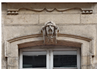
Rue Stella, premier étage carré : troisième agrafe sculptée à partir de la gauche Phot. Thierry Leroy IVR84_20256901356NUCA
