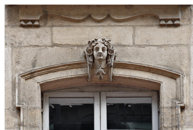
Rue Stella, premier étage carré : quatrième agrafe sculptée à partir de la gauche Phot. Thierry Leroy IVR84_20256901354NUCA
