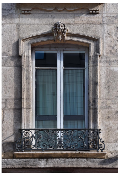
Détail d'une baie du premier étage carré Phot. Thierry Leroy IVR84_20256901334NUCA
