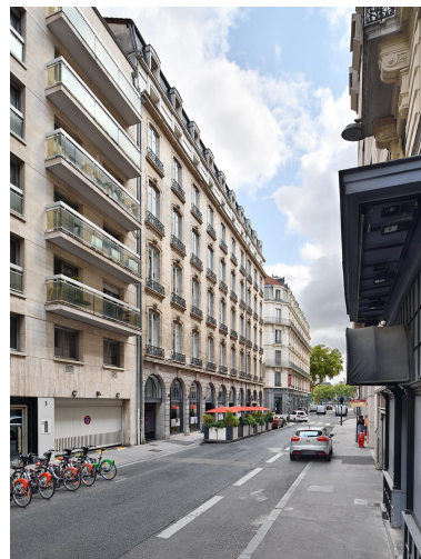
Elévation rue Jacques-Stella Phot. Thierry Leroy IVR84_20256901328NUCAQ
