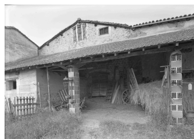
Elévation arrière de la ferme, mur pignon du logis ancien et porte de la cave. Phot. Jean-Marie Refflé IVR82_20014200217P
