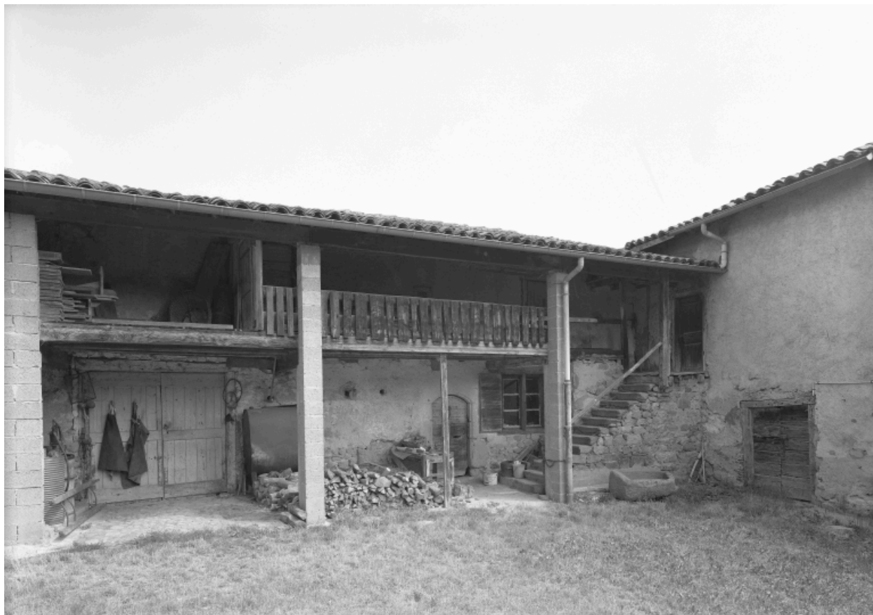
Vue d'ensemble du logis ancien à aître, depuis la cour.
