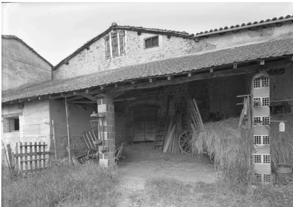
Elévation arrière de la ferme, mur pignon du logis ancien et porte de la cave.
