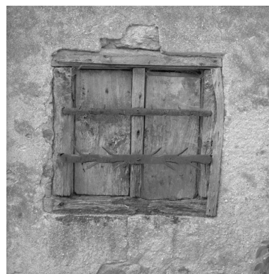
Elévation latérale gauche de la ferme, détail de la fenêtre de la cave. Phot. Jean-Marie Refflé IVR82_20014200220X
