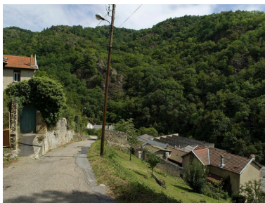
La rue dans sa partie basse, en direction de la vallée des usines. Phot. Jean-Michel Périn IVR83_20116301018NUC4A
