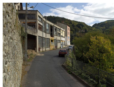
Vue partielle de la rue en direction de la vallée de la Durolle. Phot. Jean-Michel Périn IVR83_20116301183NUC4A
