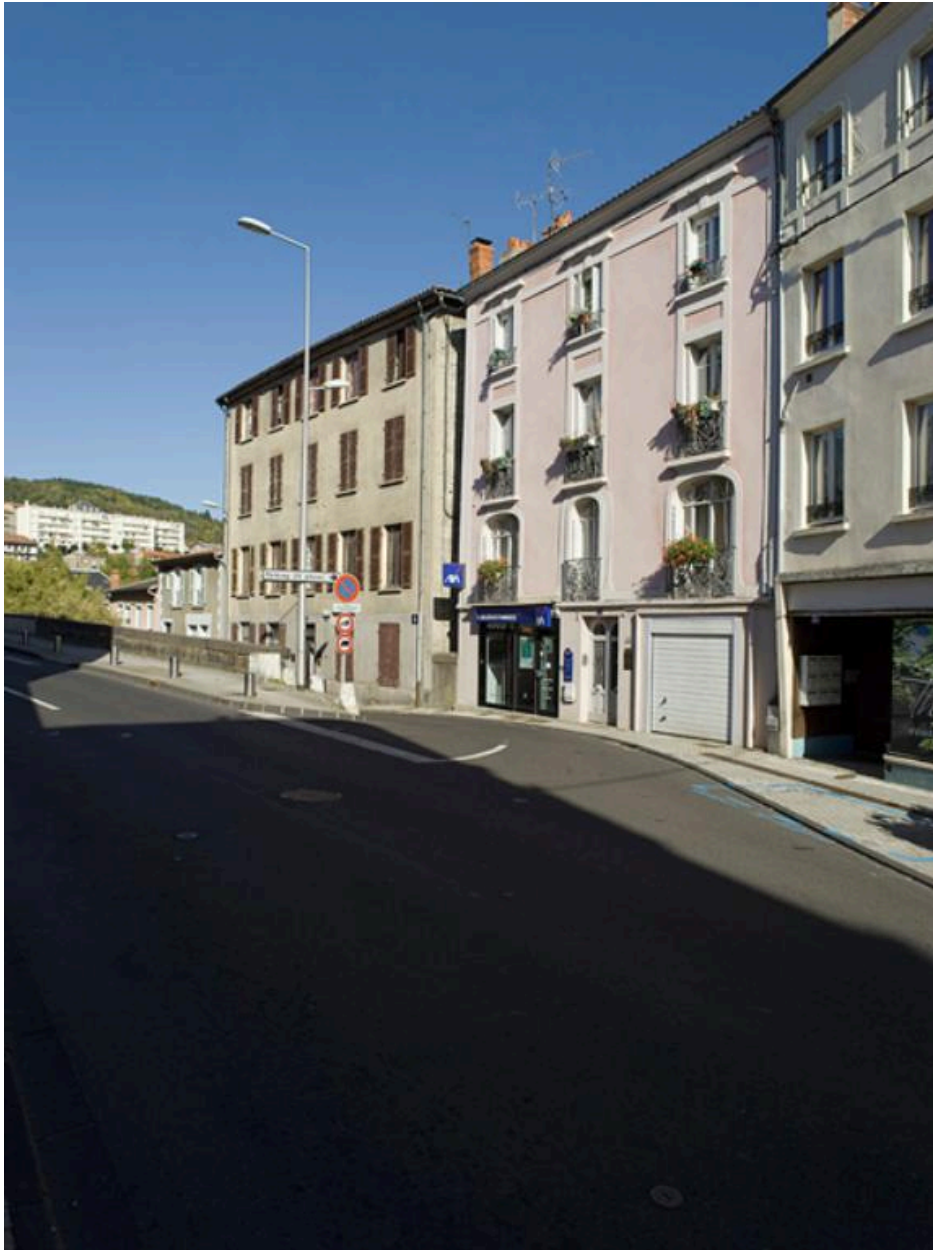
Immeubles du haut de la rue.
