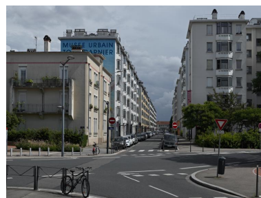
Vue d'un immeuble prototype (2 étages) Phot. Thierry Leroy IVR84_20186900848NUCAQ
