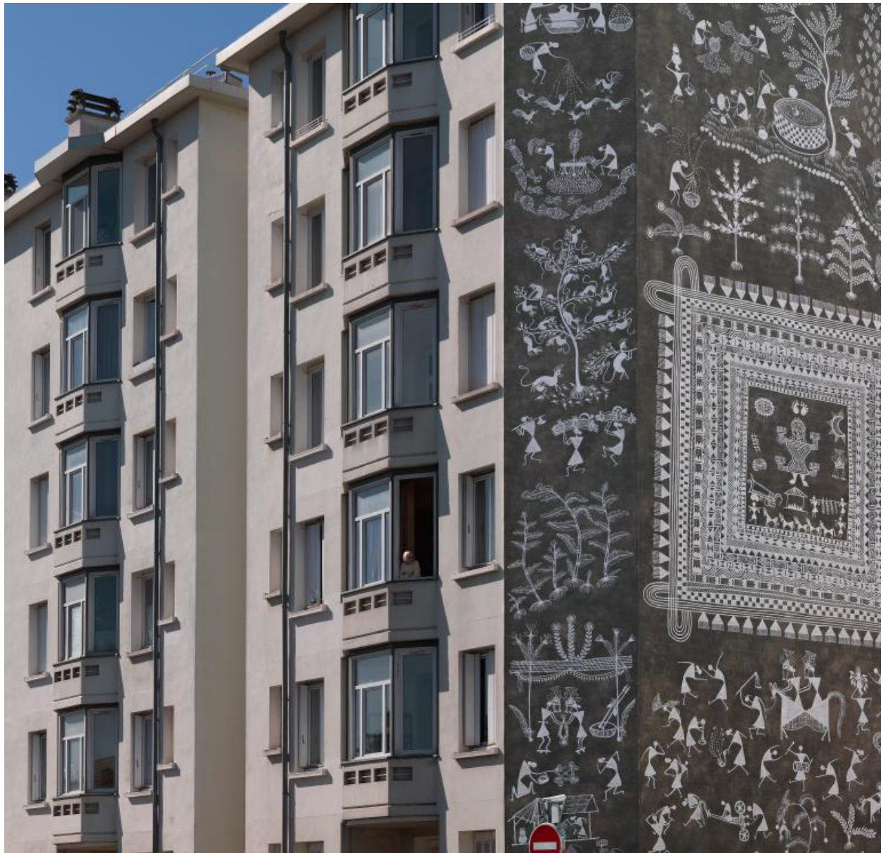
Détail façade avec pignon peint
