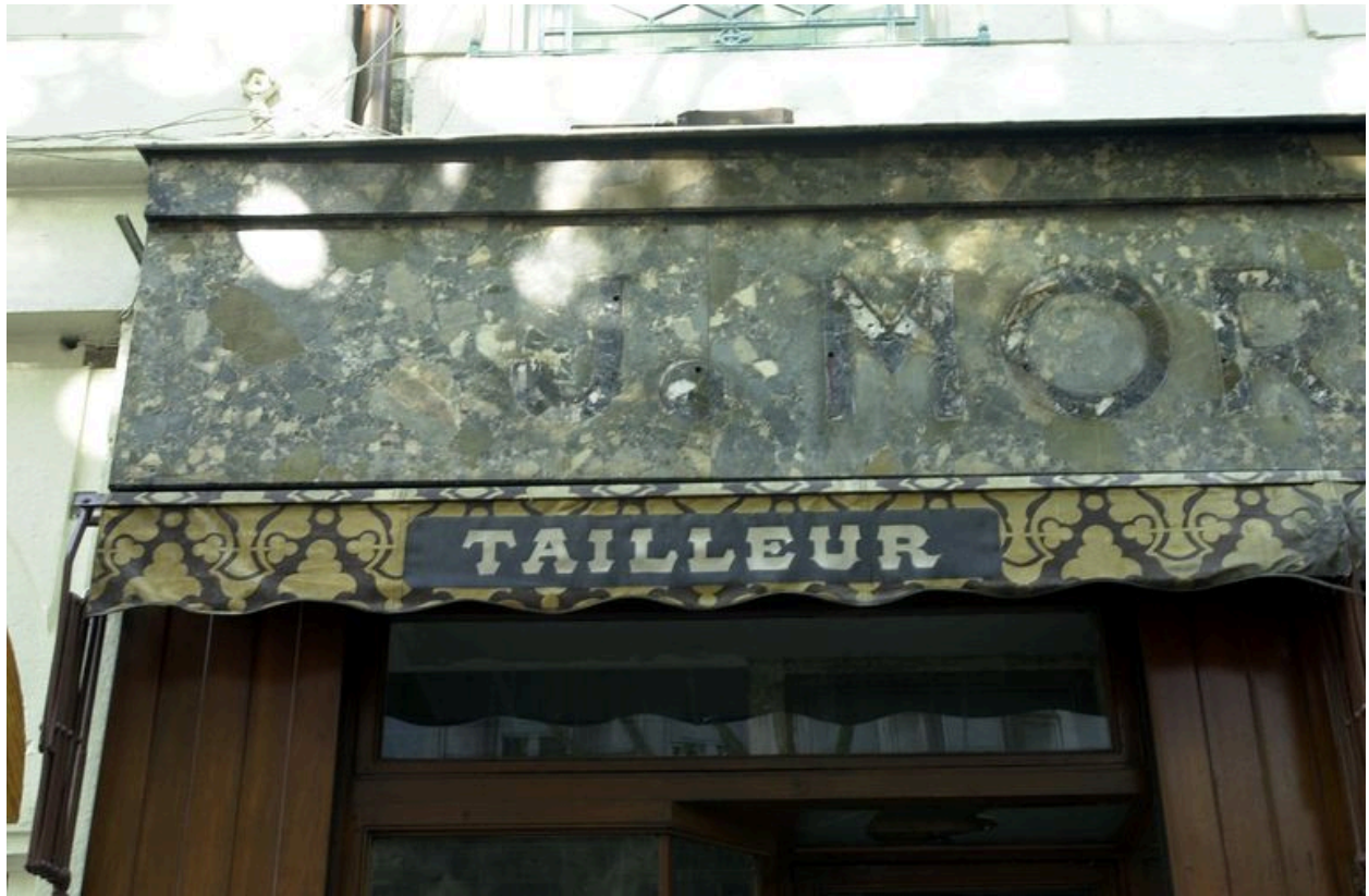
Devanture de boutique : détail de la partie supérieure
