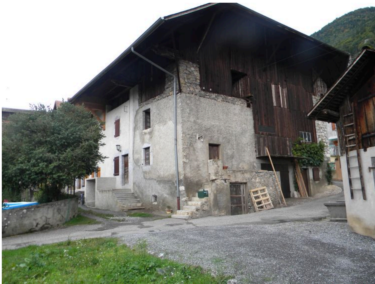
Vue de trois-quarts d'une ancienne ferme (2008 B4 462, 463, 464, 465).
