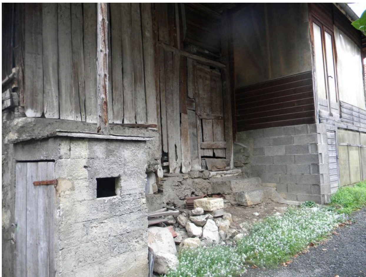
Vue du pignon nord d'un ensemble de 5 fermes mitoyennes (2008 B4 466, 467, 468, 469, 1593, 1734).
