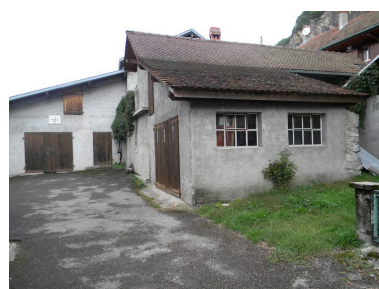
Vue d'un hangar aménagé sur du bâti ancien (2008 B4 500,501).
