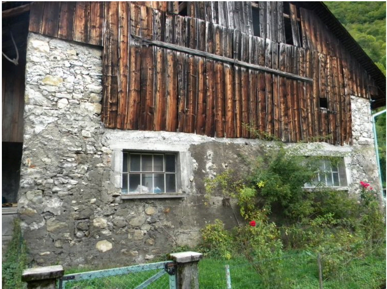
Vue d'une ancienne grange accolée à un atelier (2008 B4 1768).
