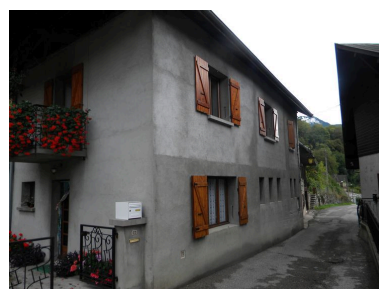
Vue d'une ancienne ferme très transformée au coeur du hameau. Phot. Jérôme Daviet IVR82_20127403169NUCA
