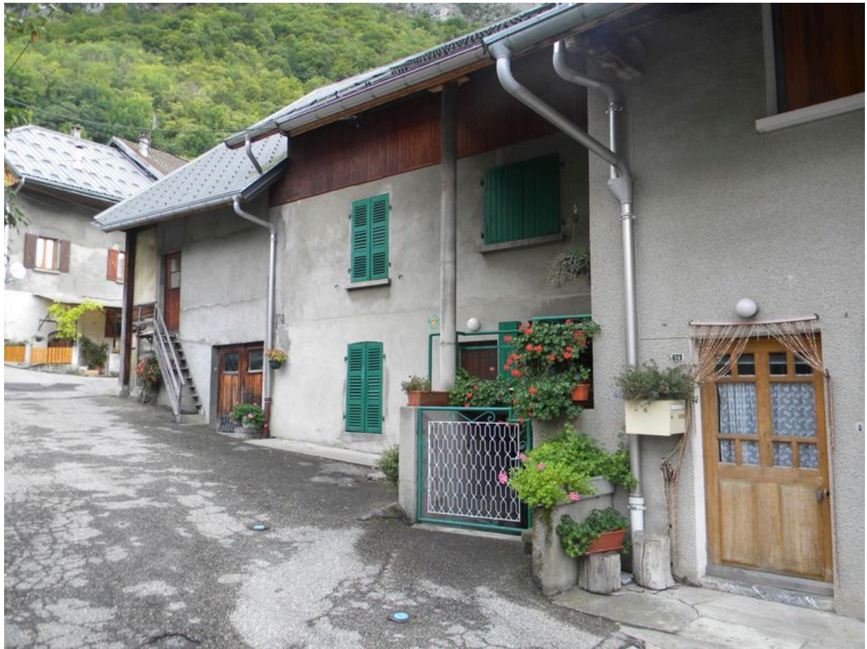
Vue de la partie ouest très remaniée d'un ensemble de 5 fermes. (2008 B4 466, 467, 468, 469, 1593, 1734).
