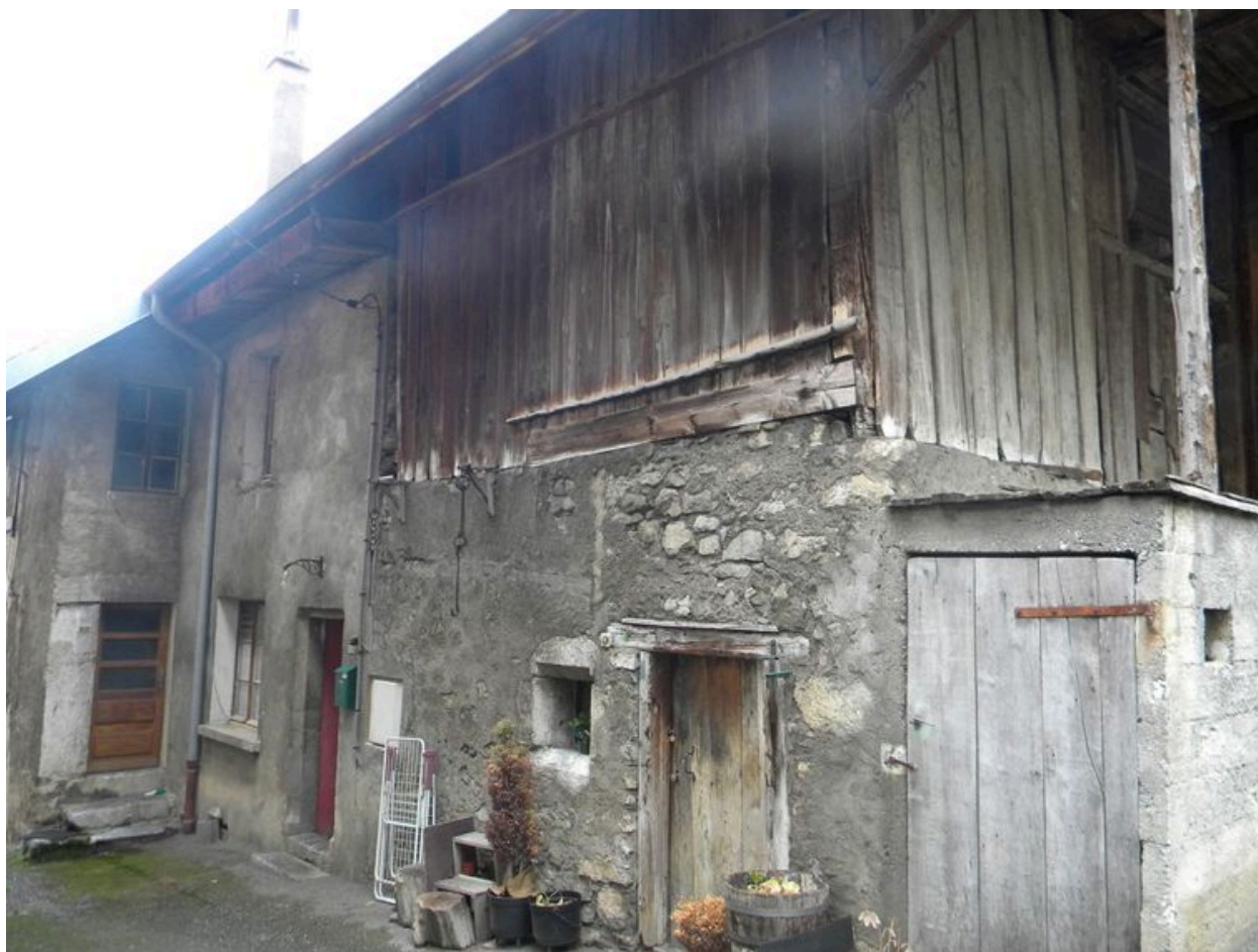
Vue de la façade est d'un ensemble de 5 fermes mitoyenes (2008 B4 466, 467, 468, 469, 1593, 1734).
