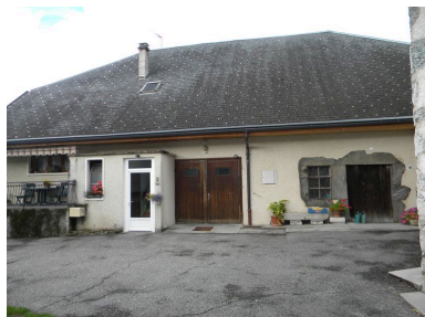
Façade principale d'une ancienne ferme présentant un imposant piedroit commun entre la porte et la fenêtre de l'étable (2008 B4 1636). Phot. Jérôme Daviet IVR82_20127403185NUCA
