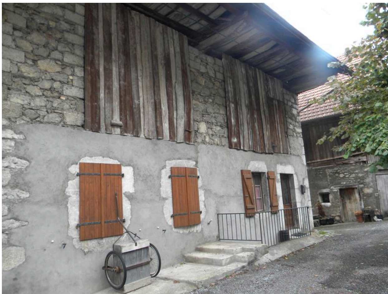
Vue de façade nord d'une ancienne ferme (2008 B4 462, 463, 464, 465)
