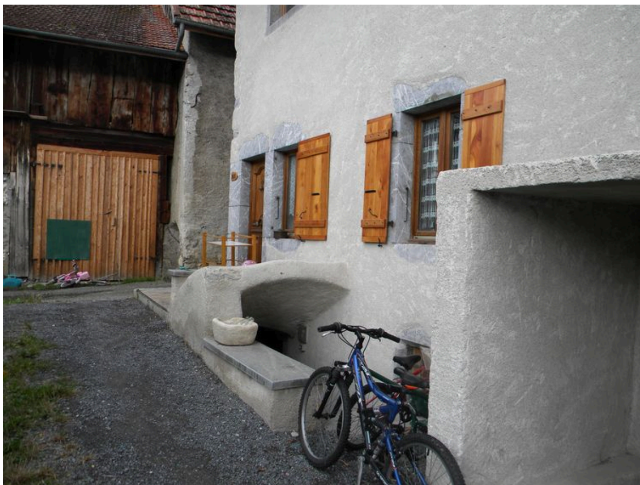
Vue d'un accès à une cave souterraine en façade sud d'une ancienne ferme (2008 B4 462, 463, 464, 465).
