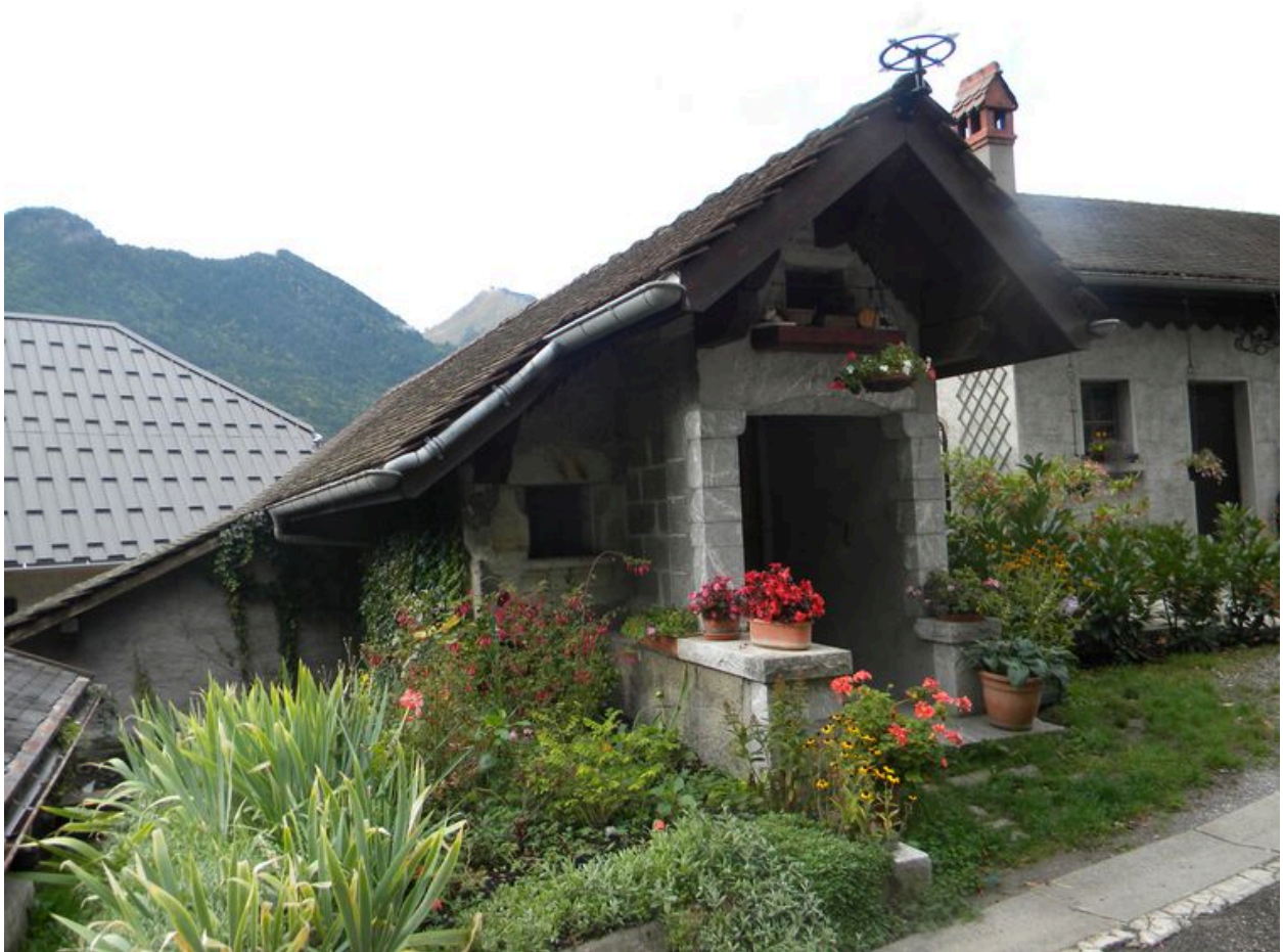
Vue d'un aménagement pastiche sur une ancienne grange (2008 B4 1657)
