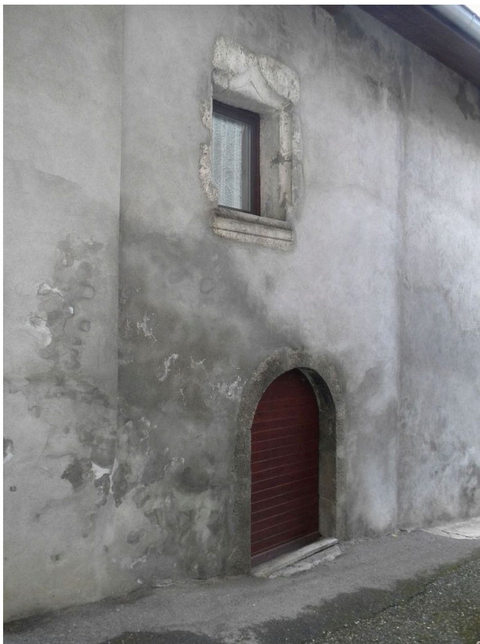
Vue d'encadrements anciens sur la façade ouest d'une maison (2008 B4 444, 1793).
