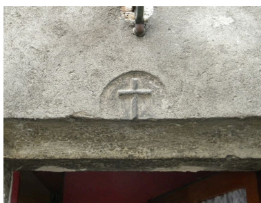
détail d'une croix gravée sur un linteau de porte en face est d'un ensemble de 5 fermes mitoyennes (2008 B4 466, 467, 468, 469, 1593, 1734).
