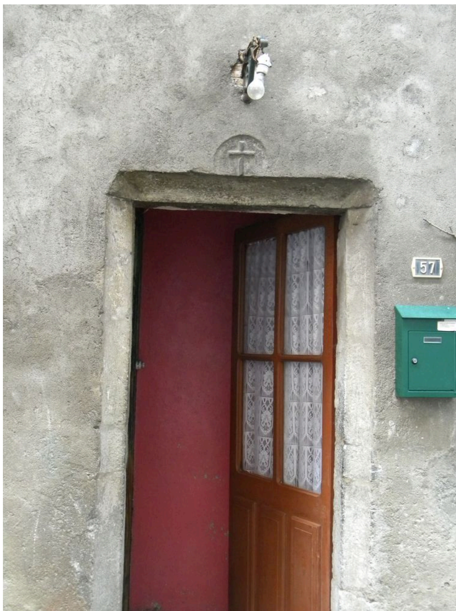
Vue d'un encadrement de porte chanfreiné sur la façade est d'un ensemble de 5 fermes mitoyennes (2008 B4 466, 467, 468, 469, 1593, 1734).
