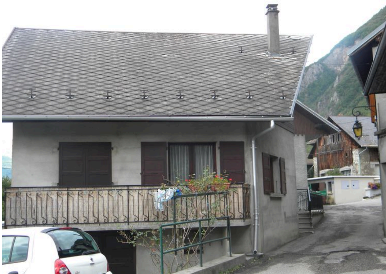
Vue de la façade est d'une maison conservant des encadrements anciens (2008 B4 444, 1793).
