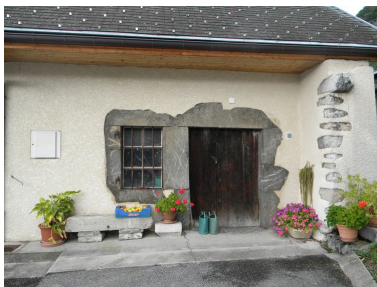
Imposant piedroit commun entre la porte et la fenêtre de l'étable d'une ancienne ferme (2008 B4 1636). Phot. Jérôme Daviet IVR82_20127403186NUCA
