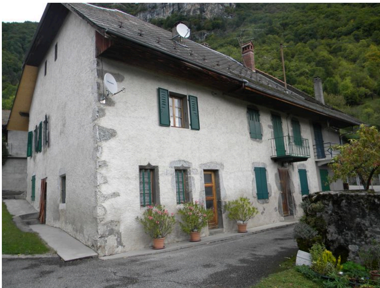
Façade principale d'une ancienne ferme avec encadrements en accolade (2008 B4 493, 494, 1698).
