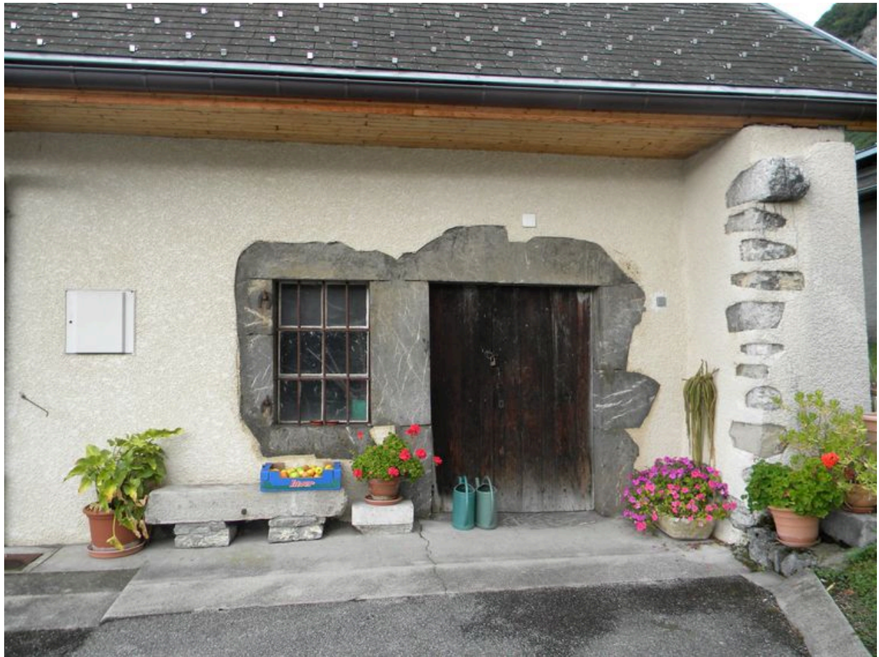
Imposant piedroit commun entre la porte et la fenêtre de l'étable d'une ancienne ferme (2008 B4 1636).
