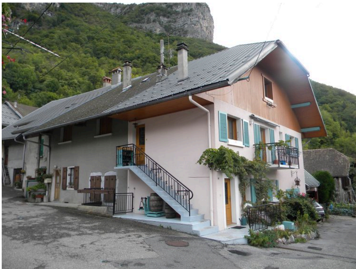
Vue des parties sud et ouest très remaniées d'un ensemble de 5 fermes. (2008 B4 466, 467, 468, 469, 1593, 1734).
