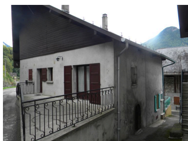
Vue de la face nord d'une ancienne maison conservant des encadrements anciens (2008 B4 444, 1793) Phot. Jérôme Daviet IVR82_20127403170NUCA
