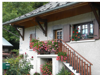
Vue de la partie logis d'une ancienne ferme transformée à l'entrée est du village (2008 C6 766, 744). Phot. Jérôme Daviet IVR82_20127403167NUCA
