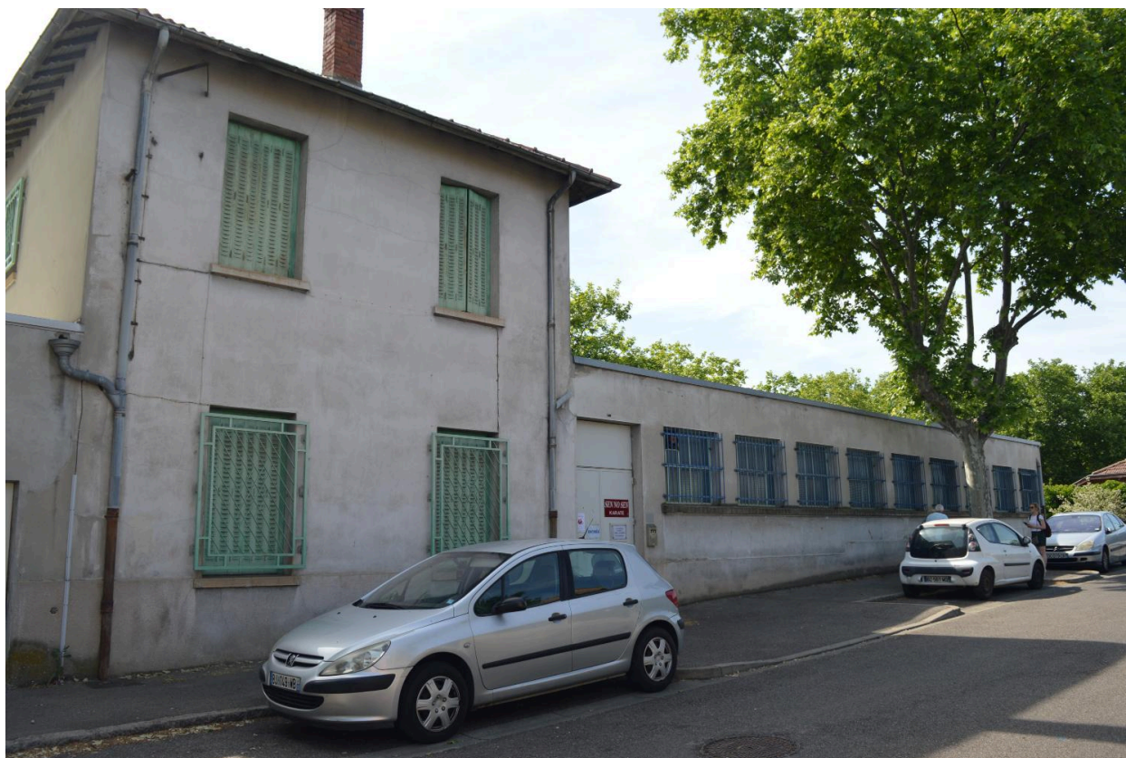
Anciens bains-douches et lavoir - Aujourd'hui gymnase du centre - Boulevard Laurent Gérin - face à la Maison du Peuple - 2022
