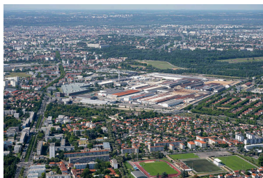
Usines Berliet, Renault Trucks, Vénissieux - Photographies aériennes 2020 (© Métropole de Lyon - Thierry FOURNIER) Phot. Thierry Fournier IVR84_20226900770NUCA
