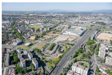
Grand Parilly, Vénissieux - Photographies aériennes 2020 (© Métropole de Lyon - Thierry FOURNIER) Phot. Thierry Fournier IVR84_20226901154NUCA
