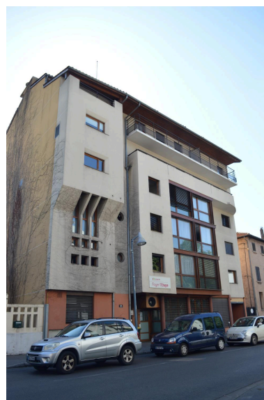
Immeuble du Foyer l'Etape de l'ADAPEI 69 - angle de l'Avenue Jean Jaurès et de l'Avenue Marcel Paul - 2022 Phot. Alice Giacobelli IVR84_20226901020NUCA
