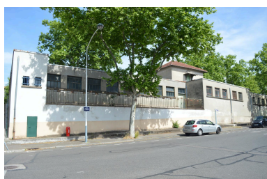
Anciens bains-douches et lavoir - Aujourd'hui gymnase du centre - Boulevard Laurent Gérin - face à la Maison du Peuple - 2022
