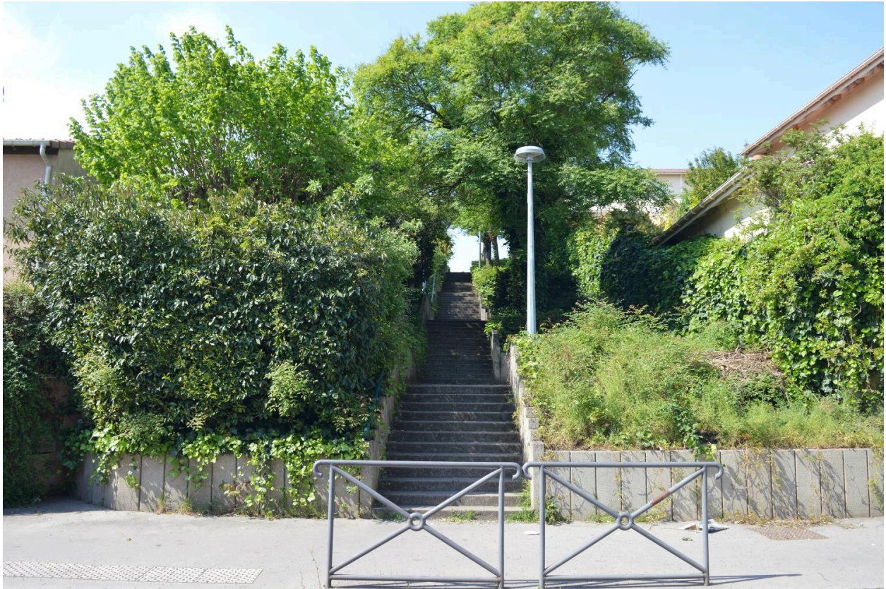
Escaliers de la rue Catherine Chaponay depuis la rue de l'ancienne gare - 2022
