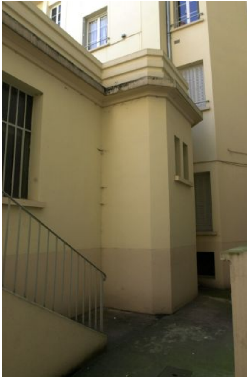
Vue du petit bâtiment construit dans la cour
