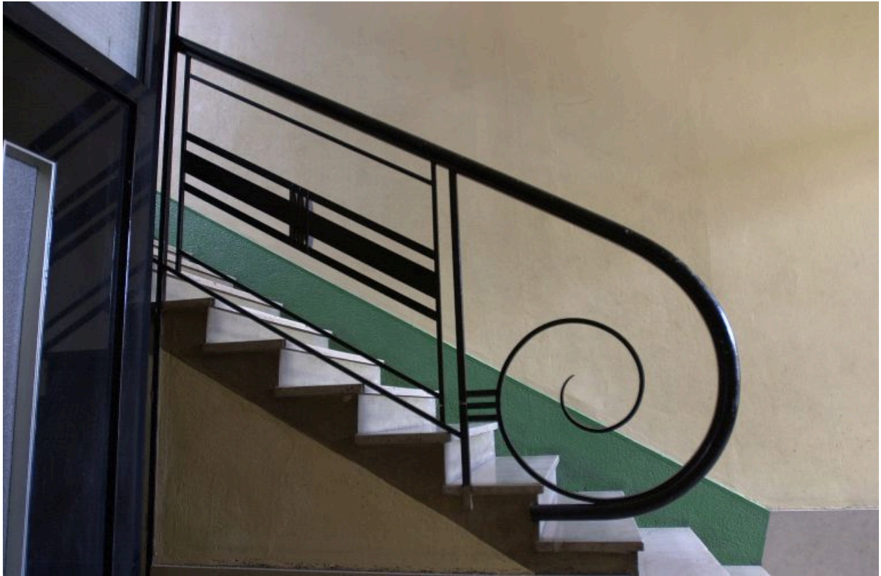
Détail de la rampe d'escalier, 21-23 rue Casimir-Perier
