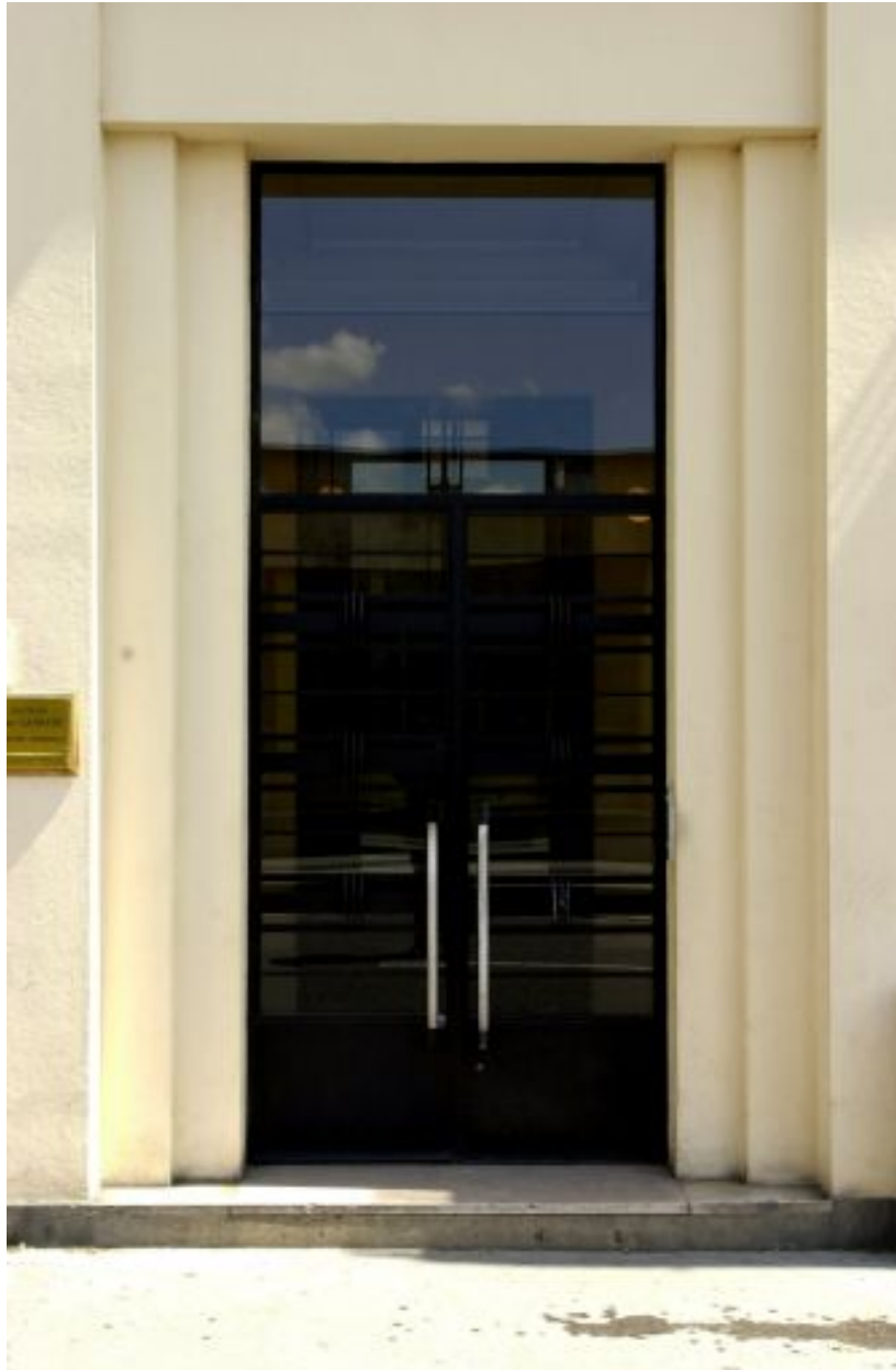
Porte d'entrée, 21-23 rue Casimir-Perier
