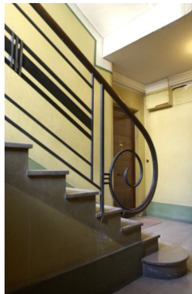
Détail de la rampe d'escalier, 54 rue Smith Phot. François Blanchetière IVR82_20016901975NUCA
