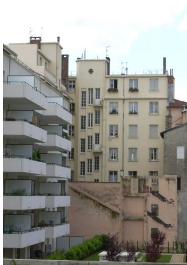
Elévation postérieure du 21-23 rue Casimir-Perier depuis le 12 cours Bayard Phot. François Blanchetière IVR82_20016901967NUCA
