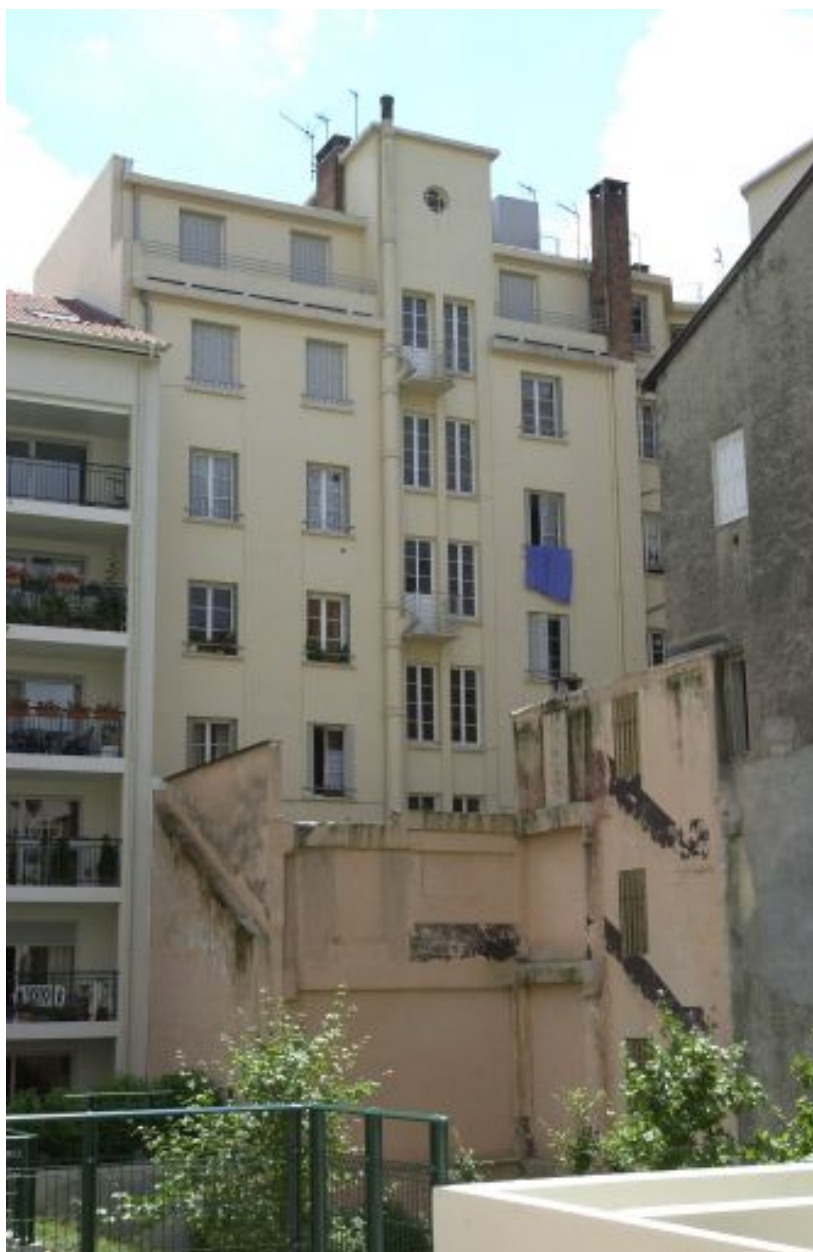
Elévation postérieure du 54 rue Smith
