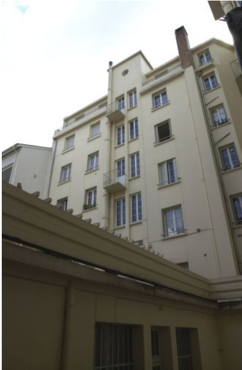
Elévation postérieure du 54 rue Smith, depuis la cour.
