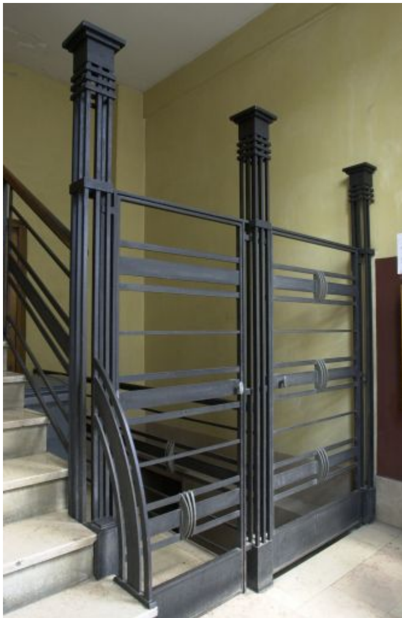
Détail de l'entrée du 54 rue Smith, les portes de la cave
