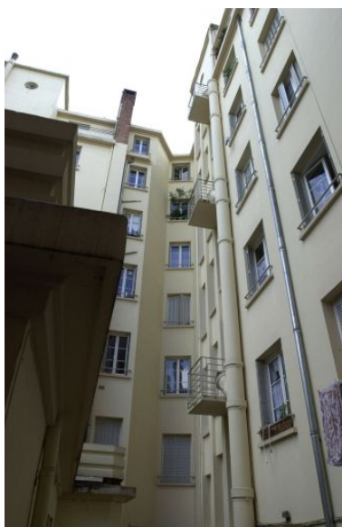
Vue de l'angle formé par les deux corps de bâtiment depuis la cour. Phot. François Blanchetière IVR82_20016901969NUCA
