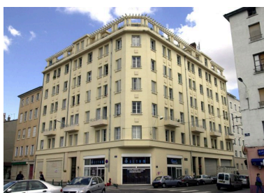
Vue générale, angle des rue Casimir-Perier et Smith Phot. François Blanchetière IVR82_20016901965NUCA
