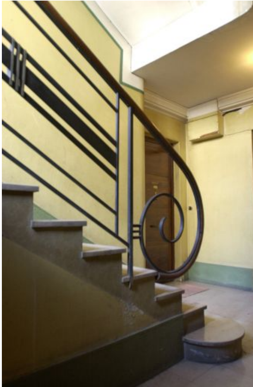
Détail de la rampe d'escalier, 54 rue Smith
