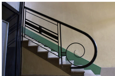
Détail de la rampe d'escalier, 21-23 rue Casimir-Perier Phot. François Blanchetière IVR82_20016901973NUCA
