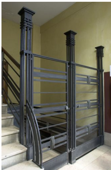
Détail de l'entrée du 54 rue Smith, les portes de la cave Phot. François Blanchetière IVR82_20016901974NUCA
