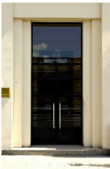
Porte d'entrée, 21-23 rue Casimir-Perier Phot. François Blanchetière IVR82_20016901966NUCA
