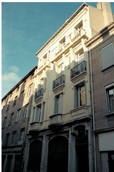
Façade principale. Etat en 1996 Phot. Cendrine Sanquer IVR82_19974201854ZE
