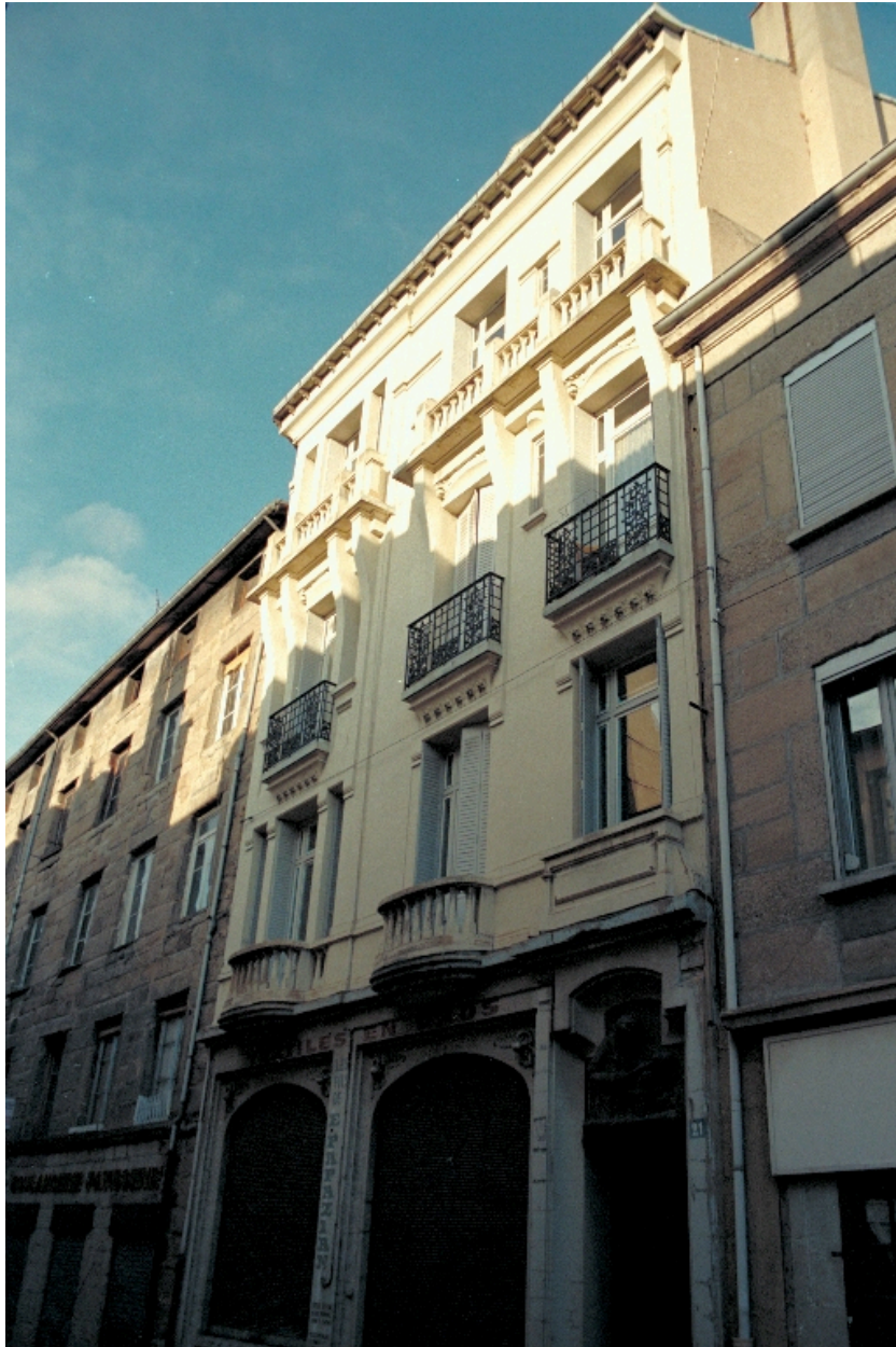
Façade principale. Etat en 1996
