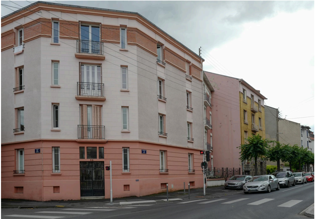
Façade sur le boulevard Jean-Jaurès. Irrégularité d'alignement au second plan.
