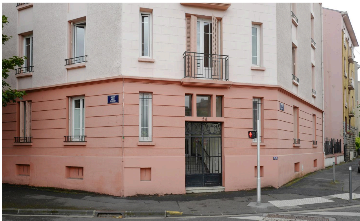
Détail d'architecture: rez-de-chaussée
