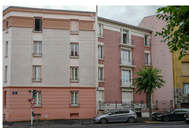
Façades sur le boulevard Jean-Jaurès Phot. François-Nicolas L'Hardy IVR84_20256301533NUCA
