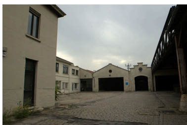
Ateliers et bâtiment administratif, vue sud-ouest Phot. Nadine Halitim-Dubois IVR82_20086900488NUCA
