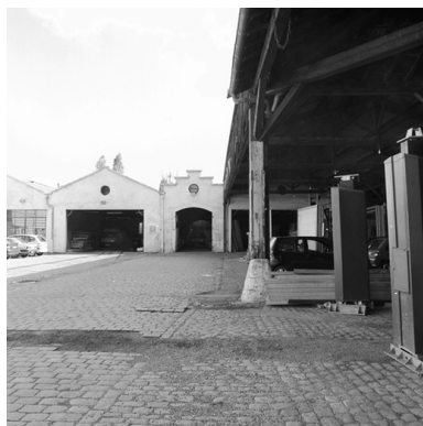
Vue générale ouest, fronton des ateliers et cour pavée Phot. Jean-Marie Refflé IVR82_20026904522X
