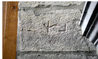
Marque de tâcheron, mur en revers de façade, à droite de la porte d'entrée Phot. Catherine Guégan IVR82_20136902006NUCA
