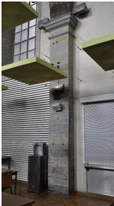
Pilastre, mur ouest Phot. Catherine Guégan IVR82_20136902007NUCA
