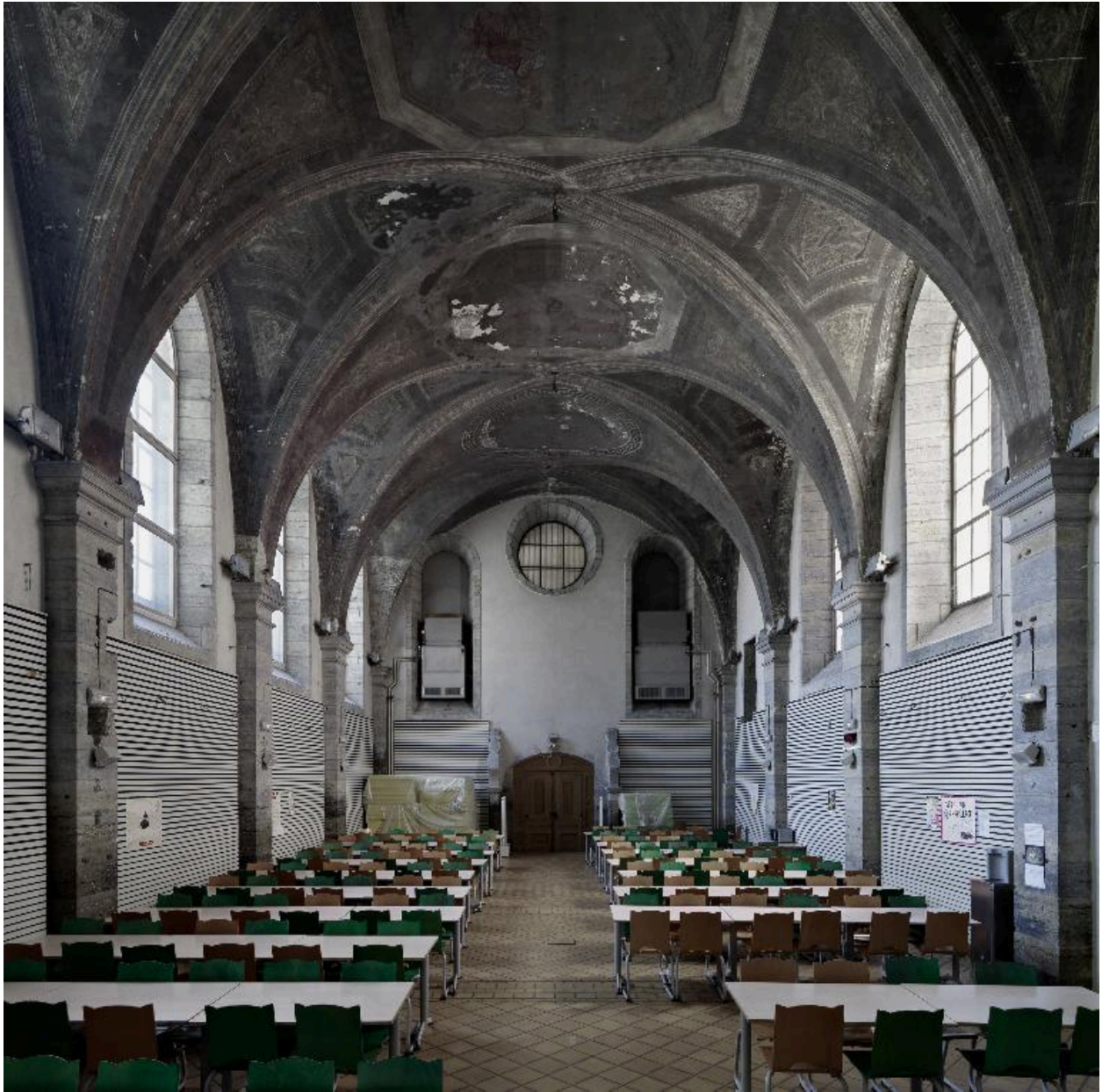
Vue d'ensemble depuis le chevet
