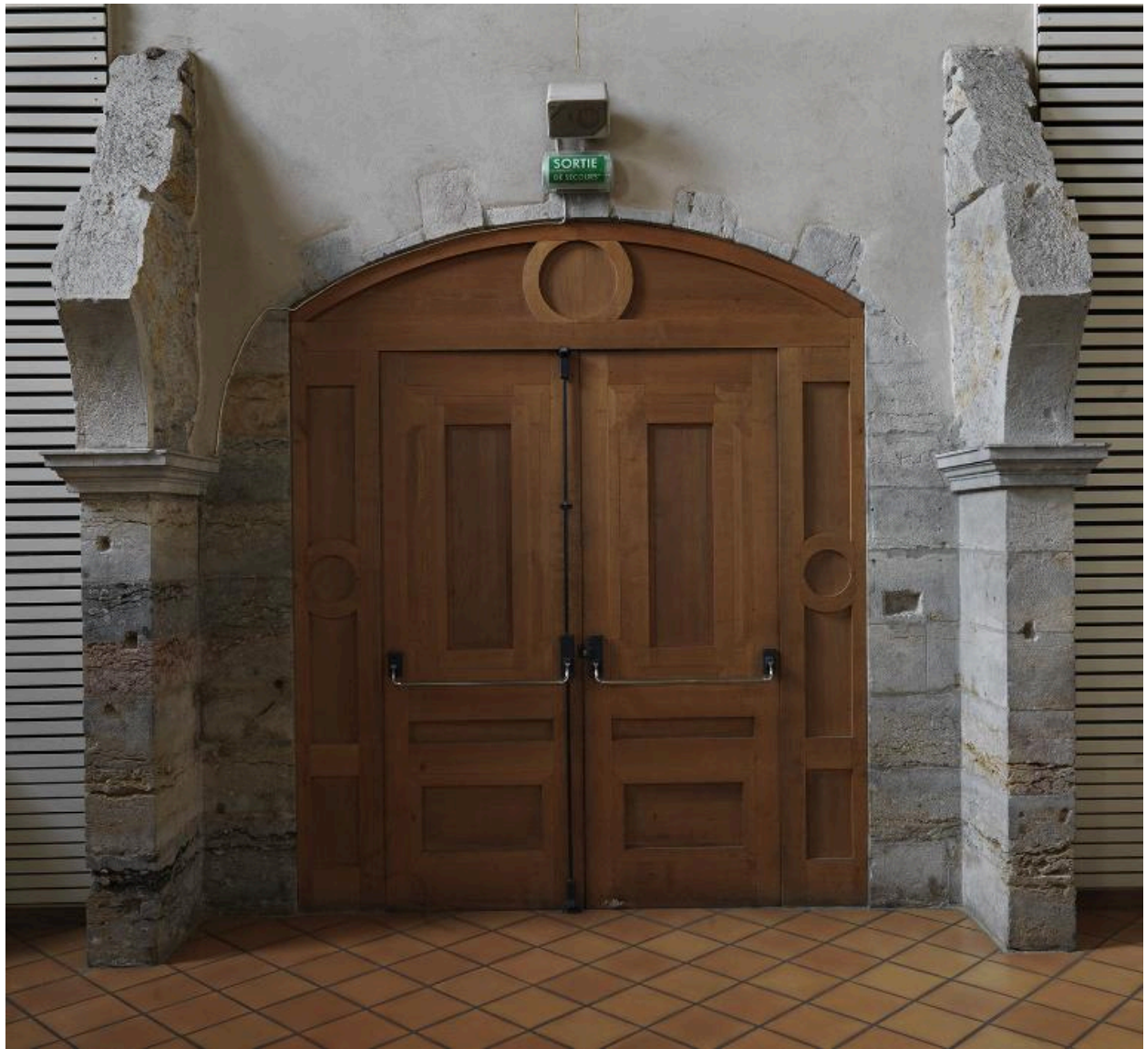
Porte d'entrée, vue intérieure
