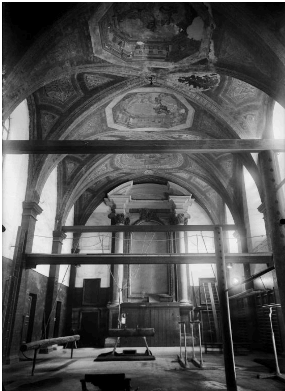
Vue du gymnase, 2e quart 20e siècle. Phot. P. Gélis (Médiathèque du patrimoine, Charenton-le-Pont, MH0123880)
