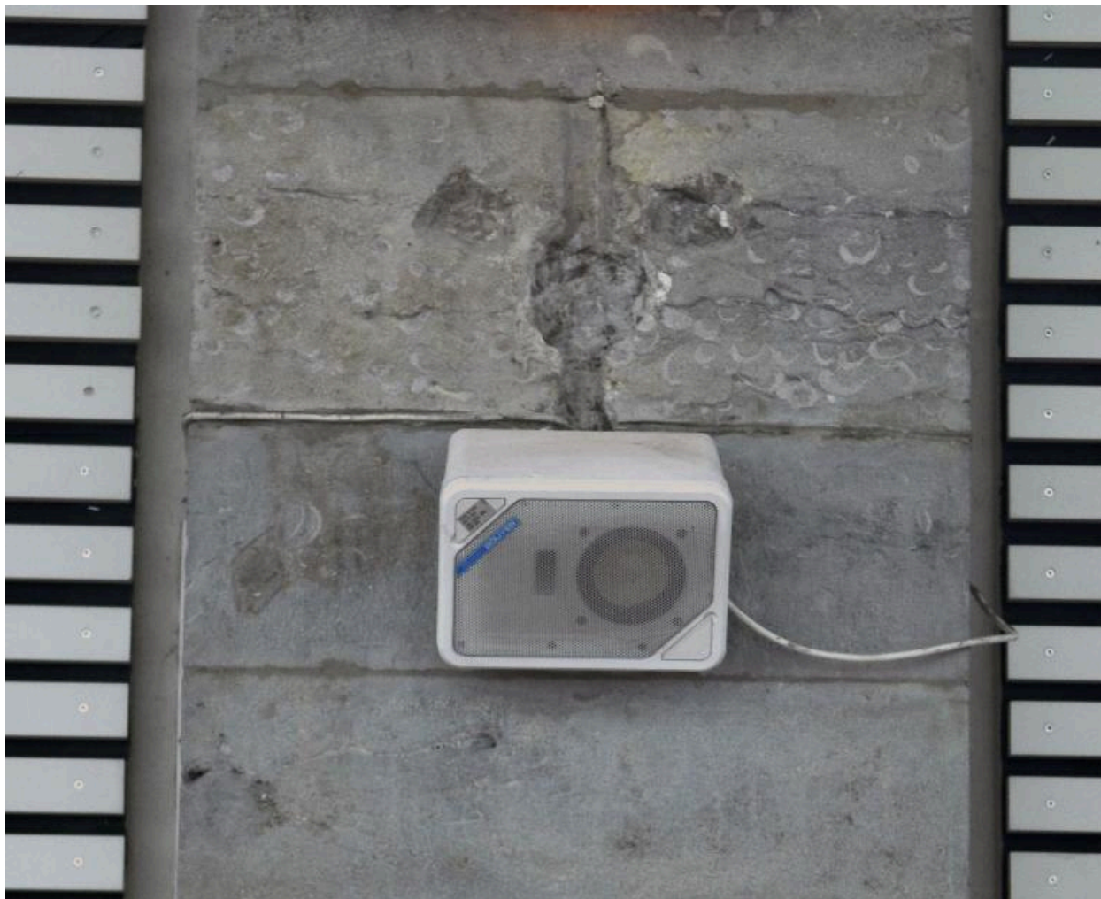
Mur de la nef, côté ouest : trace de l'arrachement des croix de consécration
