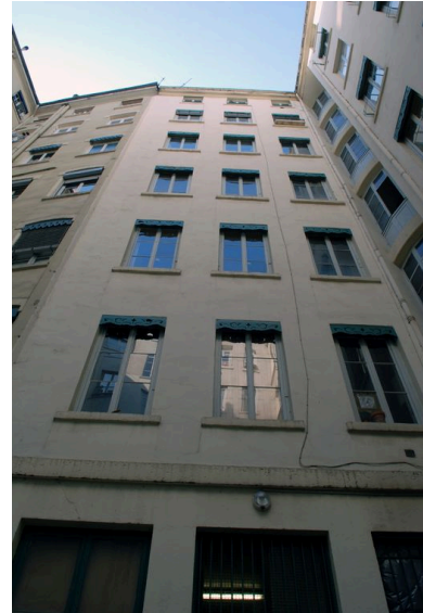
Elévation postérieure sud Phot. Catherine Guégan IVR82_20096900687NUCA
