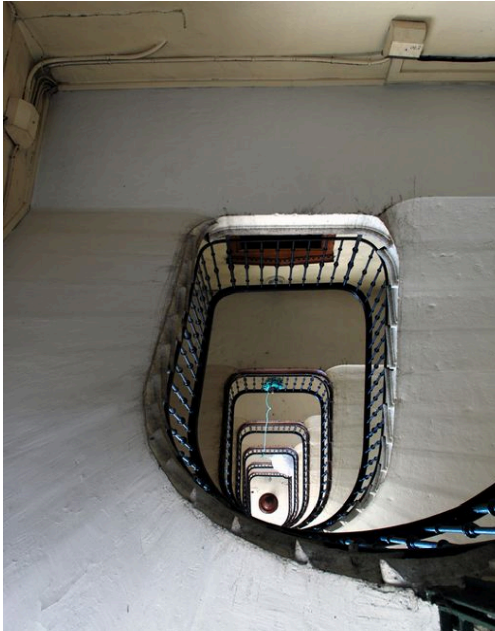
Vue de la cage d'escalier
