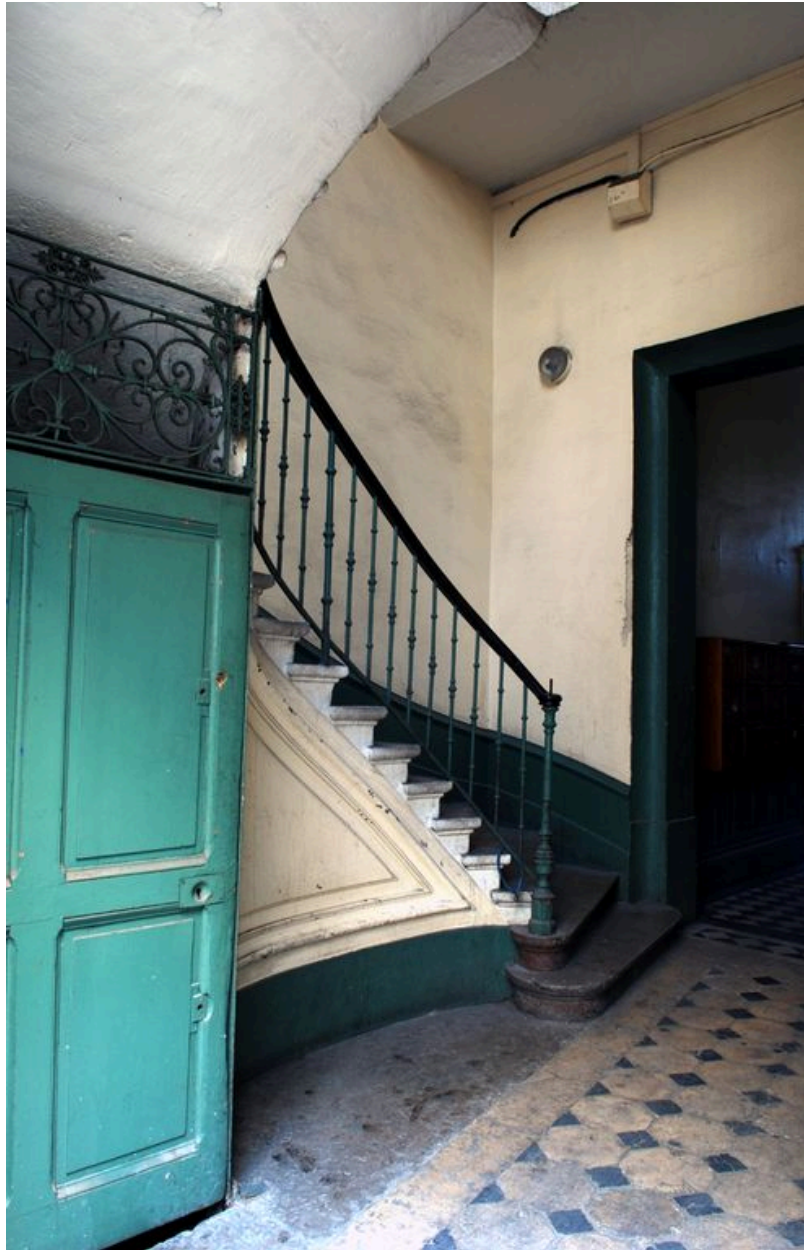
Première volée de l'escalier, depuis la cour
