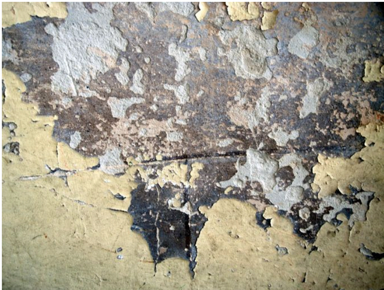
Cage d'escalier, détail du mur
