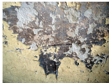
Cage d'escalier, détail du mur Phot. Catherine Guégan IVR82_20096900689NUCA
