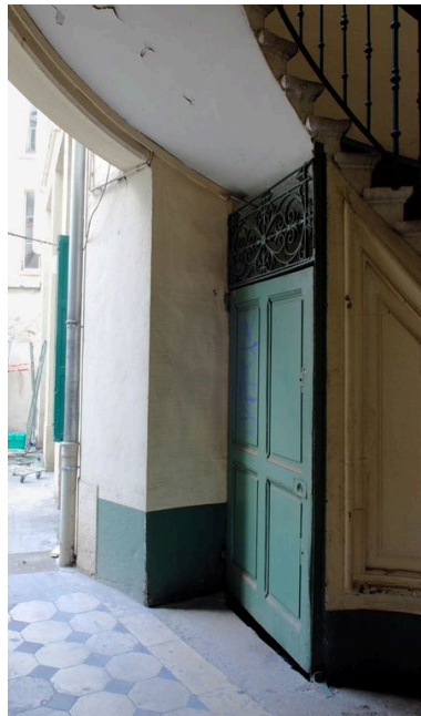
Porte d'accès aux caves Phot. Catherine Guégan IVR82_20096900684NUCA
