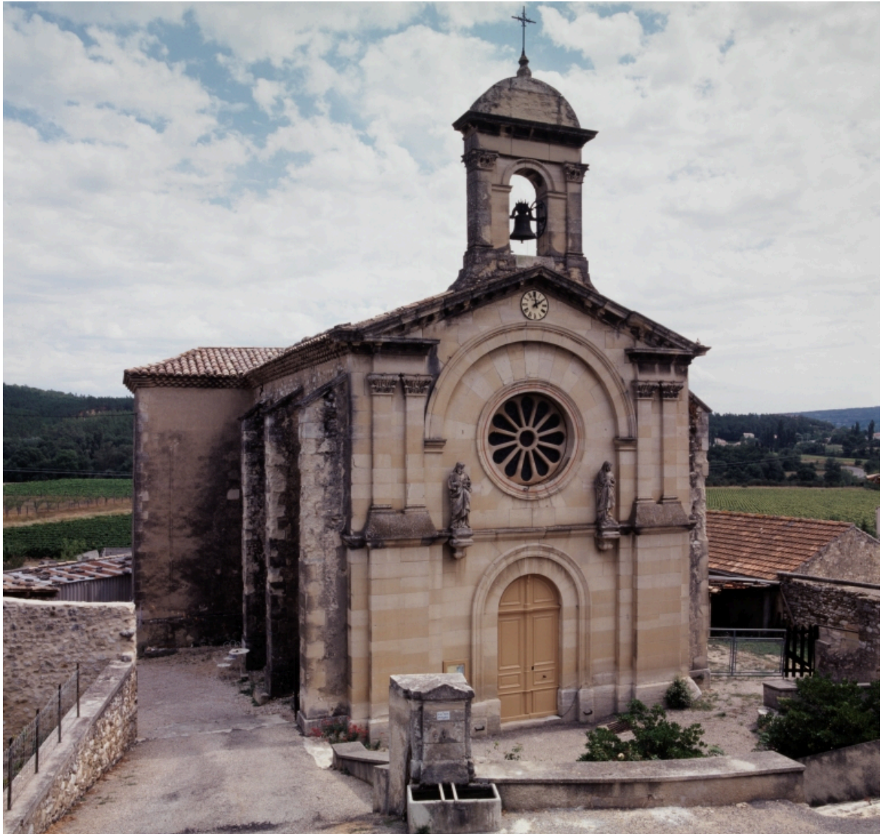
Façade et vue d'ensemble depuis l'ouest.
