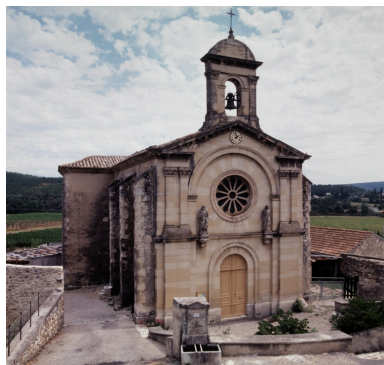
Façade et vue d'ensemble depuis l'ouest.
