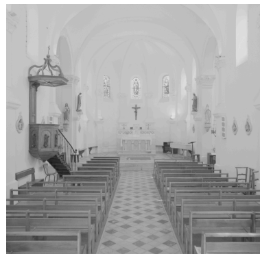
Vue d'ensemble depuis le fond de la nef.
